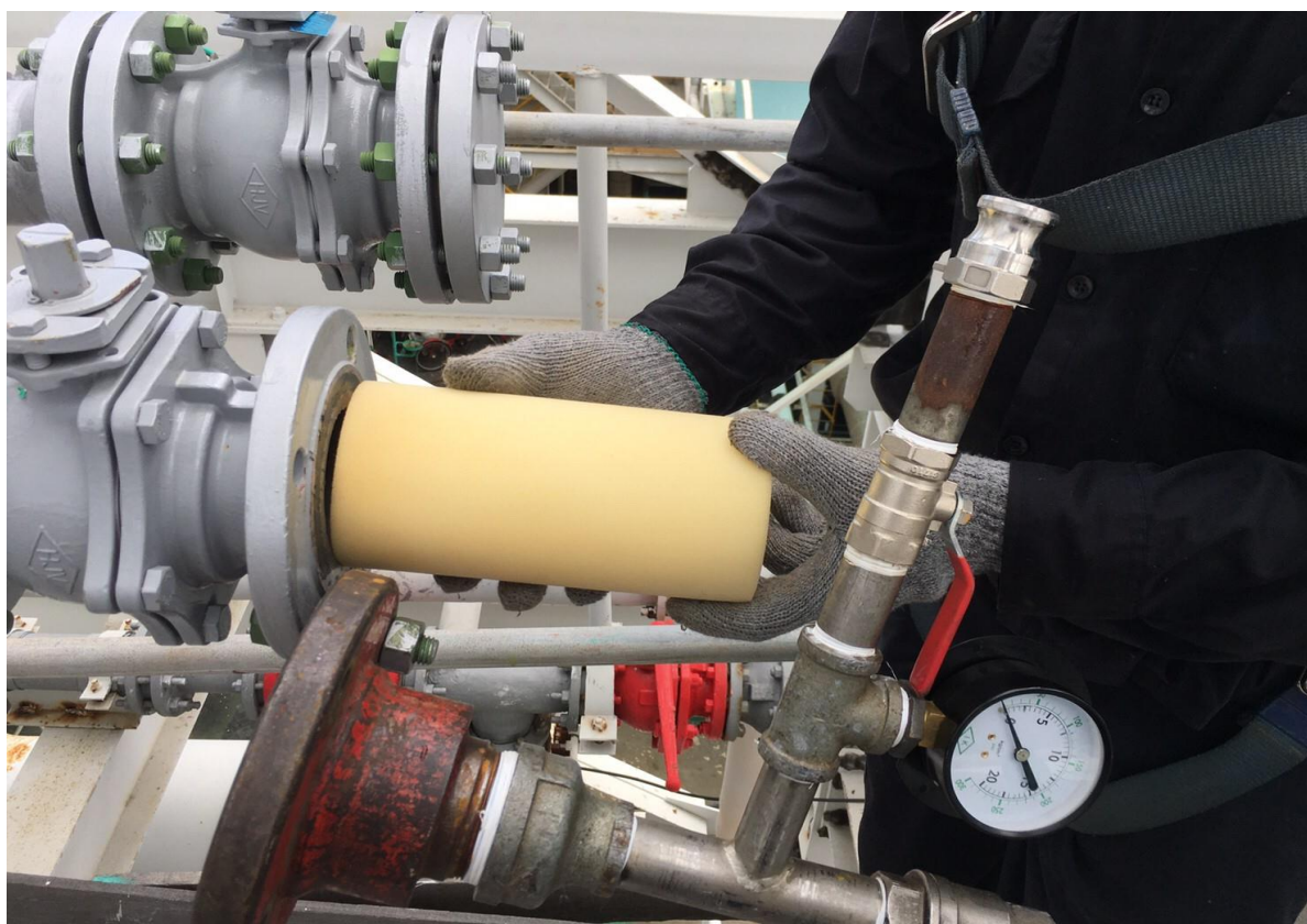
3. PIG 海綿安裝之情形(1)
