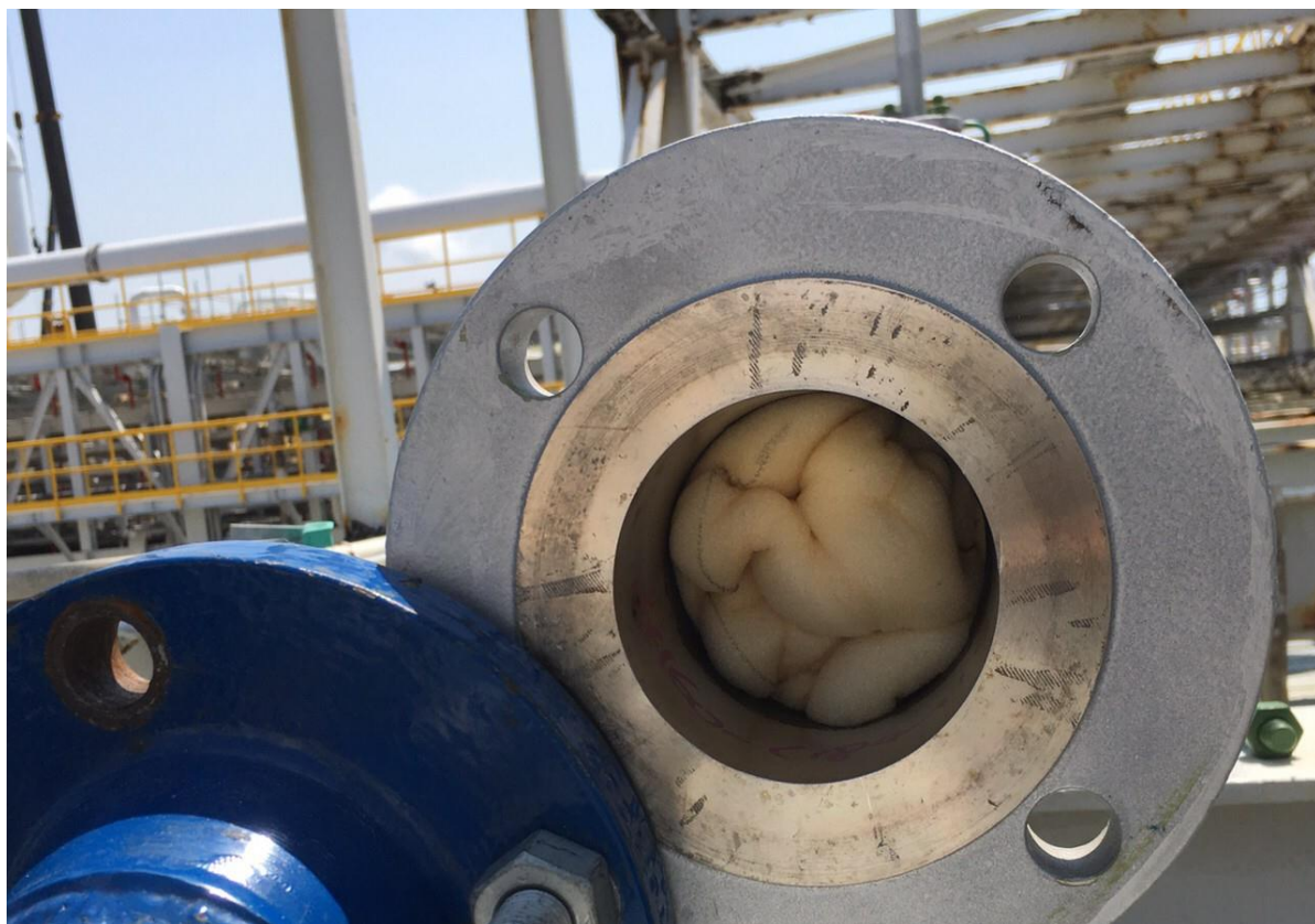
5. 2" PIG 海綿安裝之情形
