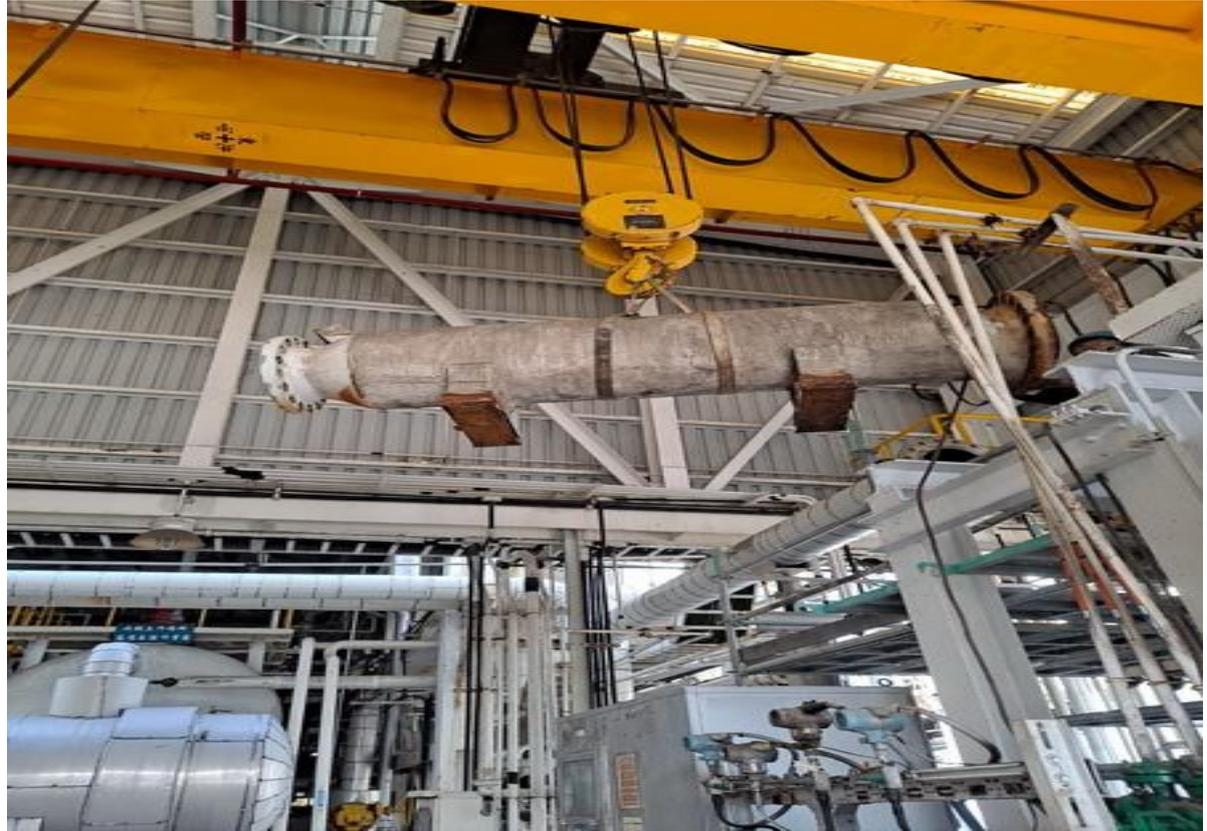
5. 短管吊裝移除作業
