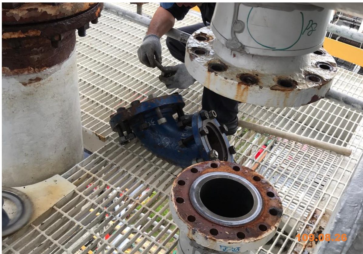
1. 熱交換器閥件拆卸(1)
