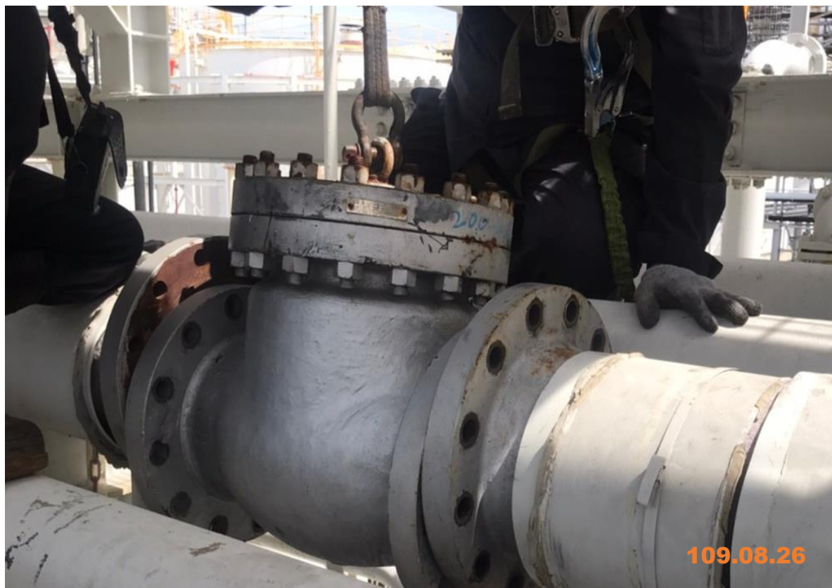
3. 人員拆除管架上三通
