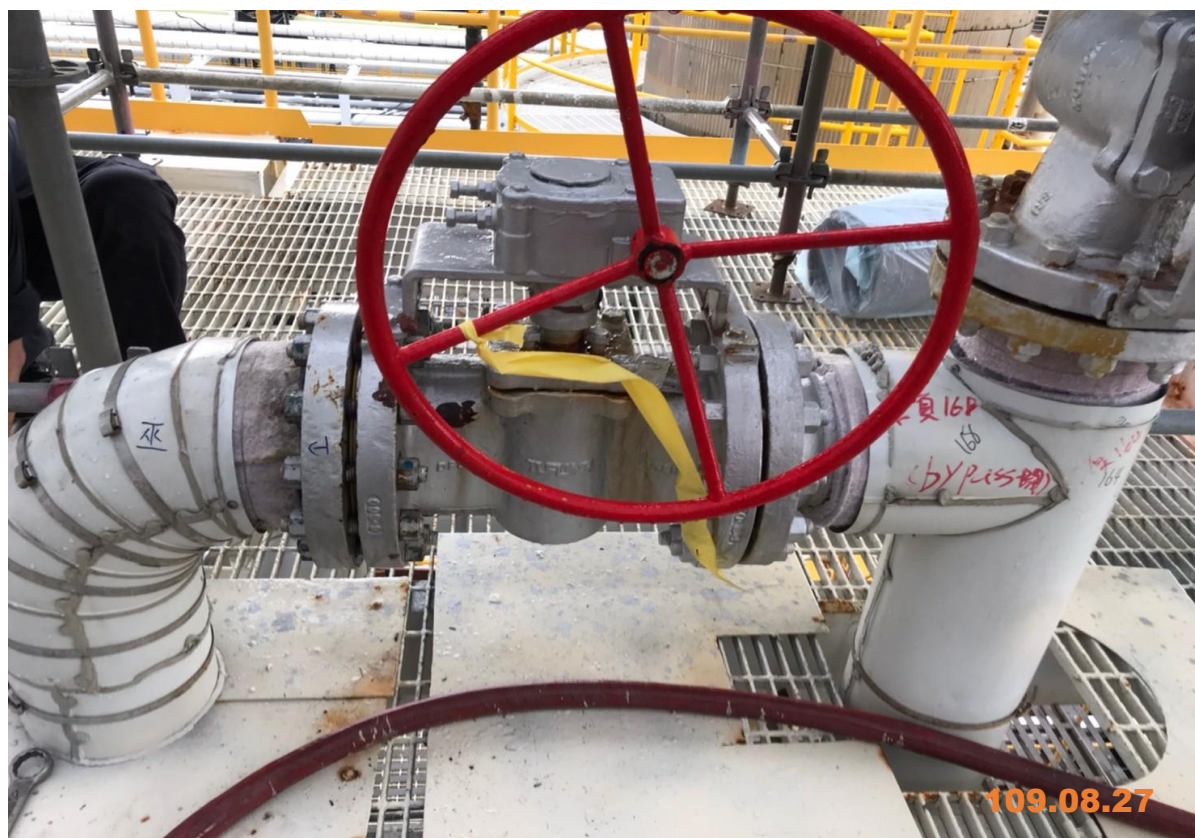
9. 管線復原情形(1)
