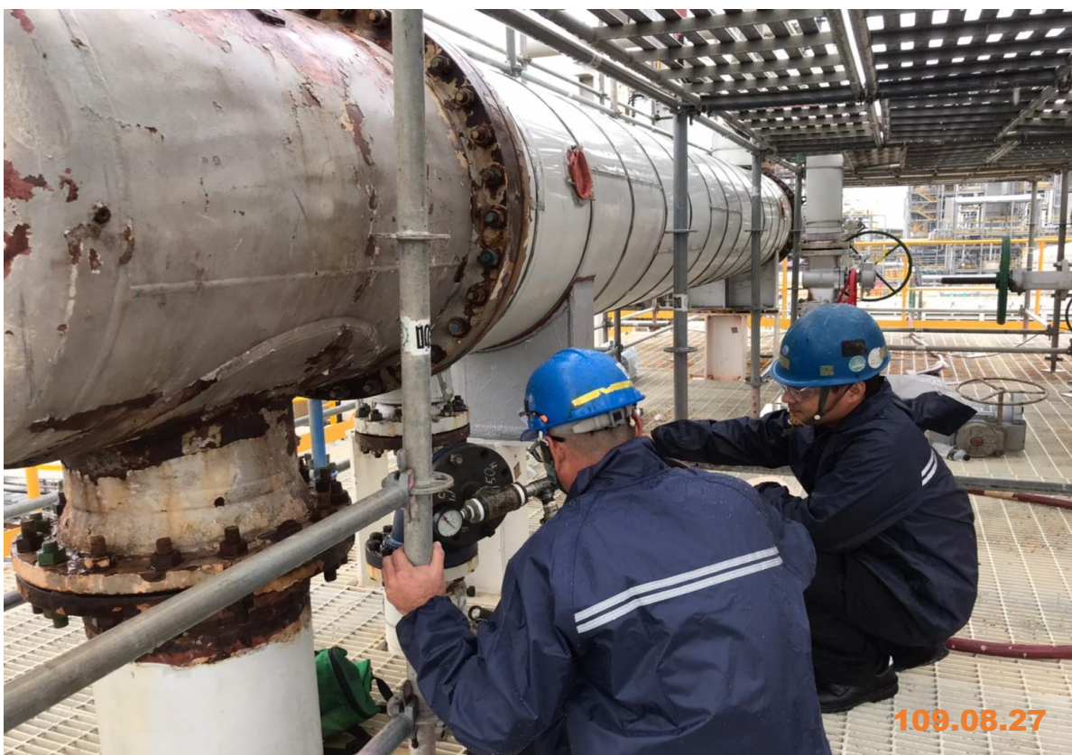
6. 人員發射端安裝情形
