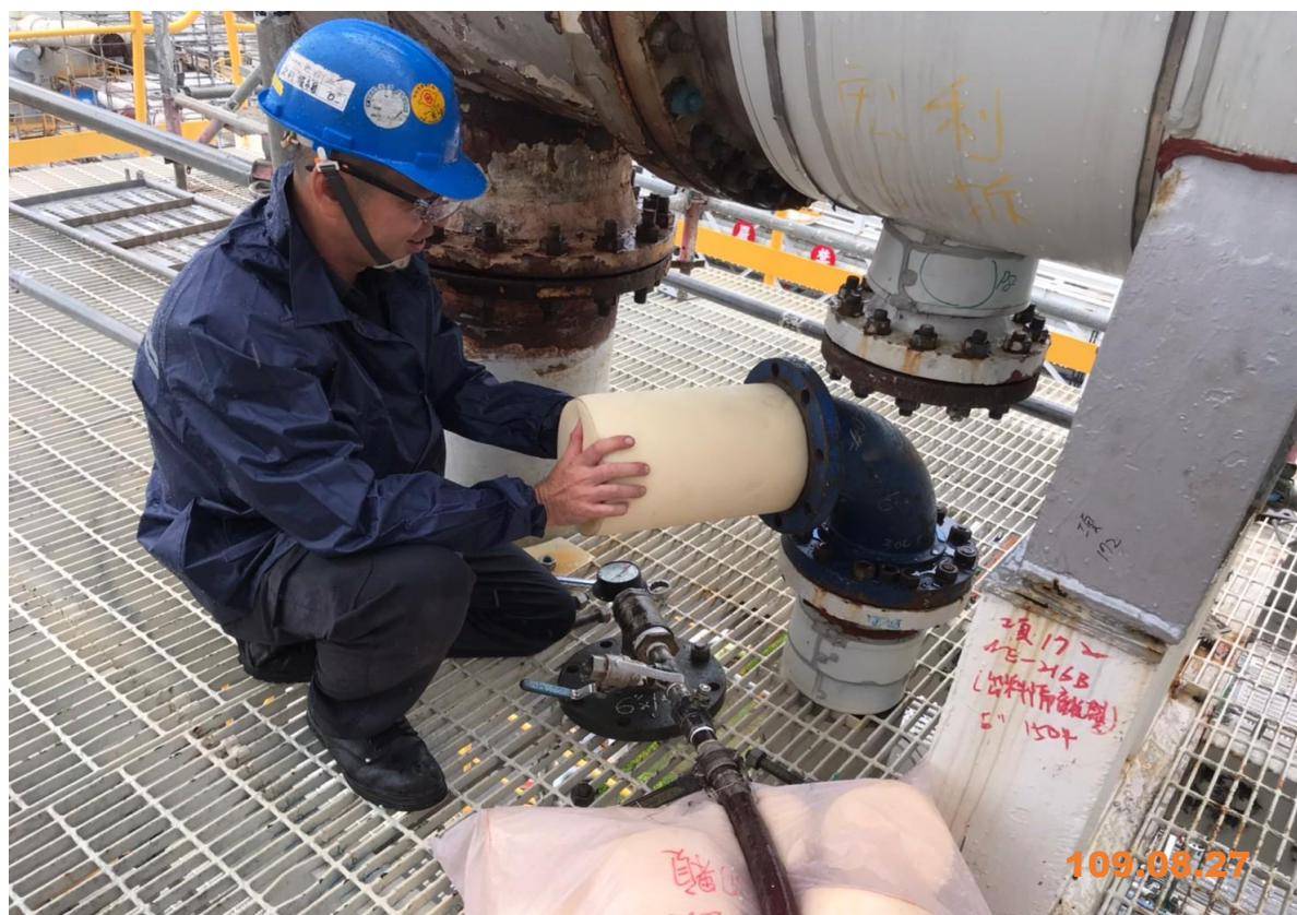
5. 發射端海綿安裝情形
