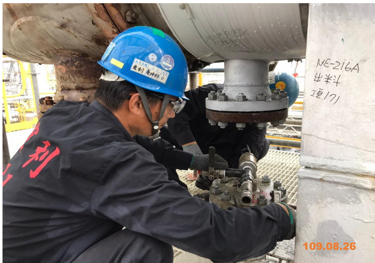
2. 熱交換器閥件拆卸(2)
