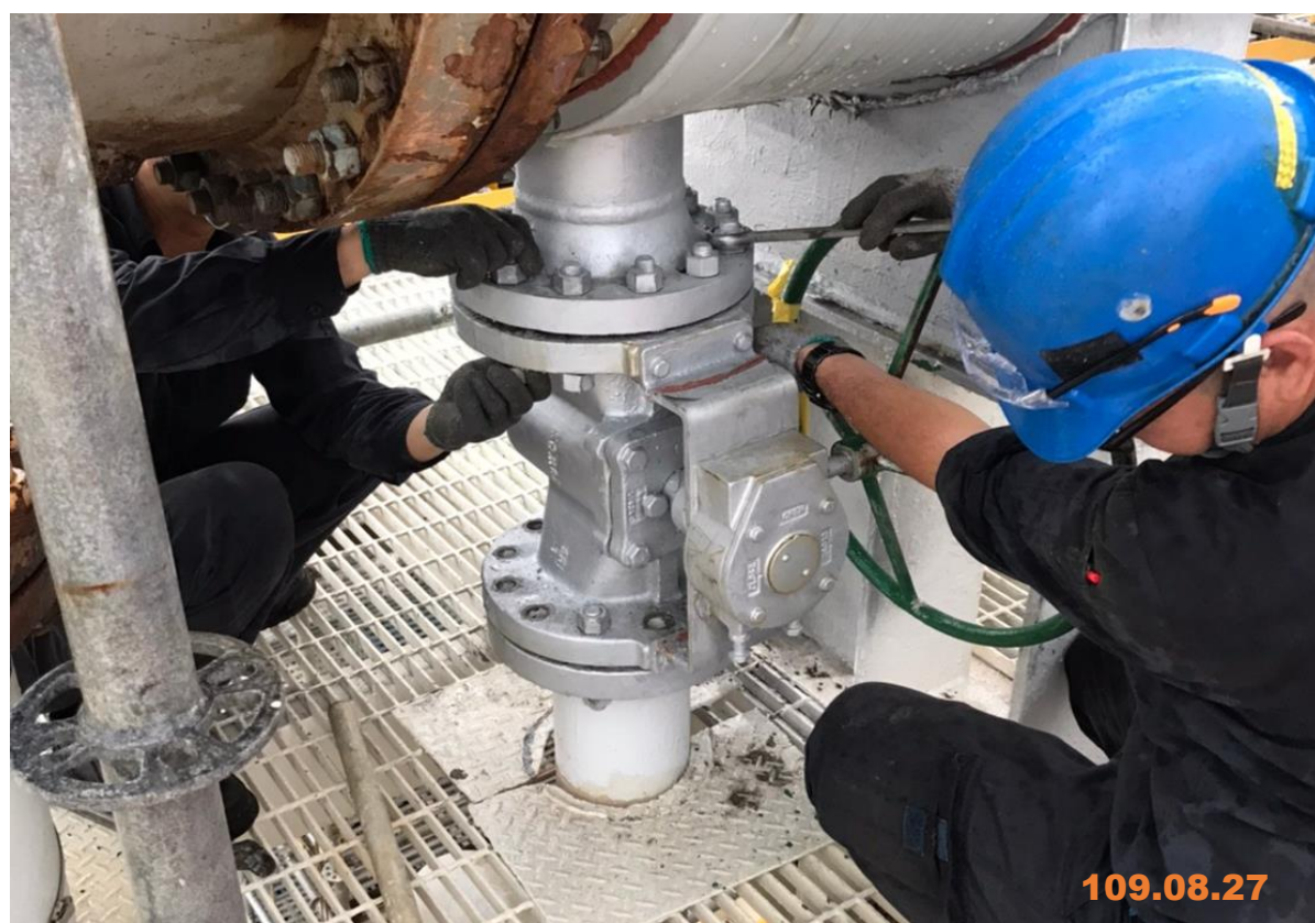
10. 管線復原情形(2)
