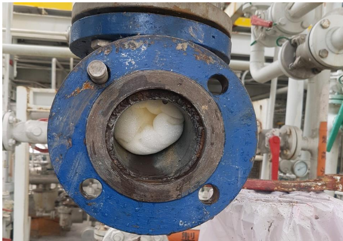
5. PIG 海綿安裝情形
