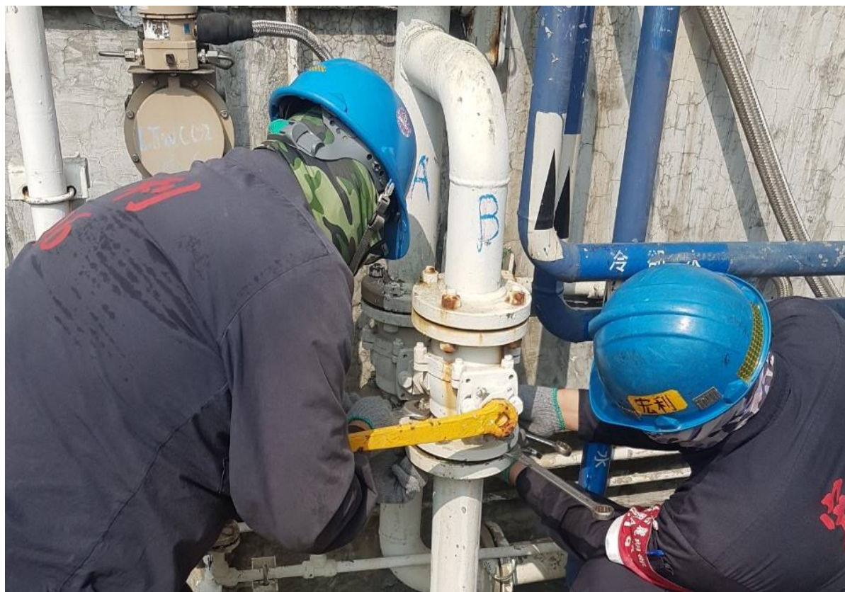
1. 施工位置確認後進行短管移除
