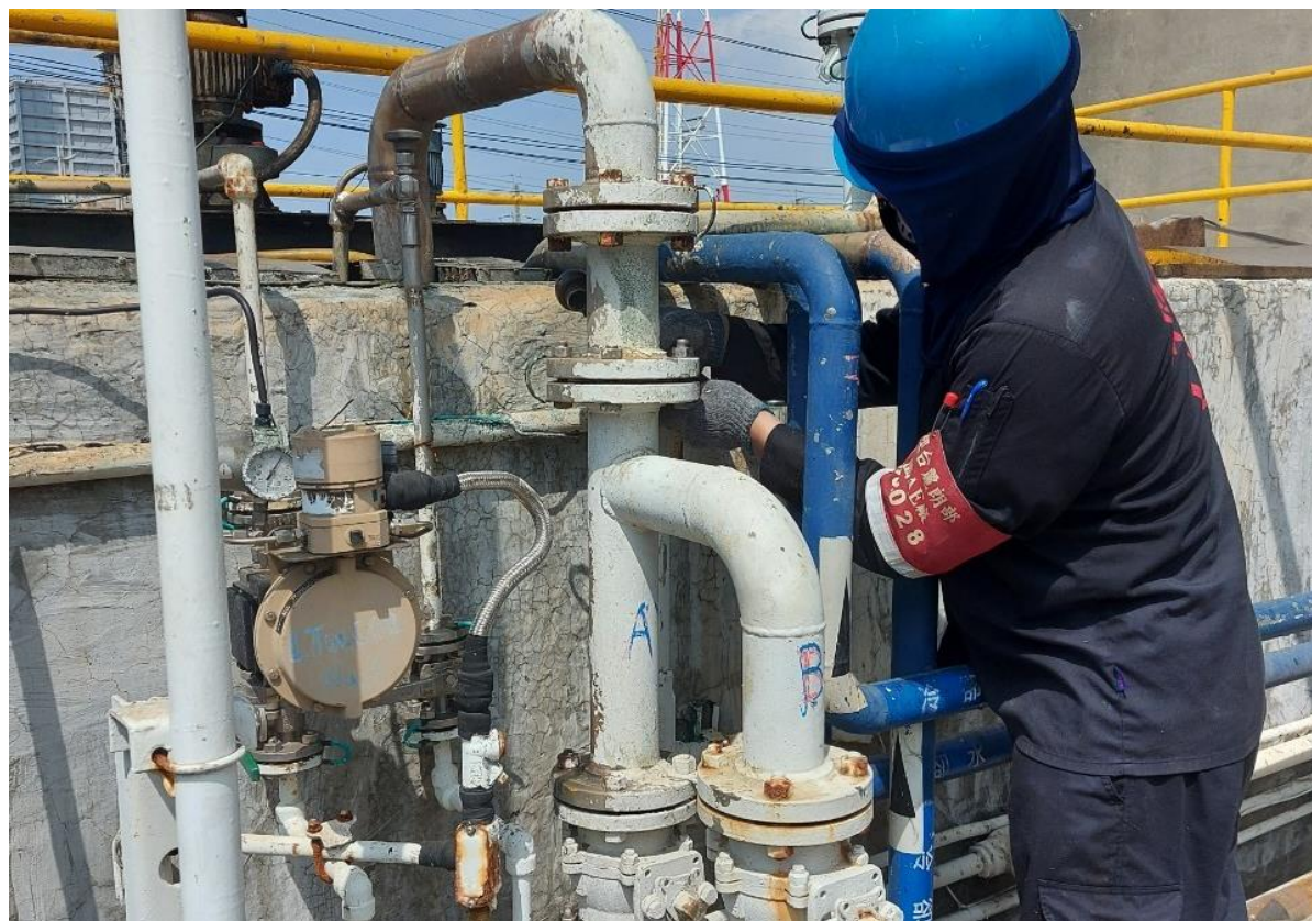
11. 清管完成管線復原
