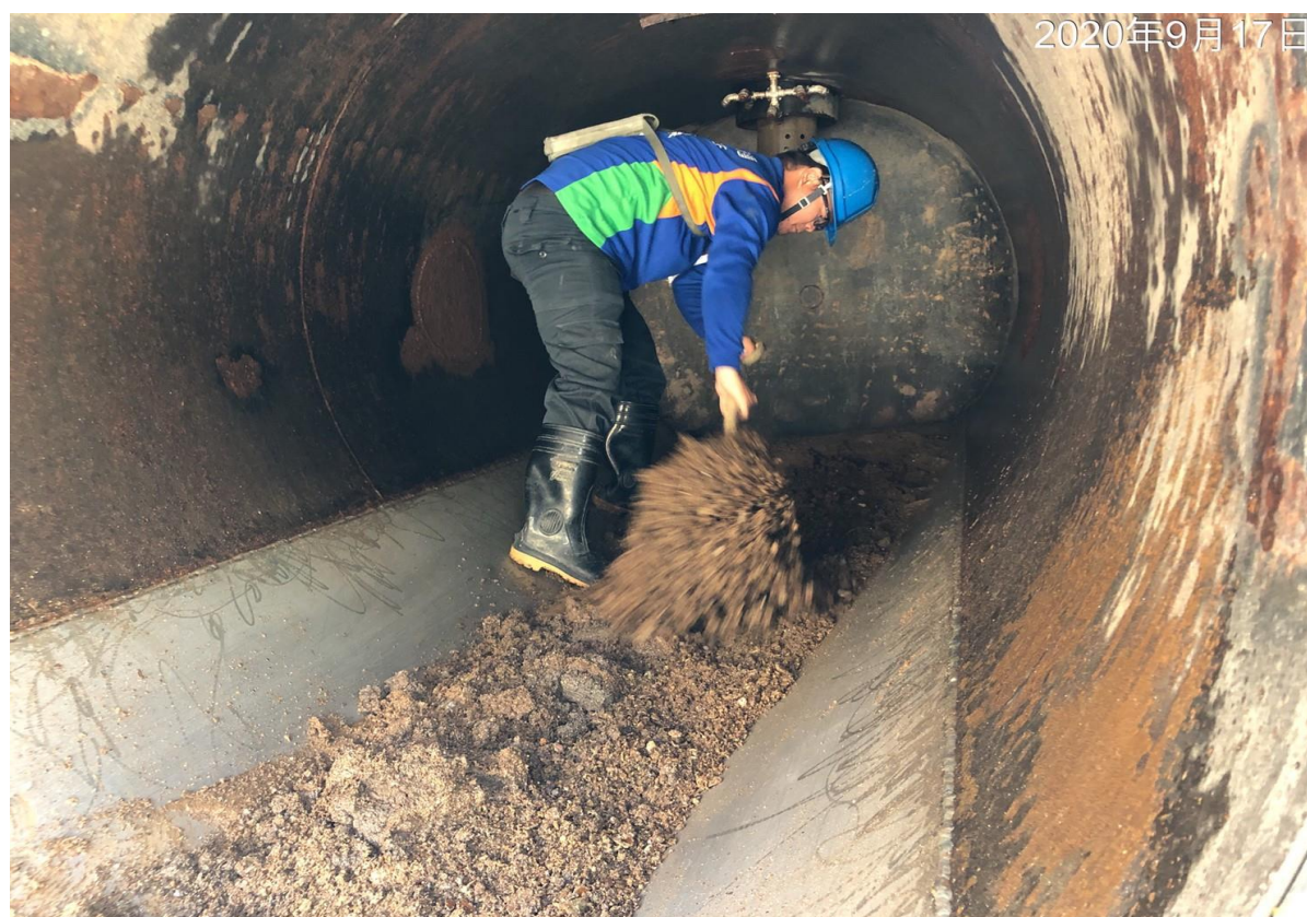
8. 槽車內部淤泥清理
