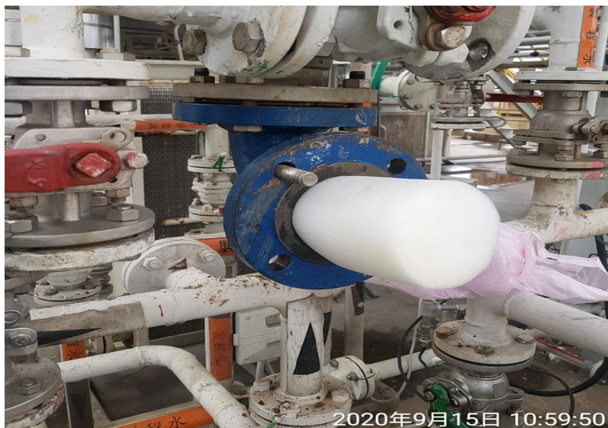
2. 插盲後拆除短管並安裝發射端
