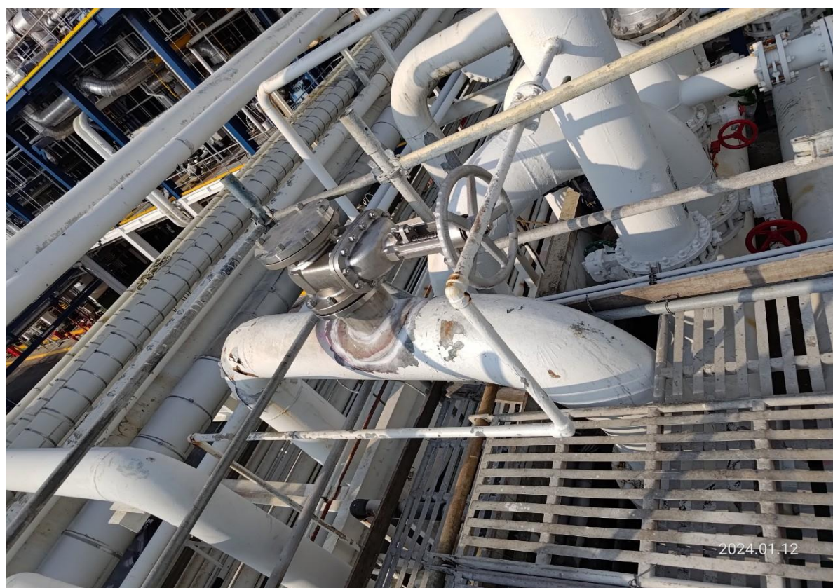
10. 施工完成安裝盲法蘭
