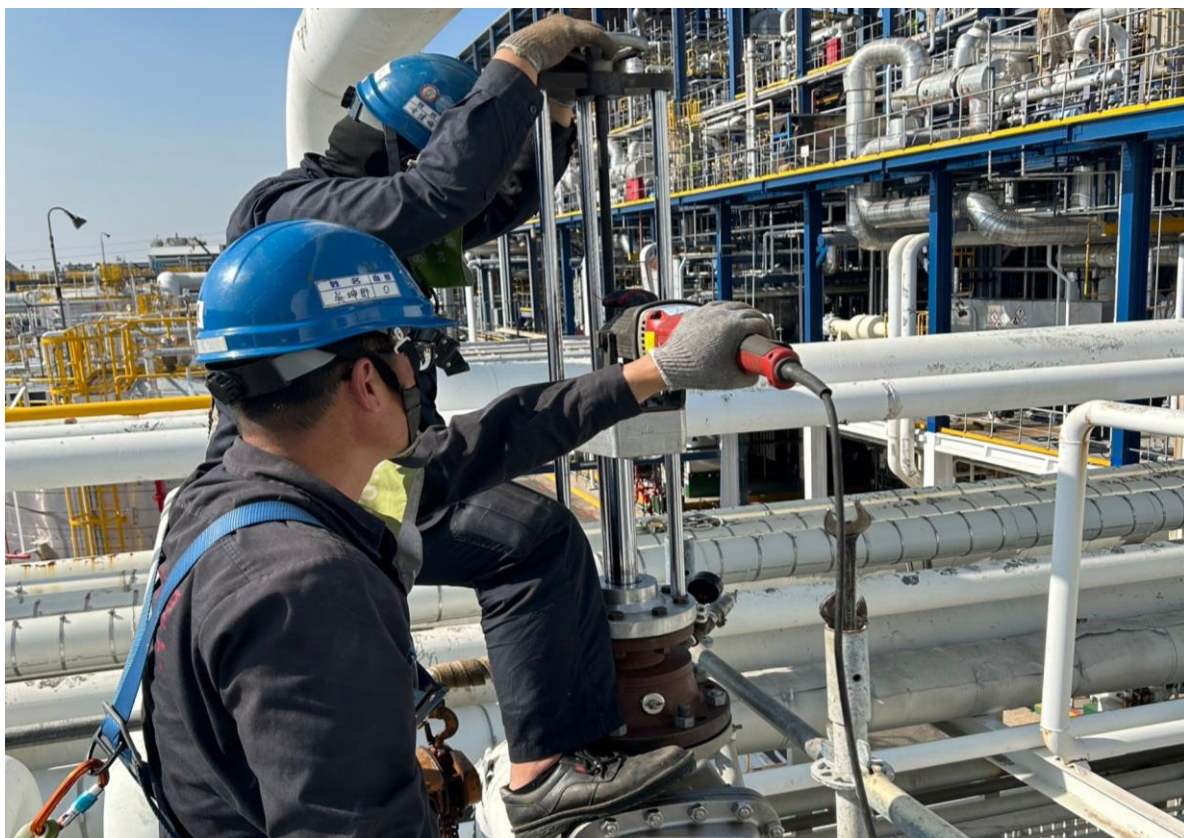
7. 人員執行開孔作業
