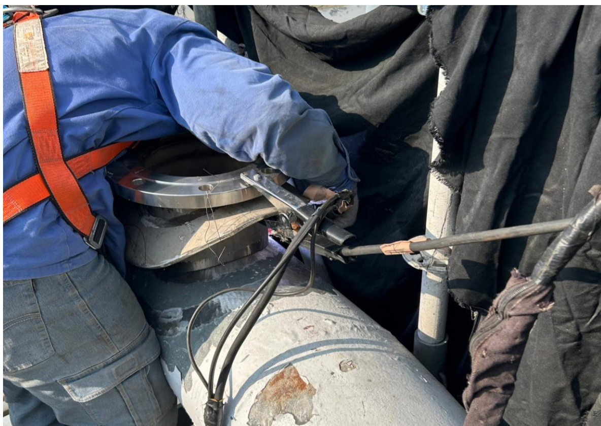
2. 短管法蘭焊接作業
