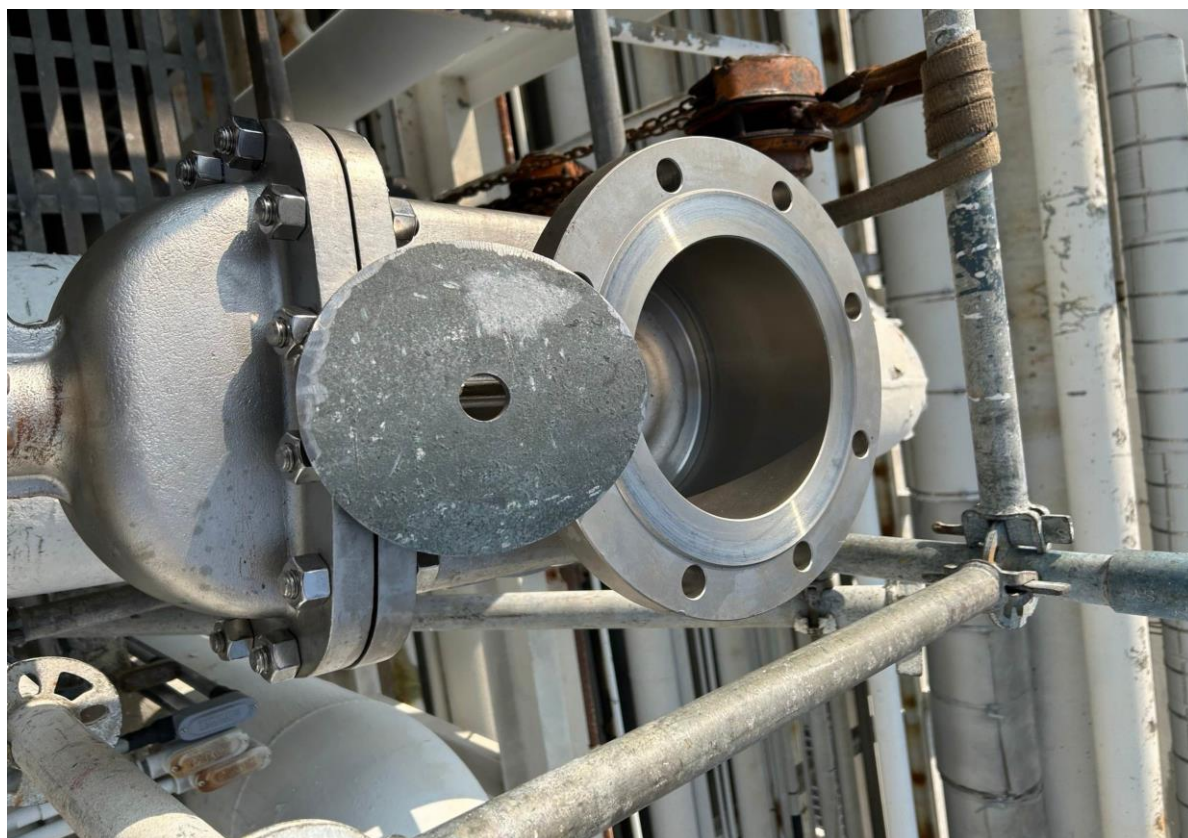
9. 開孔作業完成，確認鐵片取出
