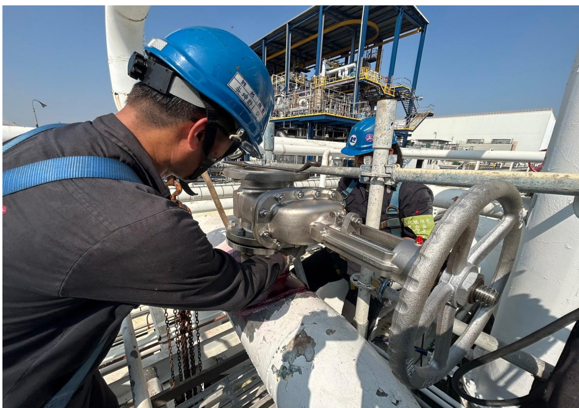
4. 閥件安裝作業
