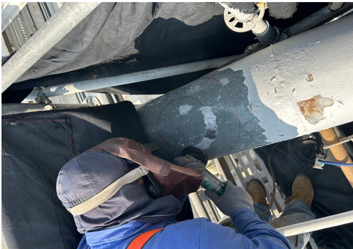
1. 管線研磨作業
