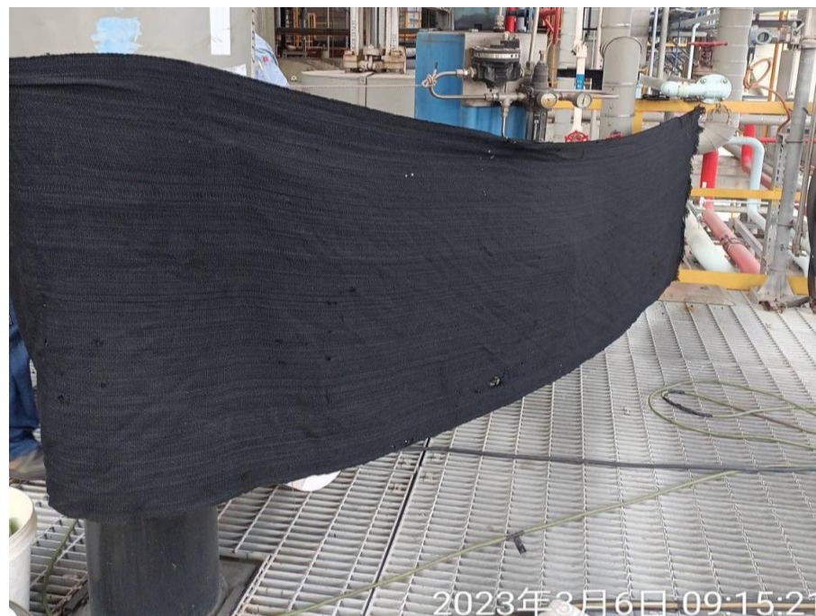
2. 施工位置防火纖維吊簾鋪設
