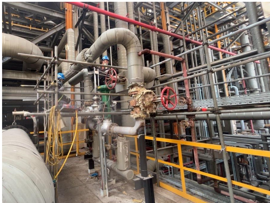
1. 現場施工位置確認
