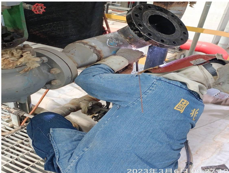
3. 防火毯鋪設情形
