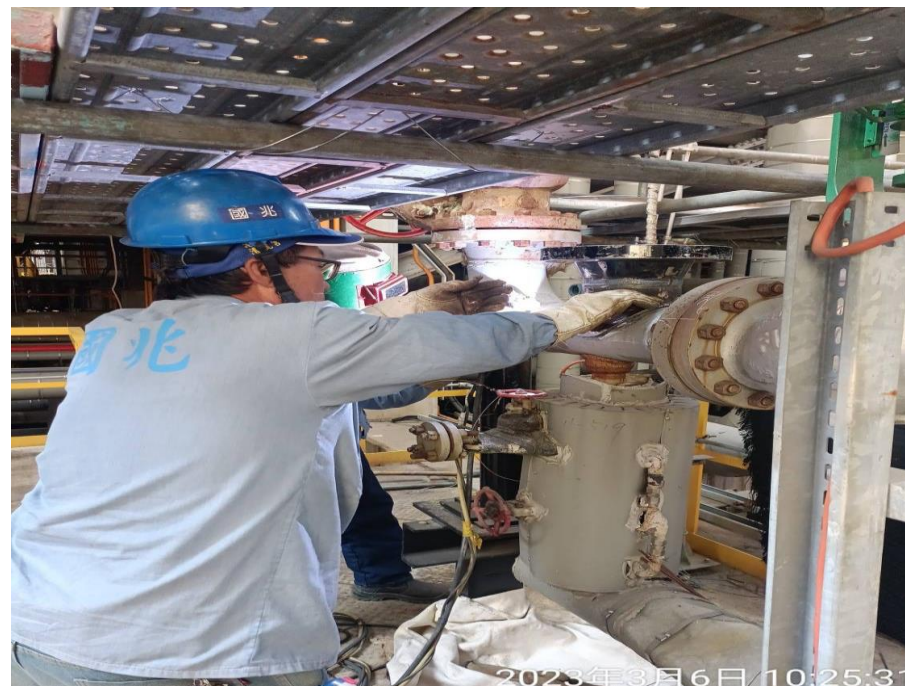
4. 短管法蘭焊接作業
