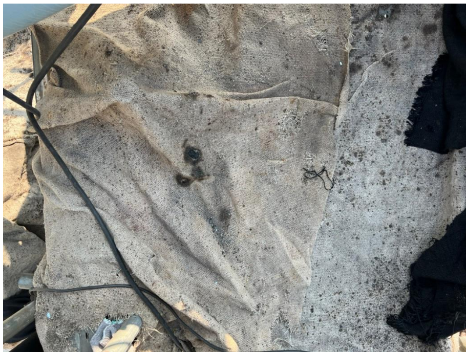
3. 防火毯鋪設情形
