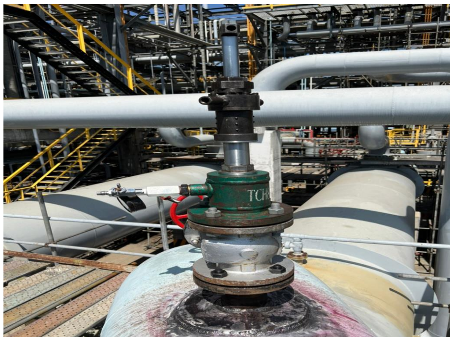
7. 閥件及開孔機具安裝作業
