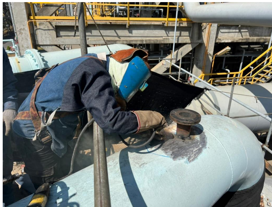
4. 短管法蘭焊接作業
