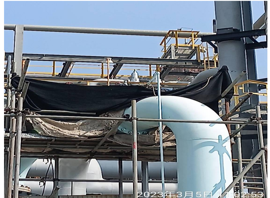
2. 施工位置防火纖維吊簾鋪設
