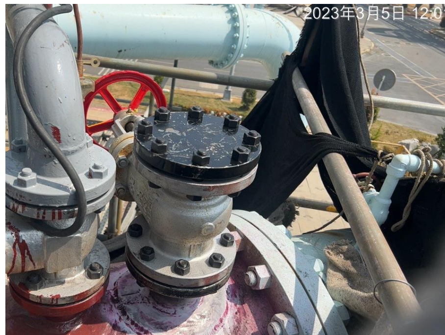
10. 施工完成安裝盲法蘭
