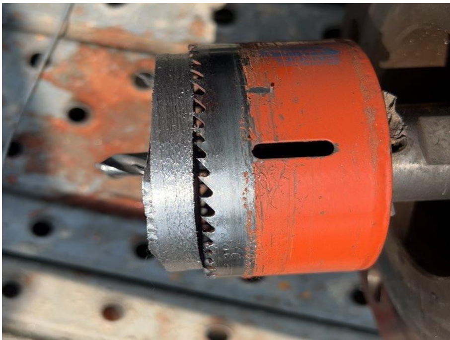
9. 開孔完成確認鐵片取出
