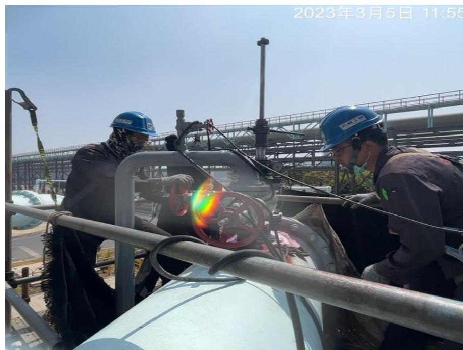
6. 人員安裝開孔機及閥件
