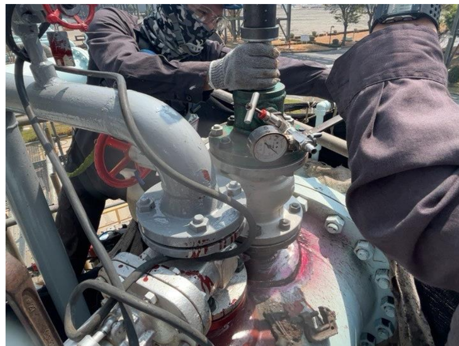
8. 人員進行開孔作業
