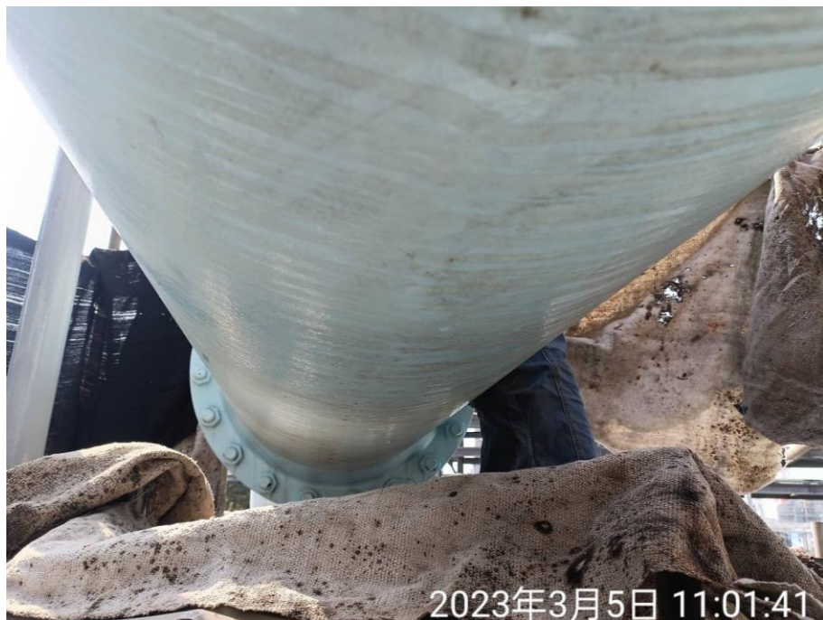
3. 防火毯鋪設情形
