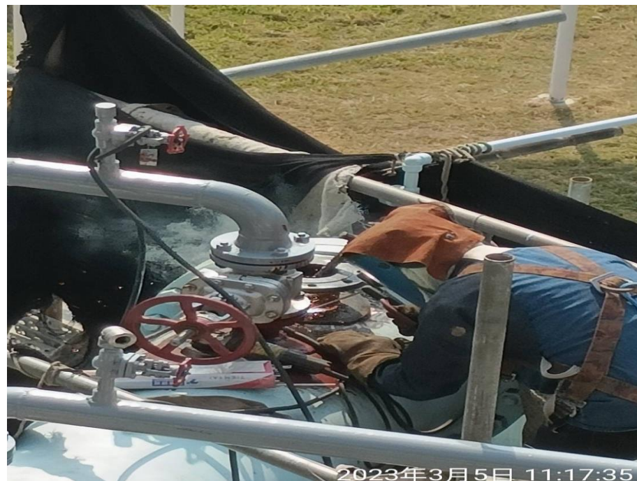
4. 短管法蘭焊接作業
