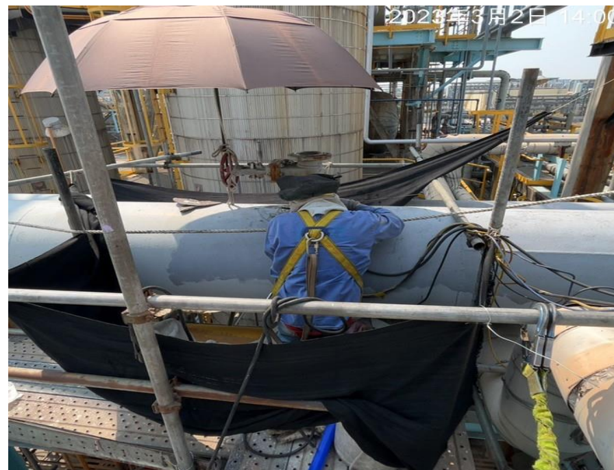
2. 施工位置防火纖維吊簾鋪設
