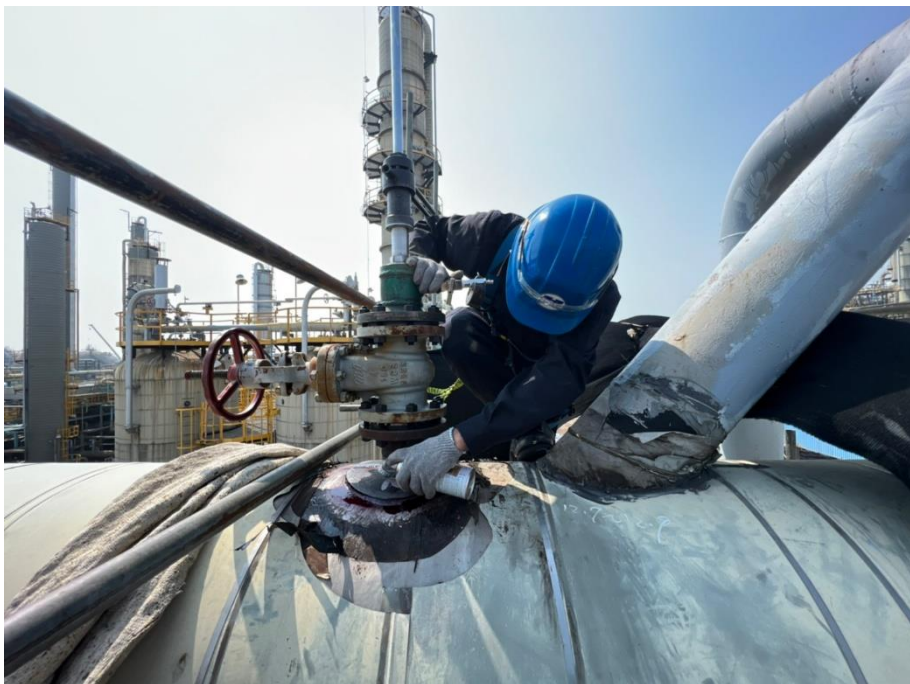
7. 閥件及開孔機具安裝作業
