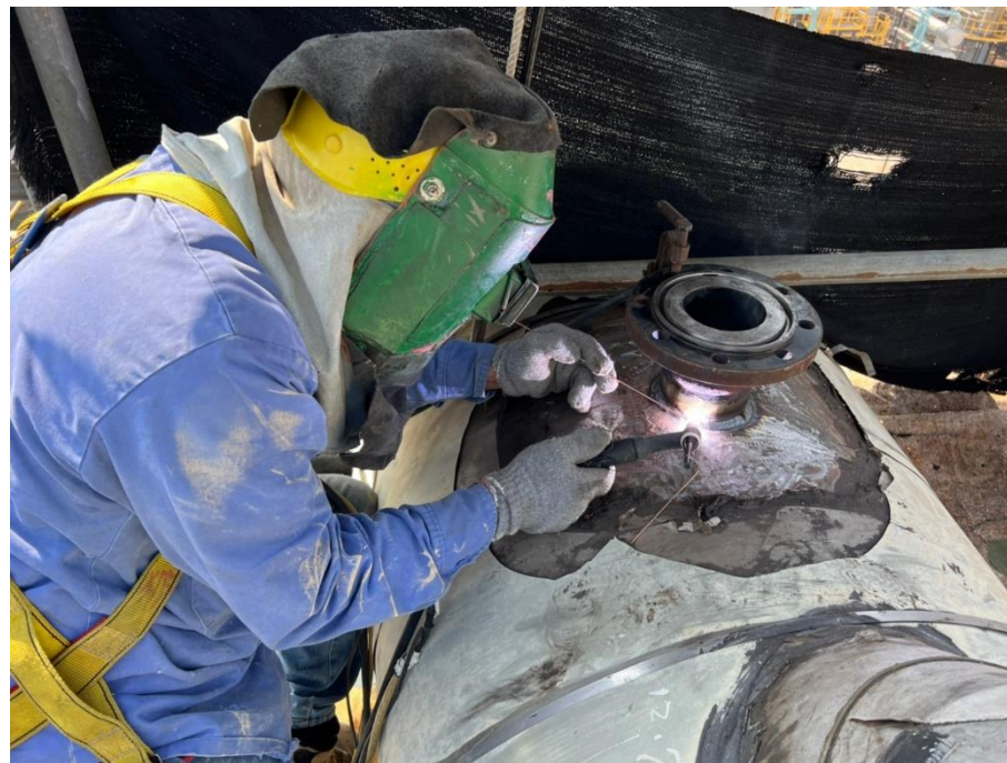
4. 短管法蘭焊接作業
