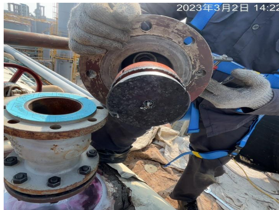
10. 開孔完成確認鐵片取出
