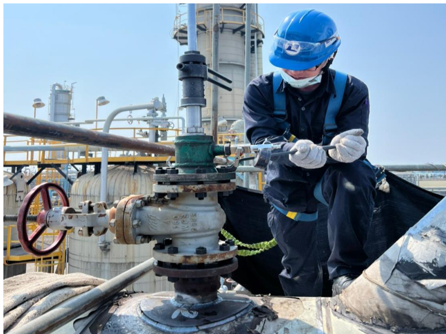
9. 人員執行開孔作業
