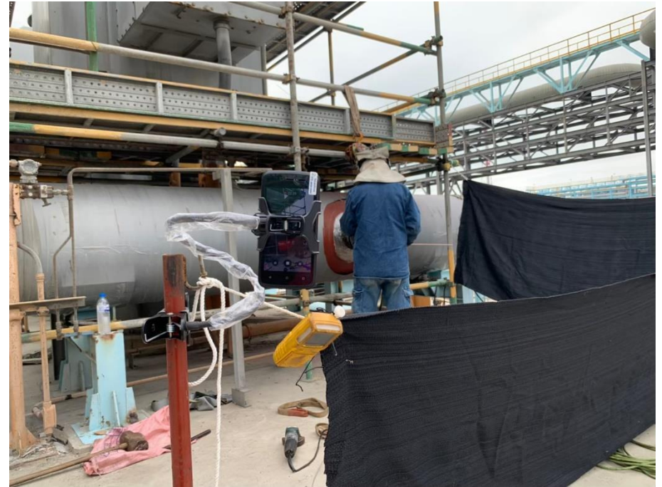
2. 人員銲接作業及防火纖維吊簾鋪設
