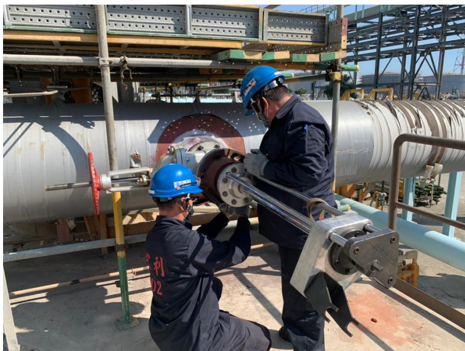
7. 開孔機具安裝作業
