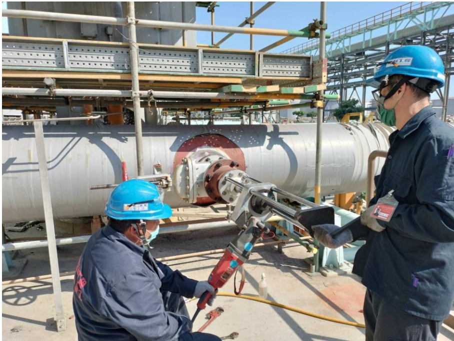
9. 人員執行開孔作業
