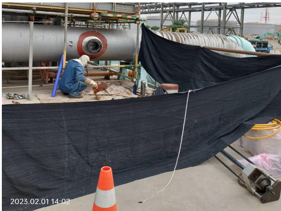
3. 人員施工及防火毯鋪設情形
