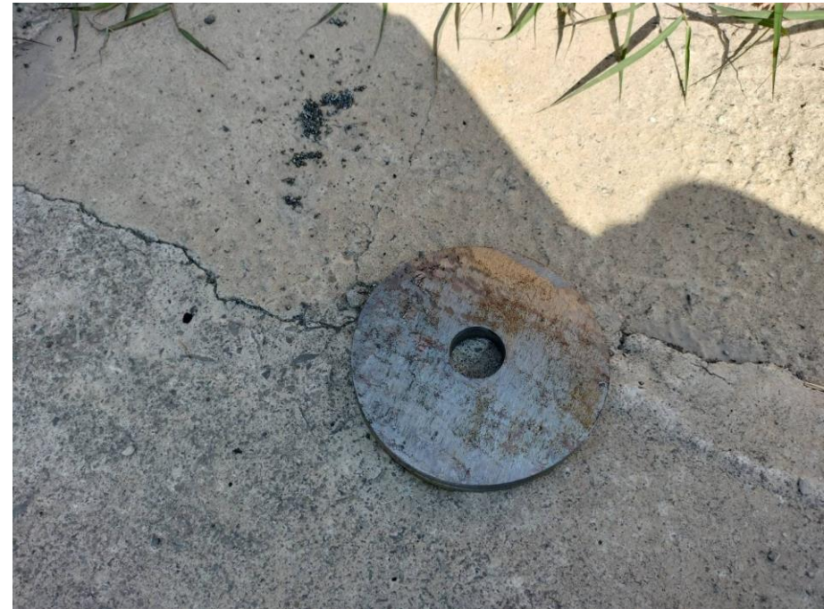
10. 開孔完成確認鐵片取出
