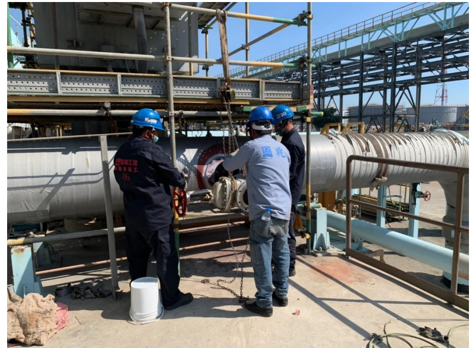
6. 閥件安裝作業
