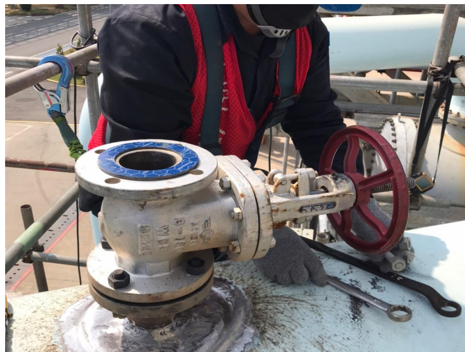
6. 閥件安裝作業
