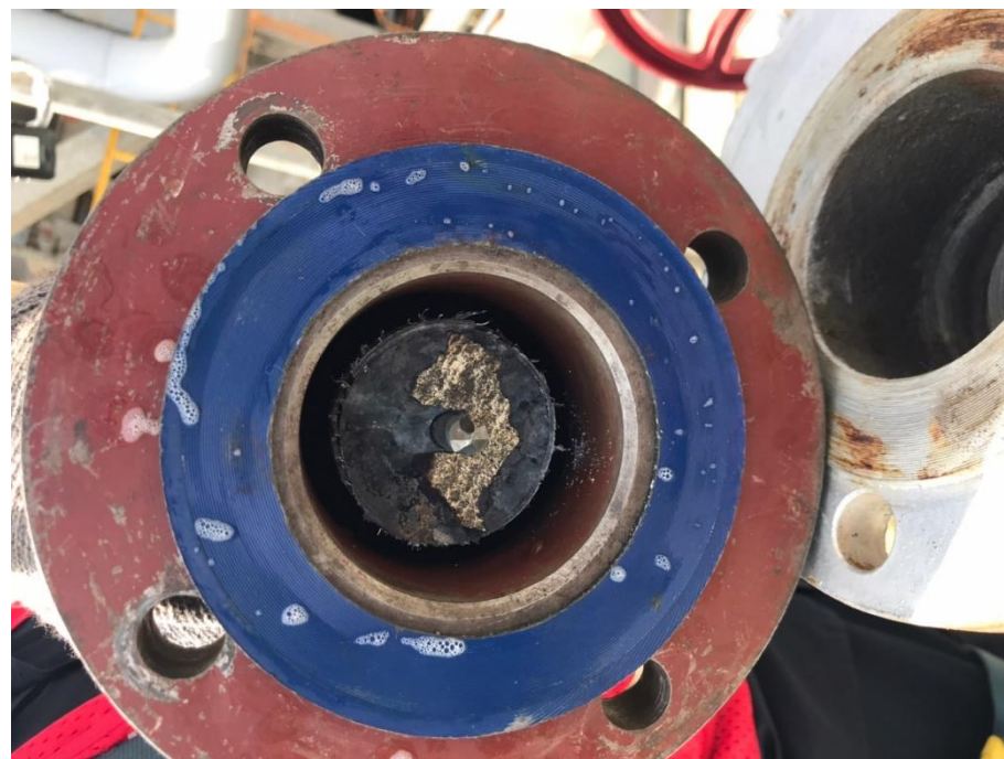
10. 開孔完成確認鐵片取出
