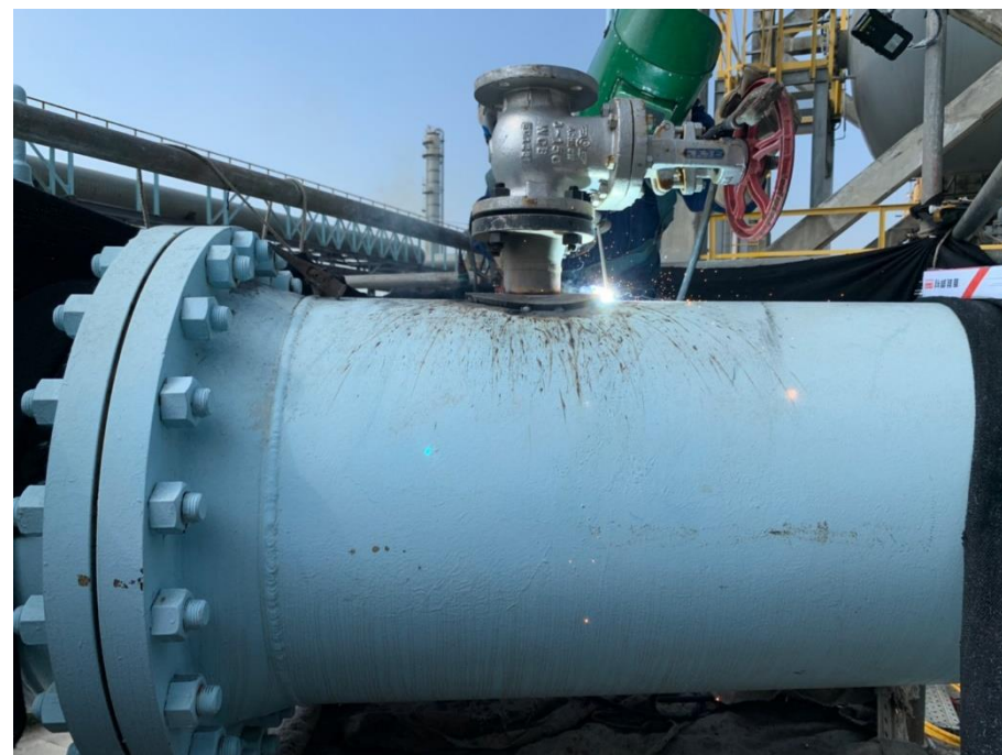
4. 短管法蘭焊接作業
