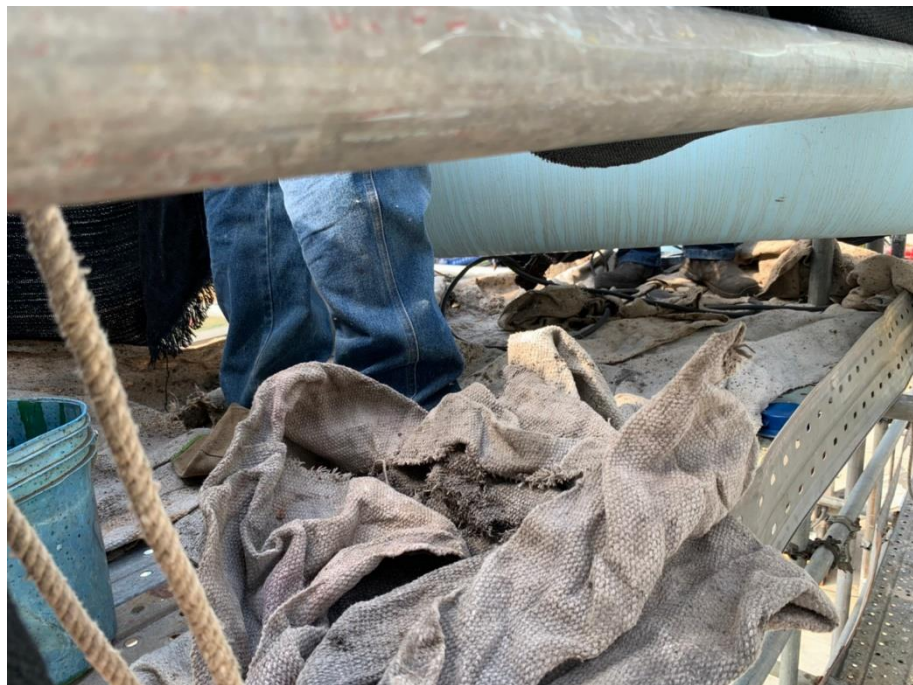
3. 防火毯鋪設情形
