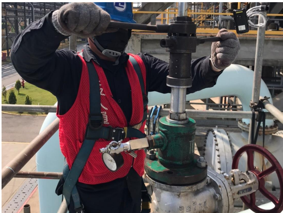
9. 人員執行開孔作業
