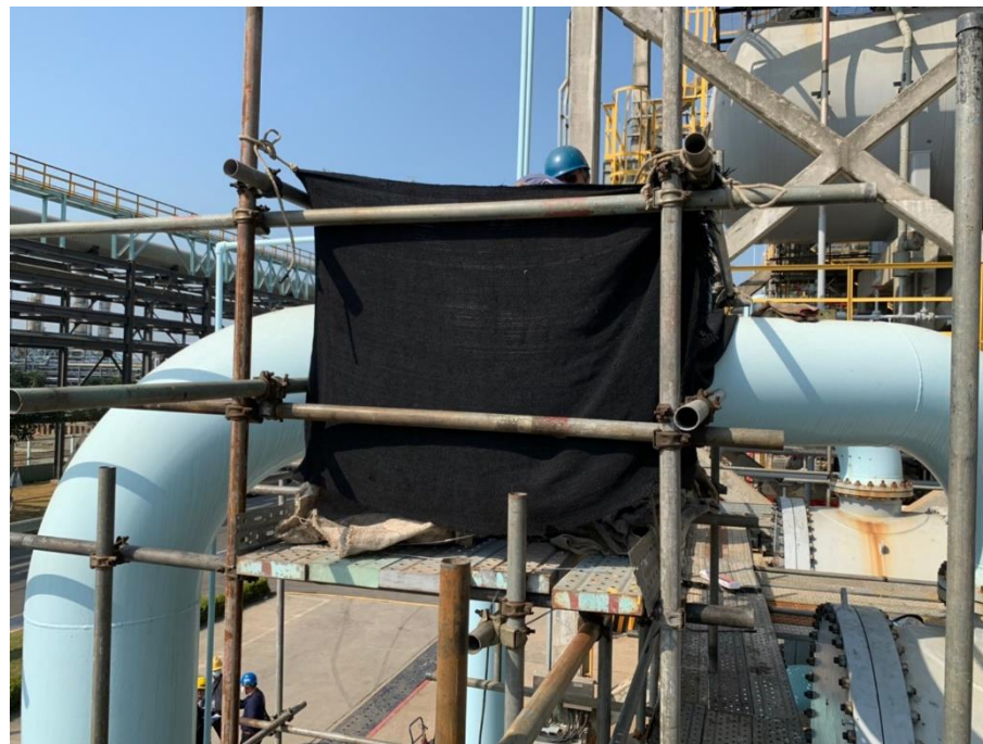
2. 施工位置防火纖維吊簾鋪設
