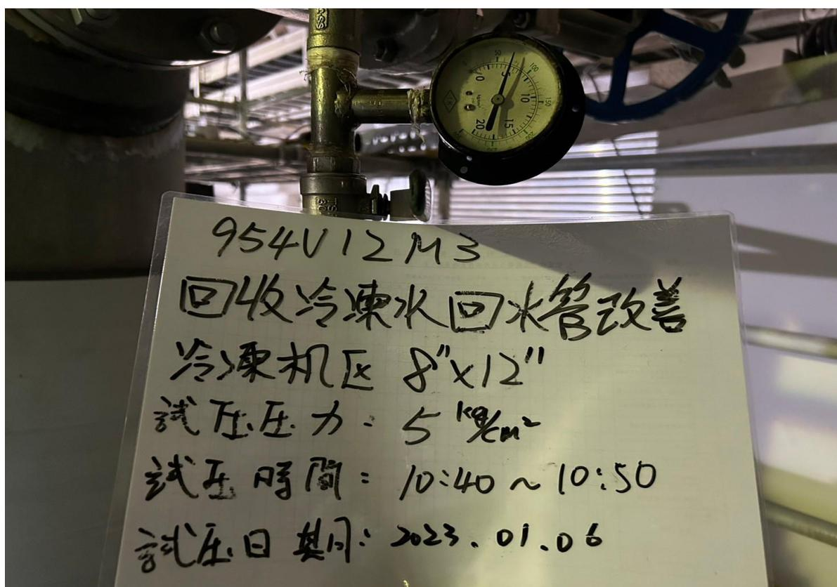
10. 試壓作業(氣壓，持壓 10min)
