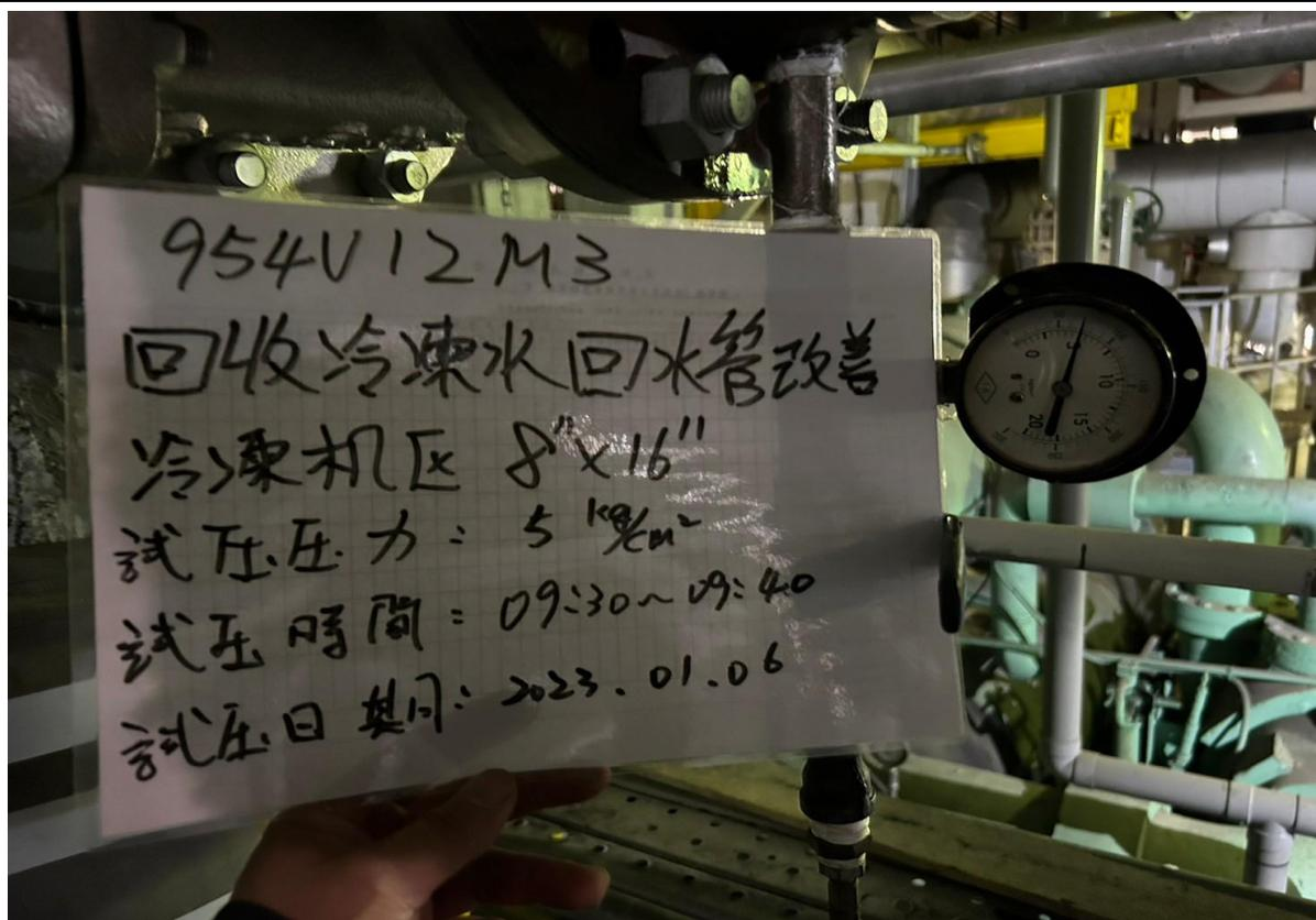
8. 試壓作業(氣壓，持壓 10min)
