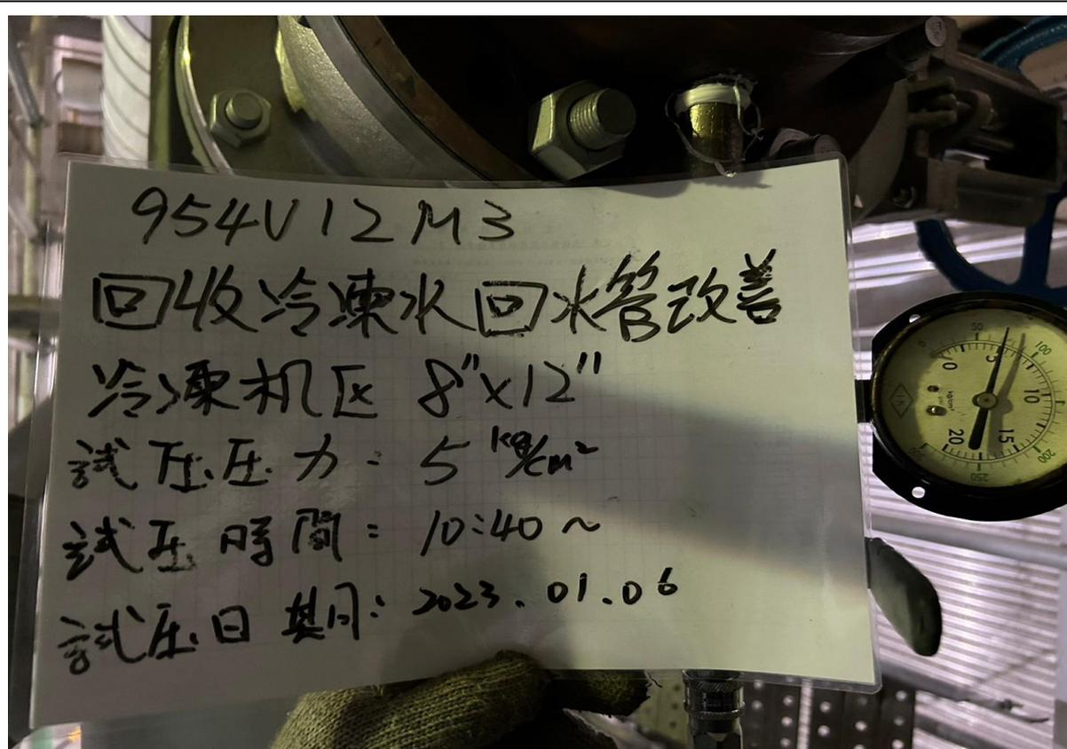
9. 人員安裝開孔機後進行試壓作業
