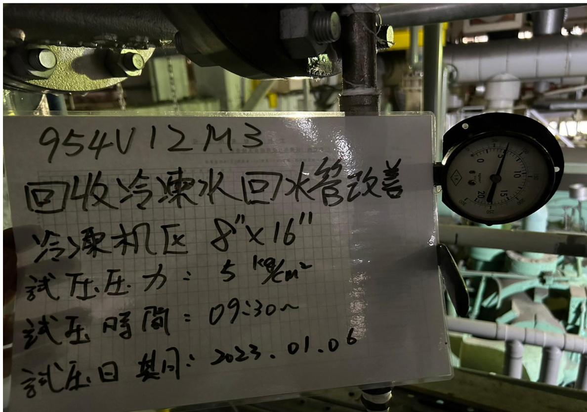
7. 人員安裝開孔機後進行試壓作業
