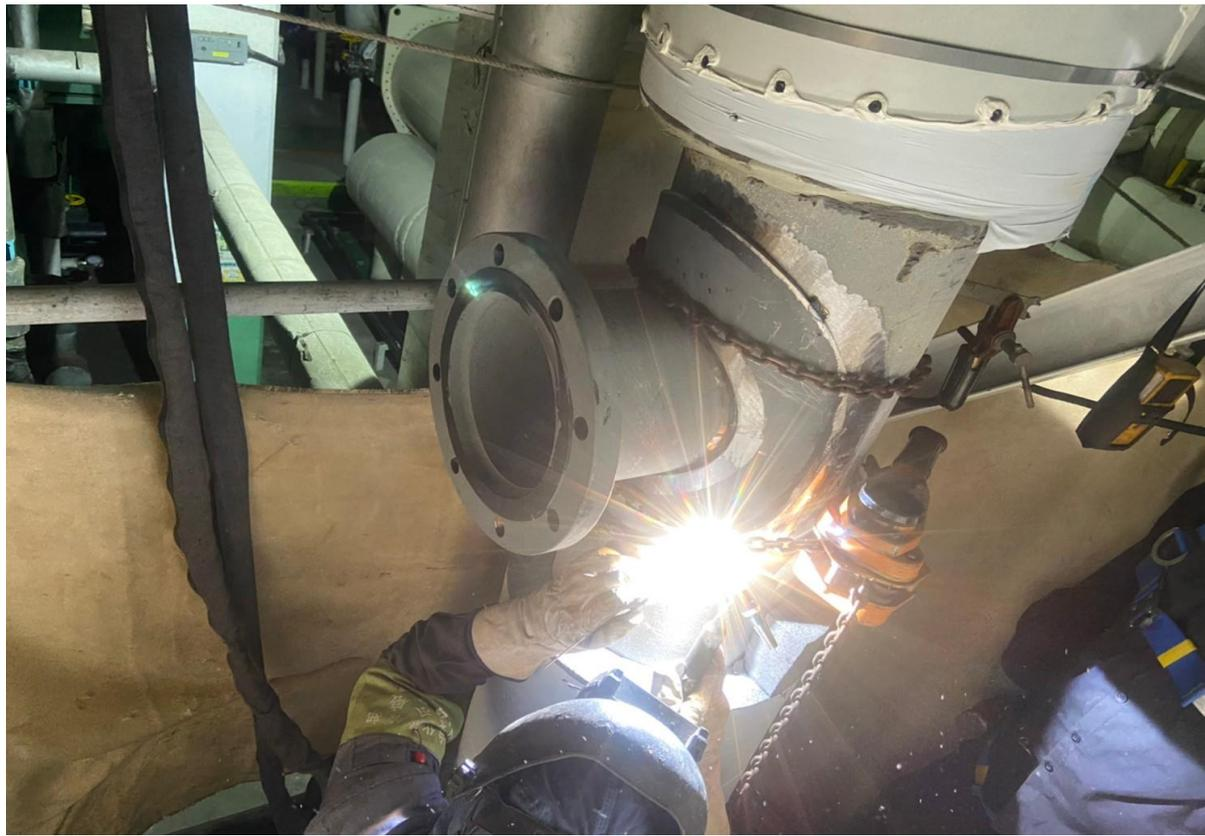
3.開孔模具焊接作業
