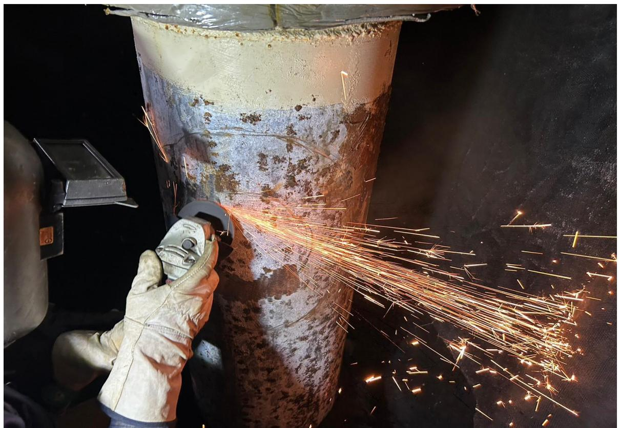
2. 施工位置研磨及防火毯鋪設情形
