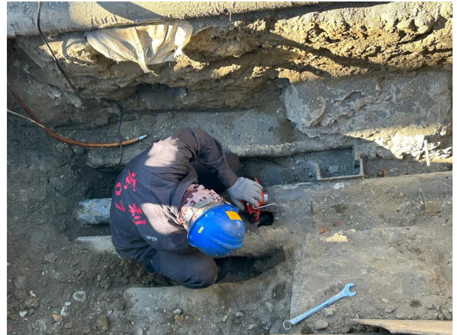
6. 管線研磨後安裝夾具
