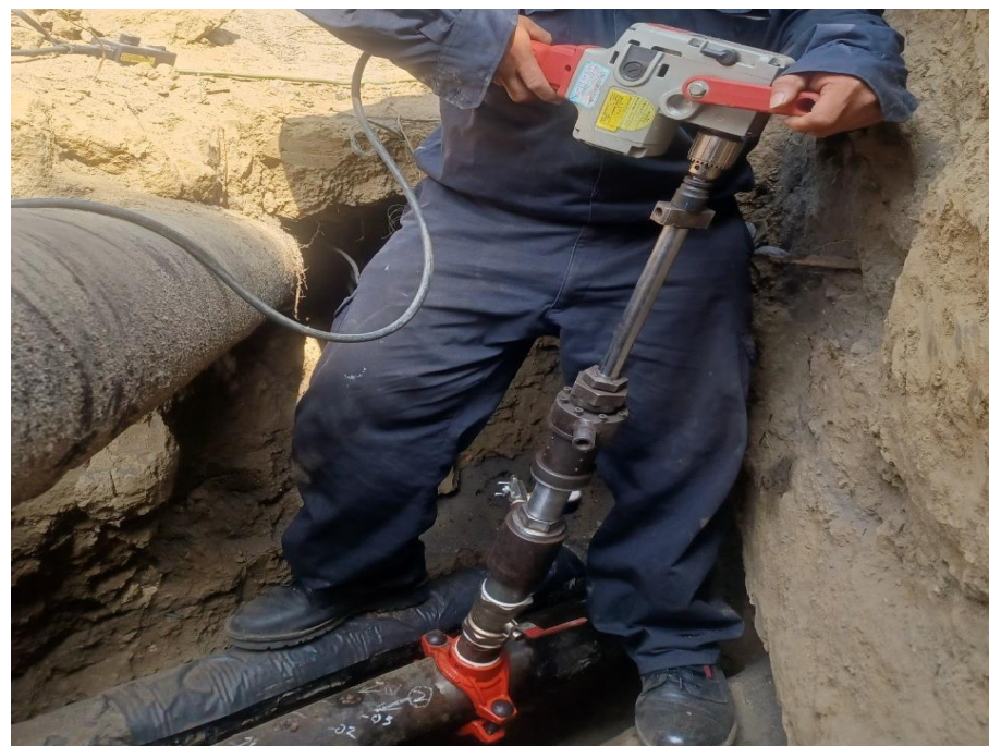
4. 人員執行開孔作業
