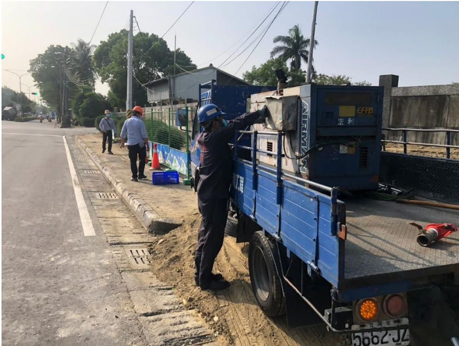
1. 施工機具定位
