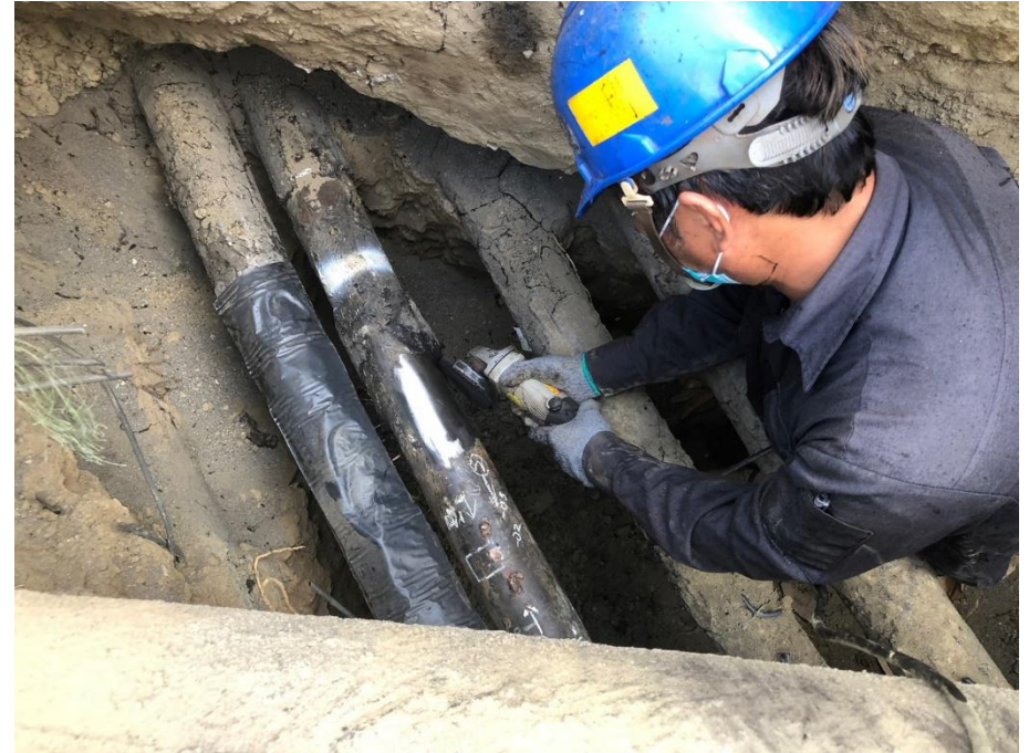
2. 施工管線研磨作業
