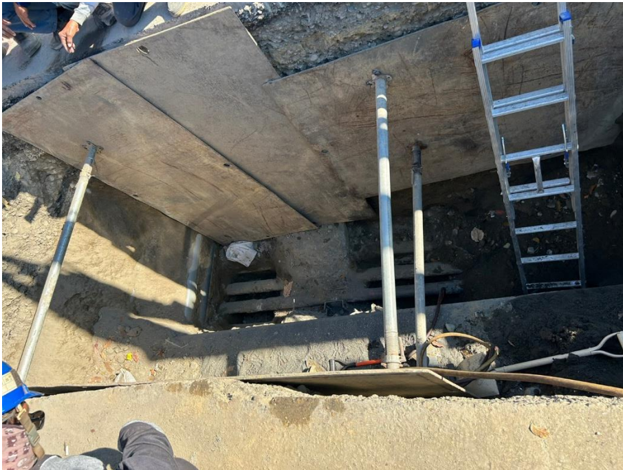
5. 開孔完成機具移除
