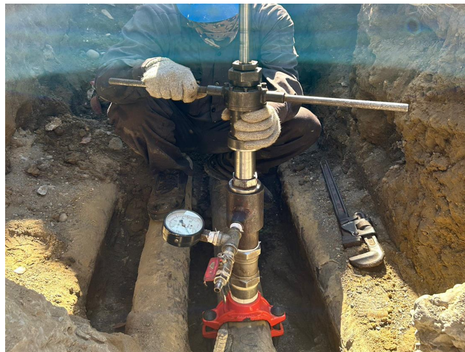
8. 人員執行開孔作業
