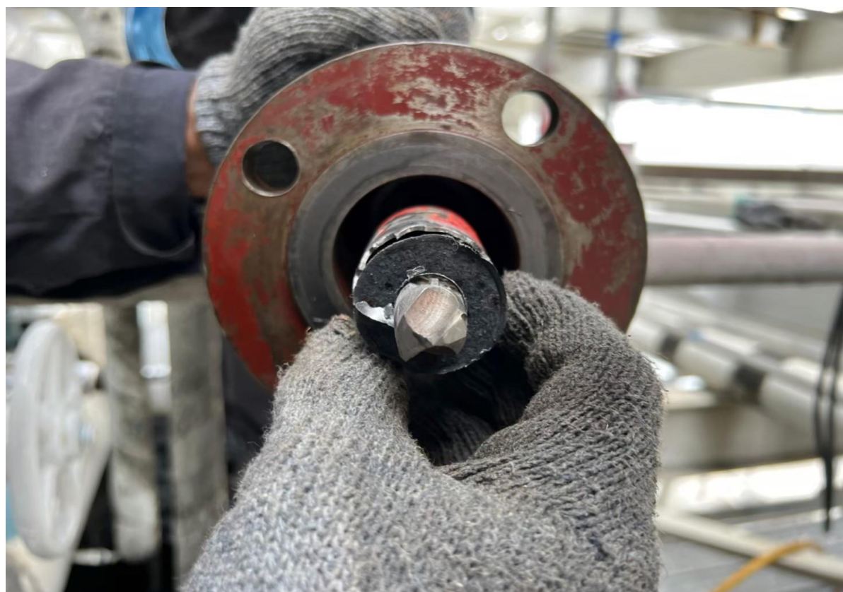
5. 開孔完成確認鐵片取出情形
