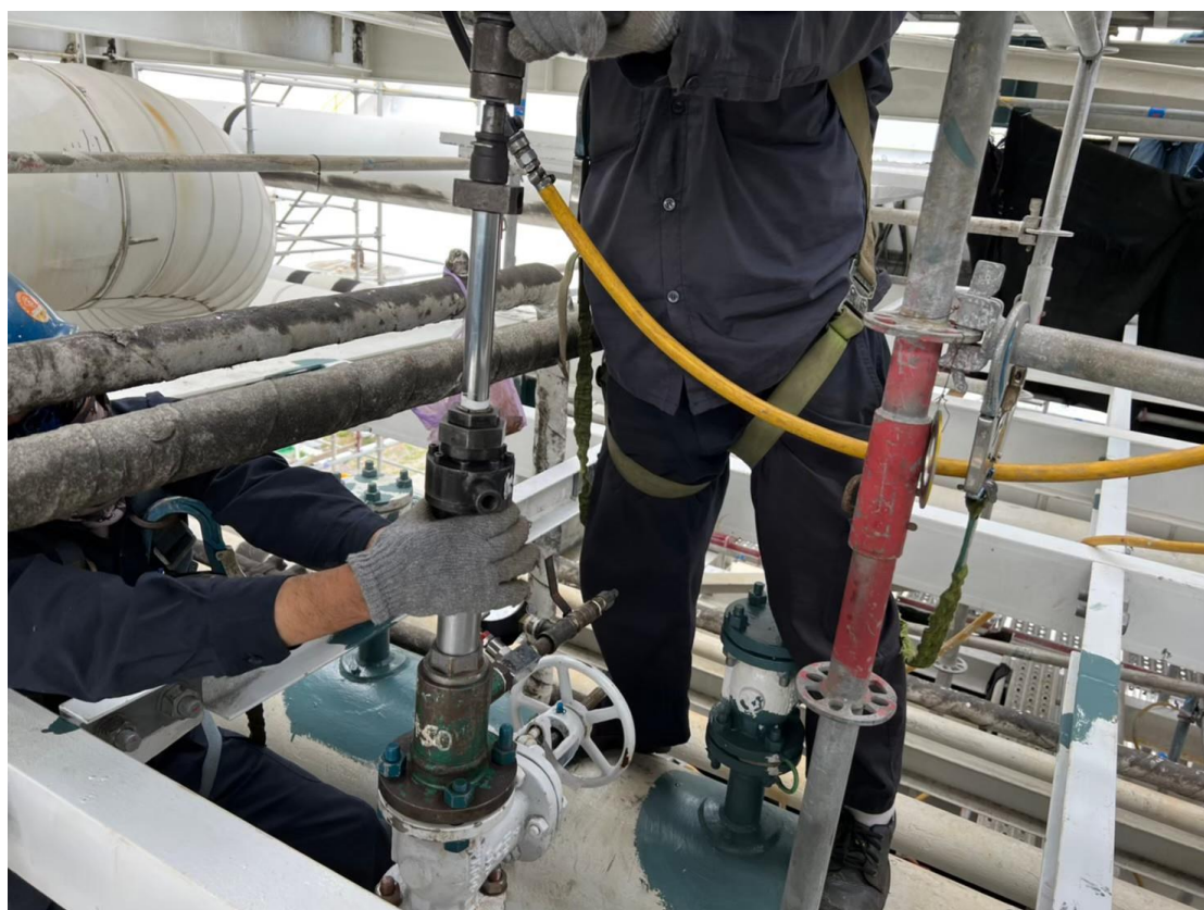
4. 人員執行開孔作業
