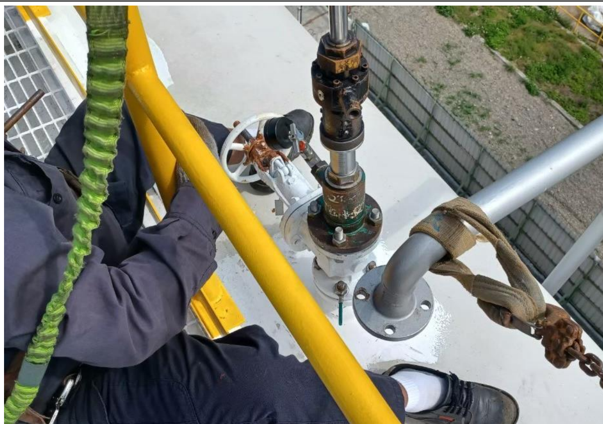
8. 人員執行開孔作業
