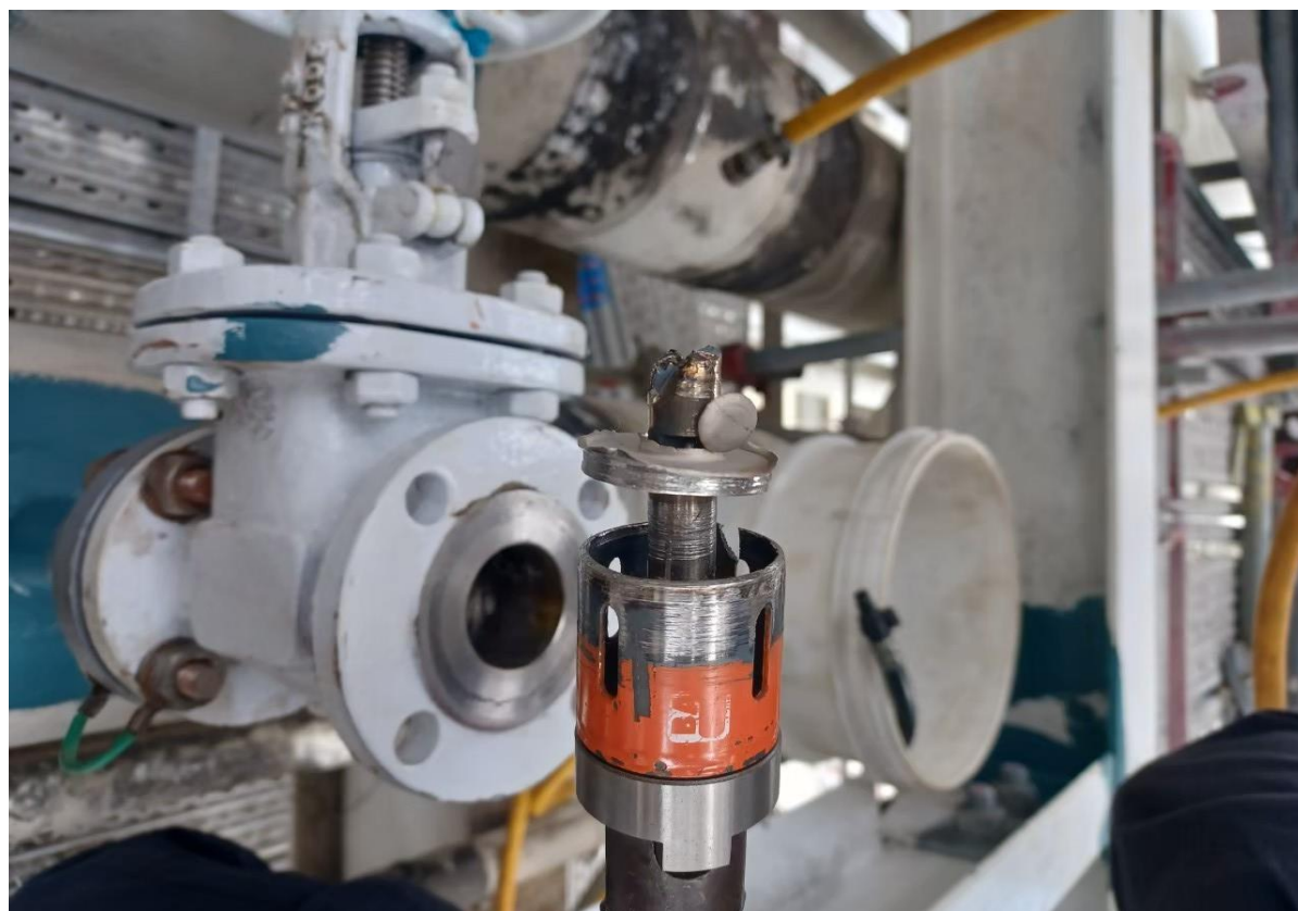
11. 管線開孔完成確認鐵片取出情形
