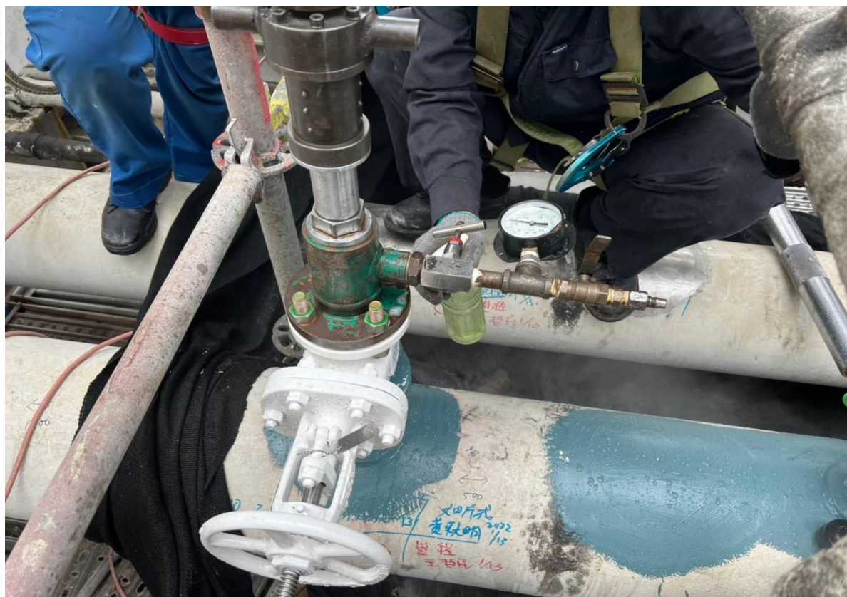
1. 開孔機安裝後試壓
