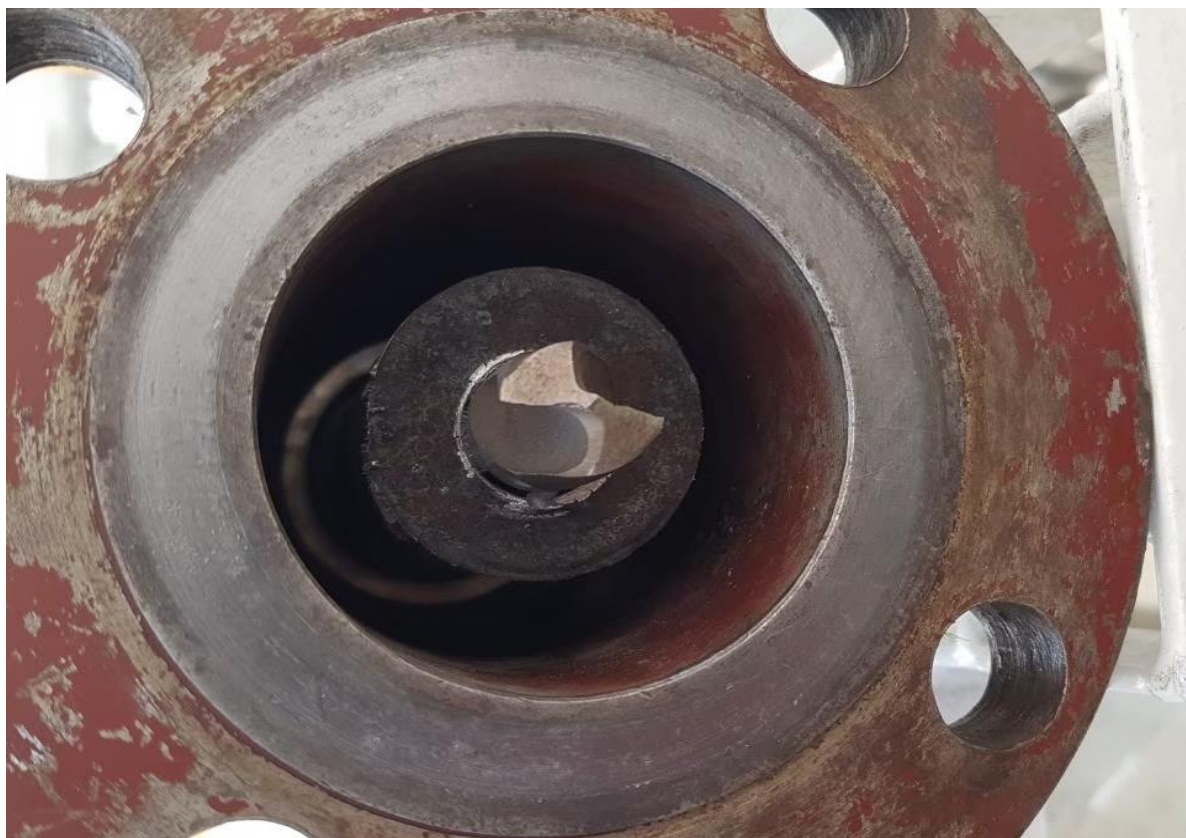
7. 開孔完成確認鐵片取出
