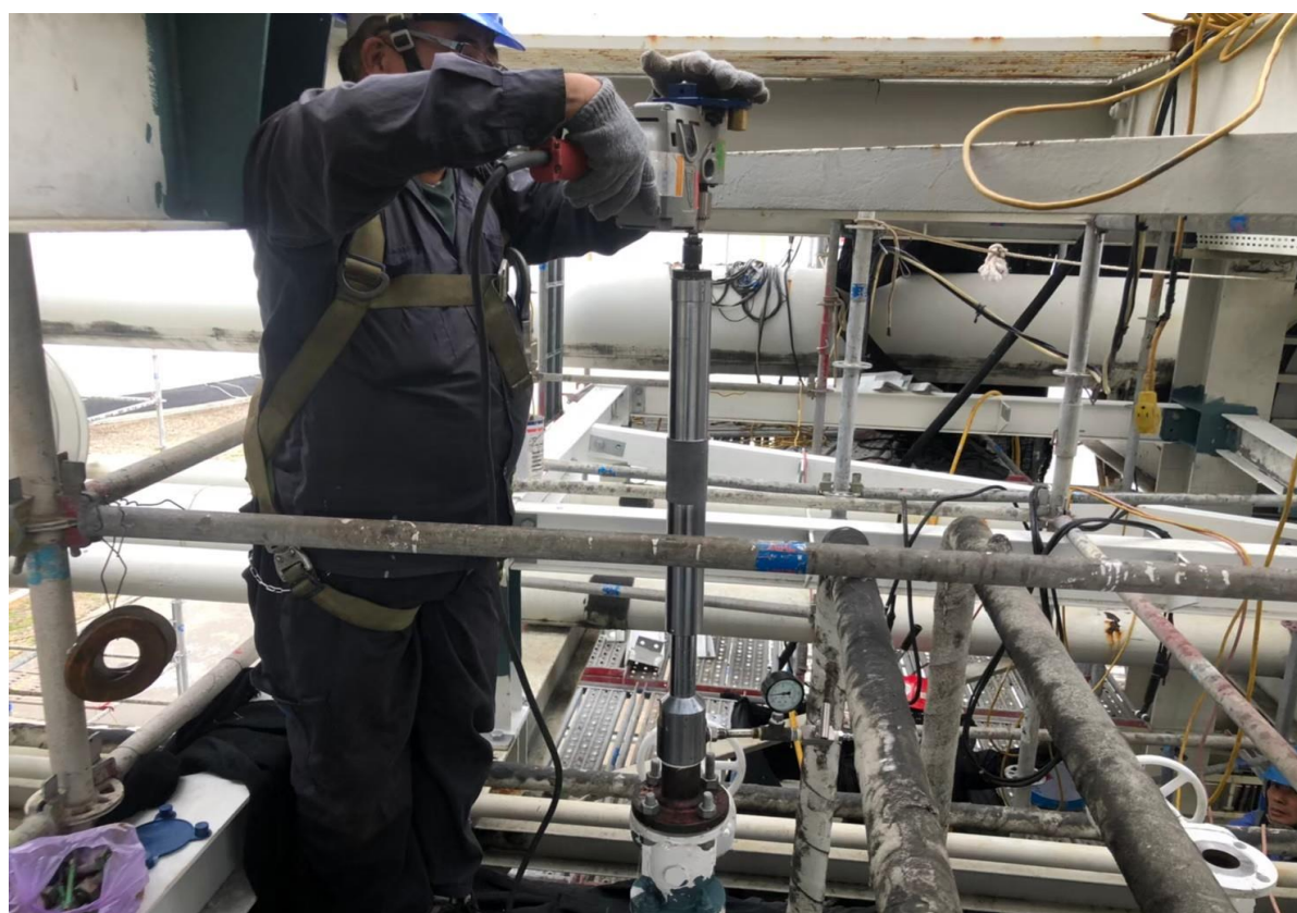
10.人員安裝開孔機情形
