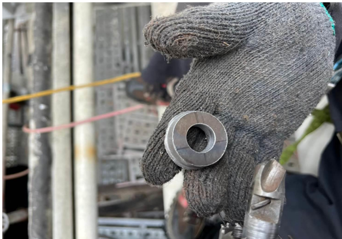
3. 開孔完成確認鐵片取出情形
