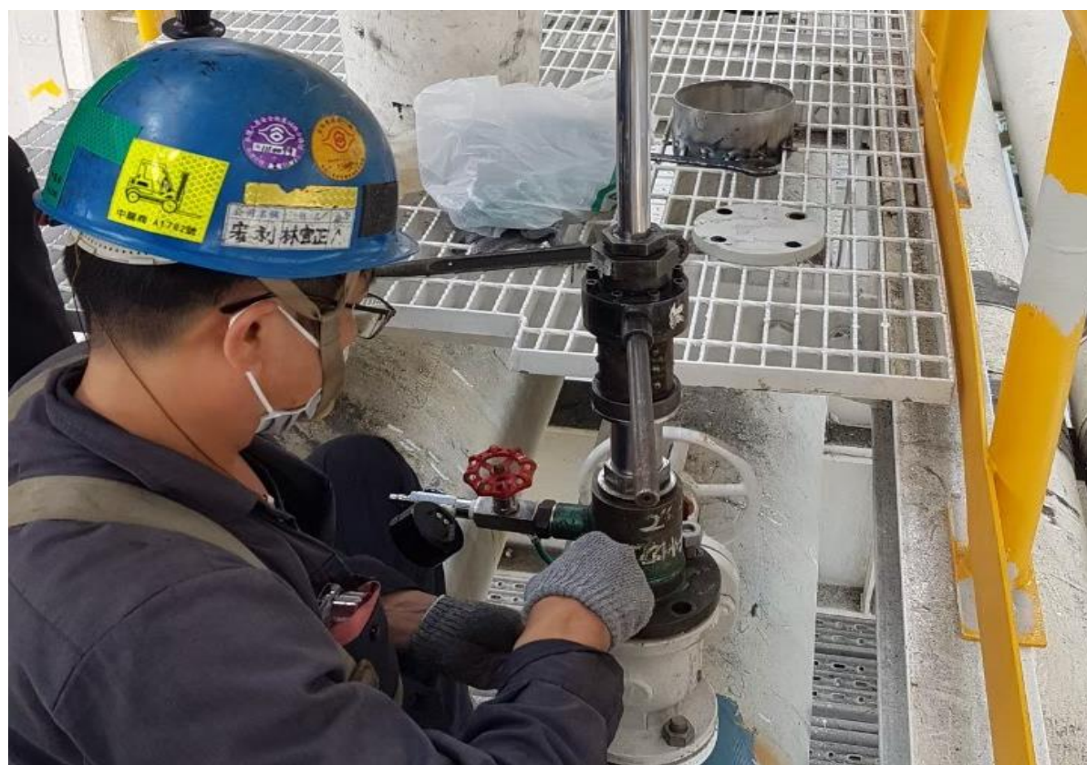
6. 管線安裝開孔機後進行開孔作業
