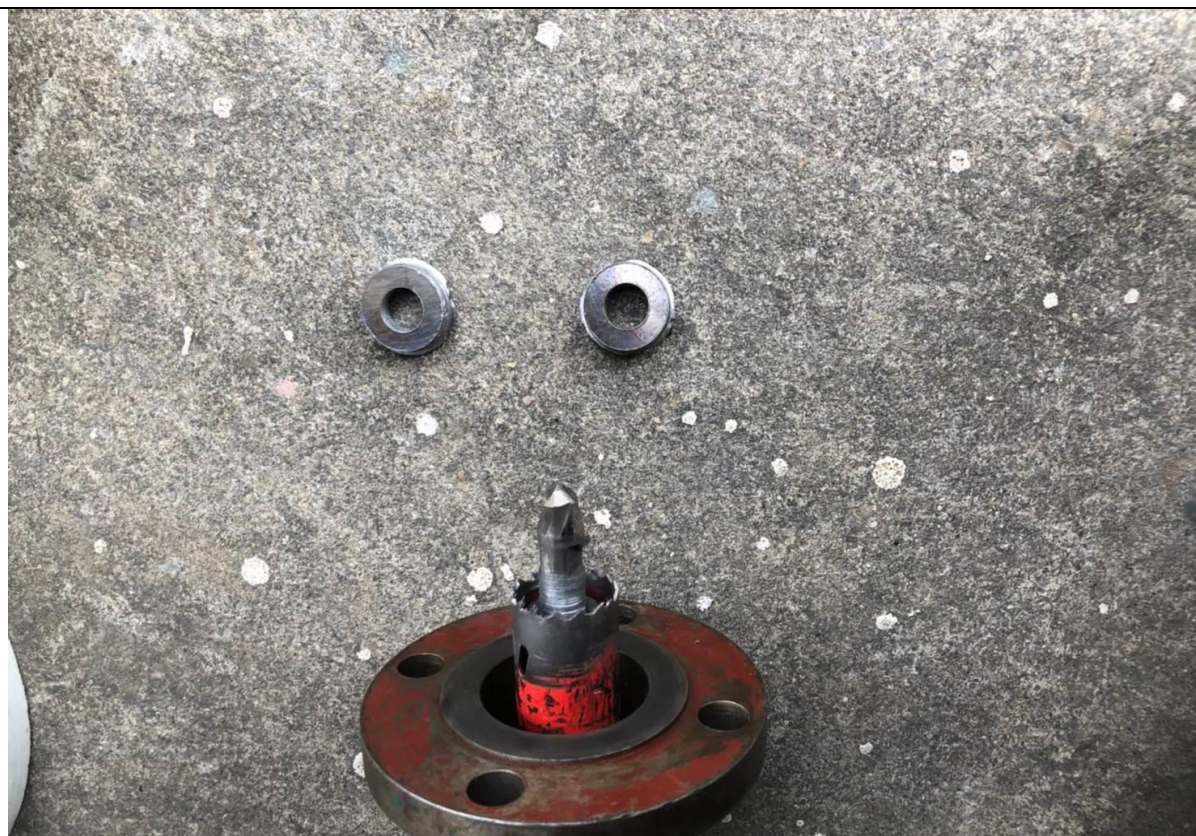
11. 管線開孔完成確認鐵片取出情形
