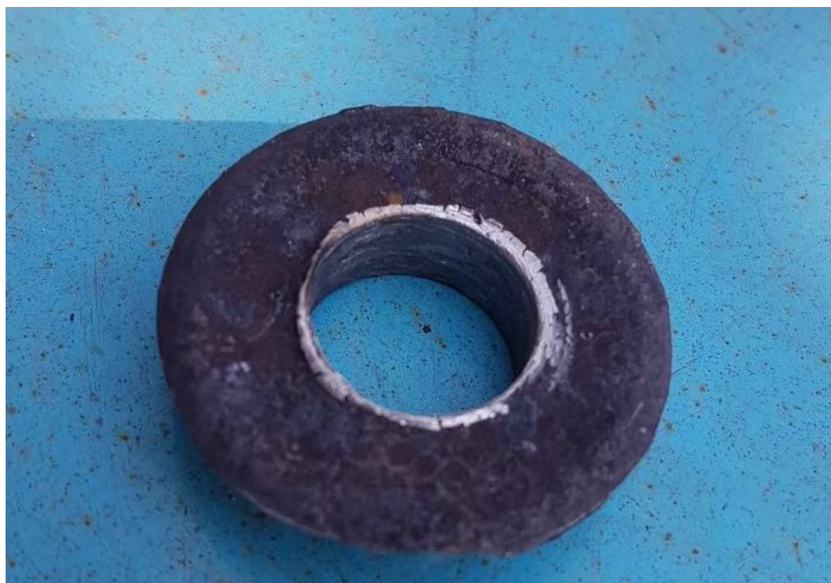
9. 管線開孔完成確認鐵片取出情形
