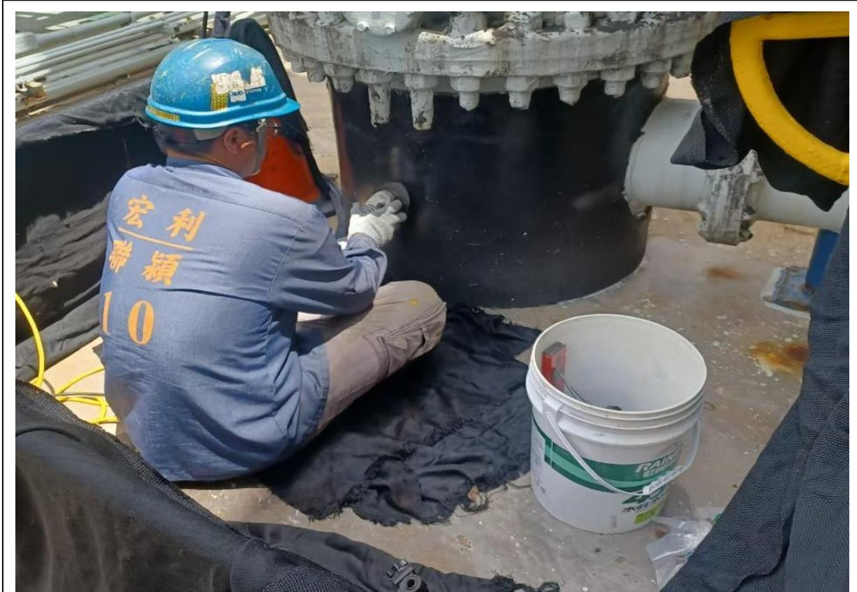
1. 管線研磨作業時防火毯鋪設情形
