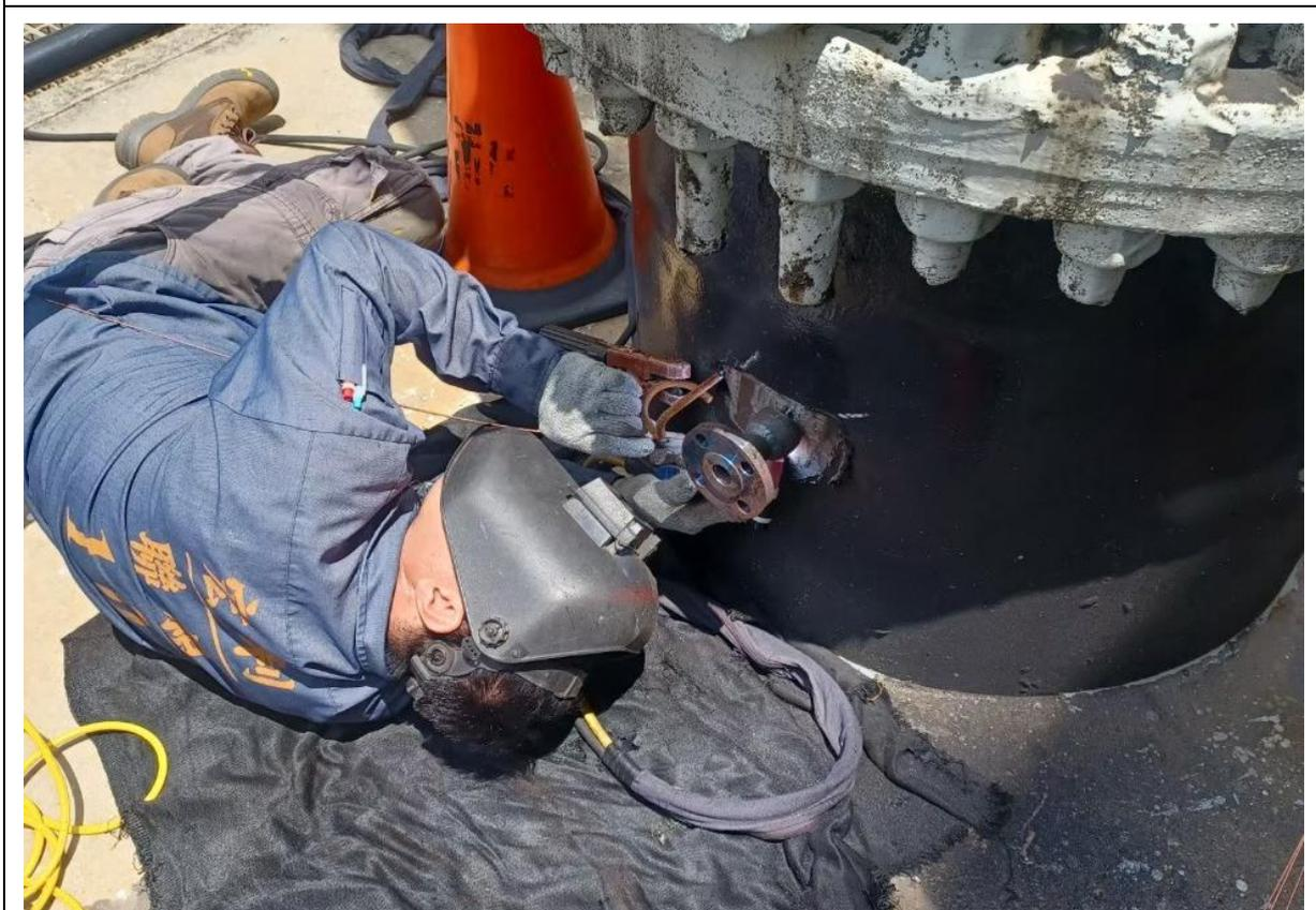
2. 短管法蘭焊接作業
