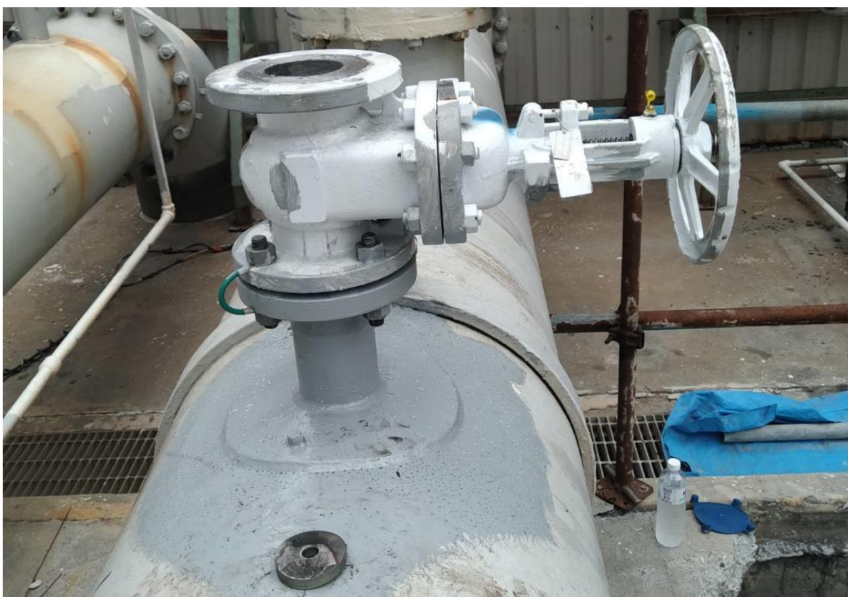
4. 開孔完成確認鐵片取出
