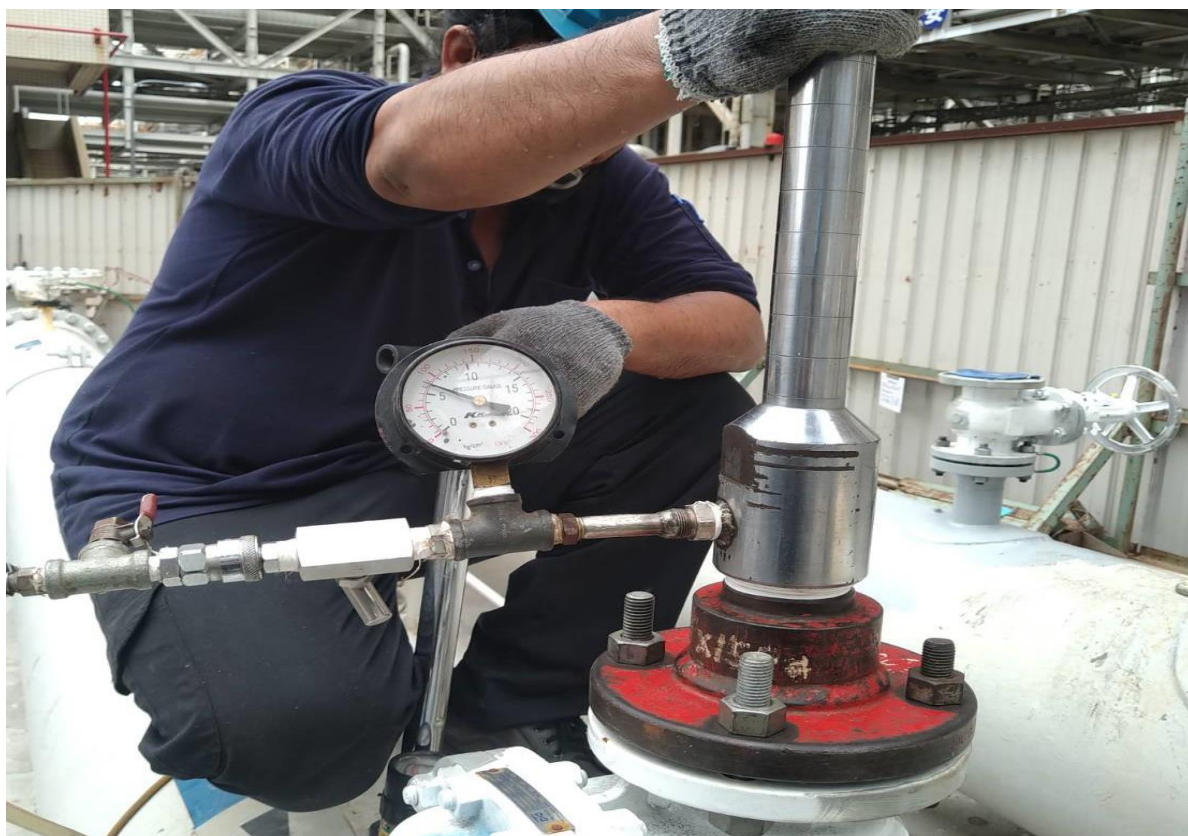
3. 人員執行開孔作業
