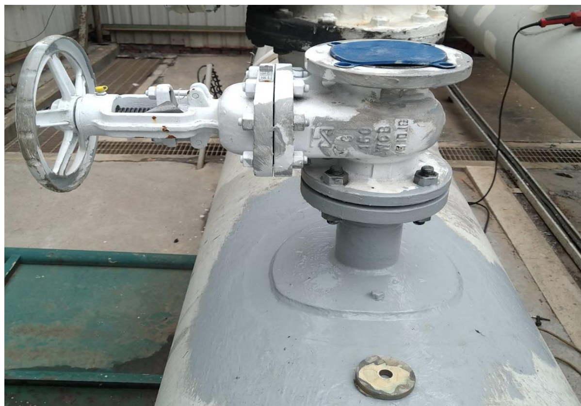
2. 開孔完成確認鐵片取出
