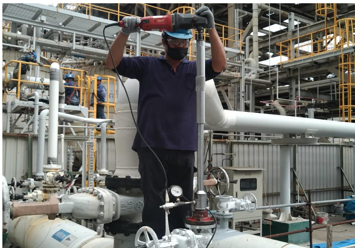
1. 人員執行開孔作業
