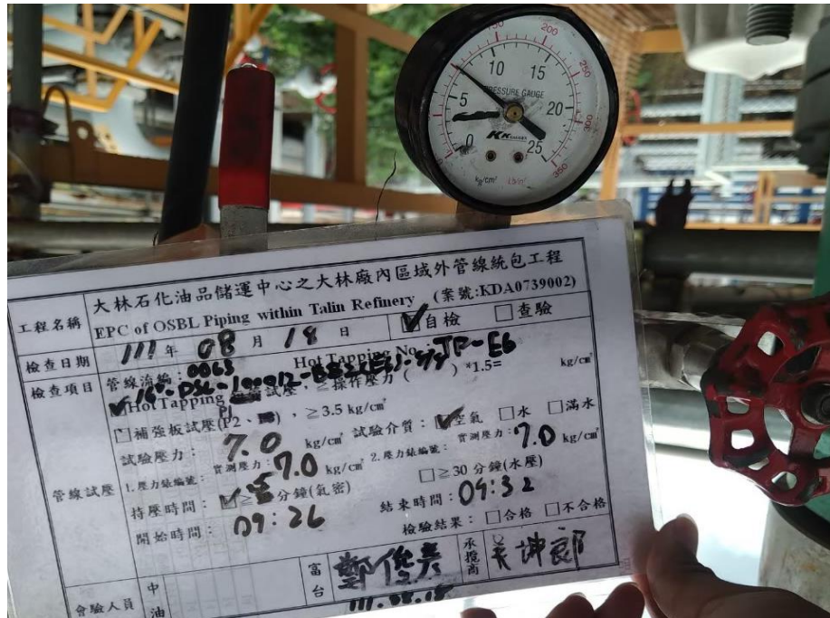
7. 施工前試壓作業
