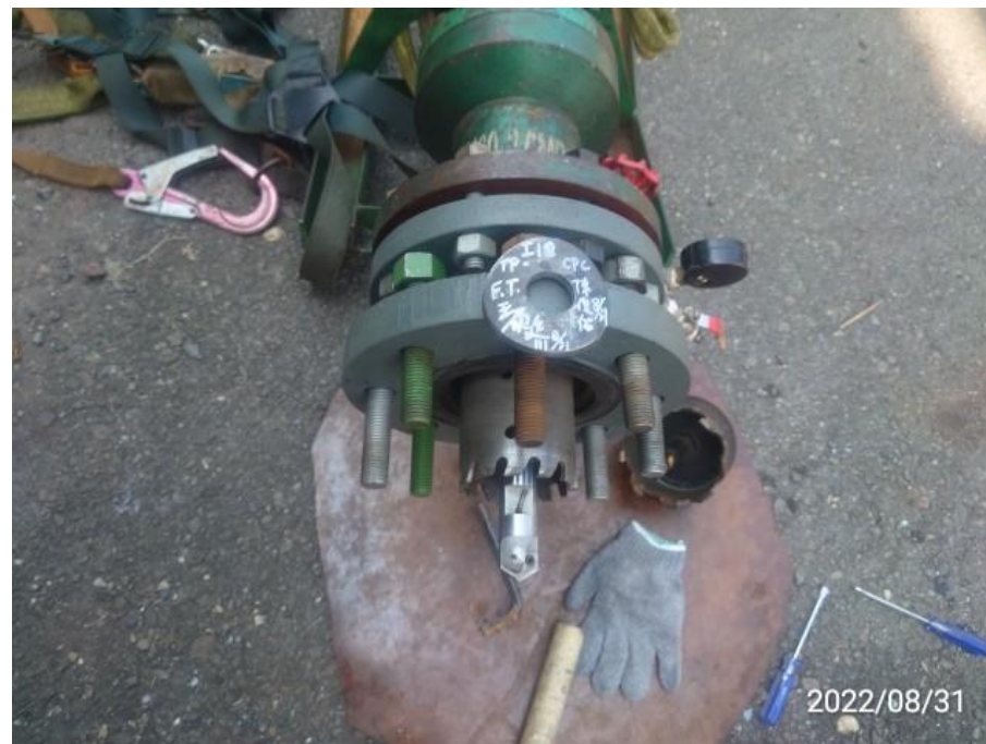
32. 開孔完成確認鐵片取出
