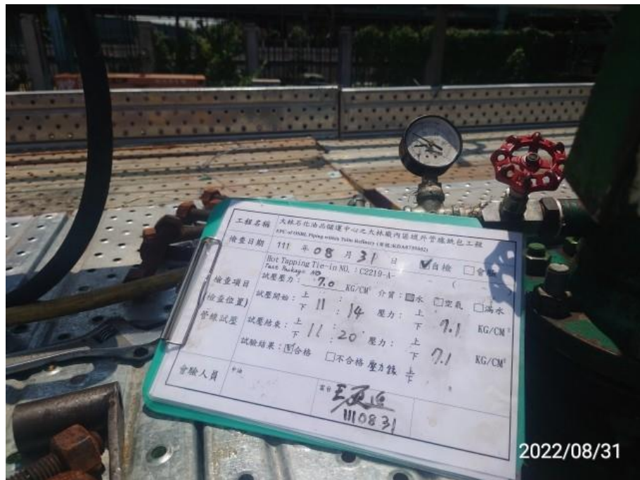
31. 人員進行開孔作業
