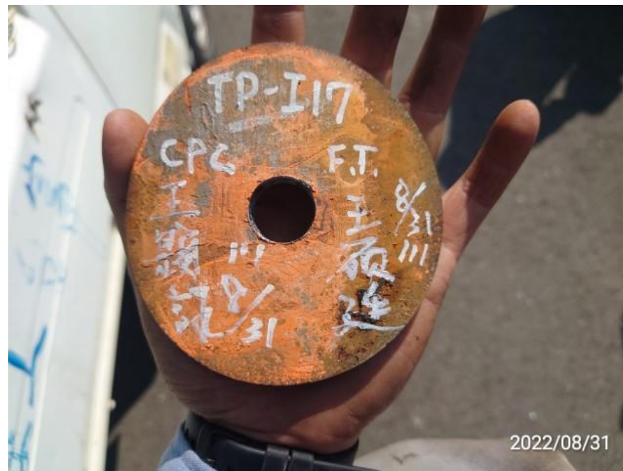
34. 開孔完成確認鐵片取出
