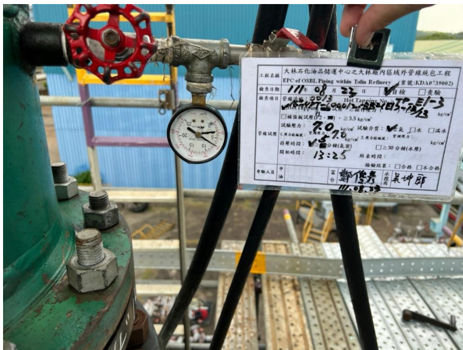
13. 施工前試壓作業
