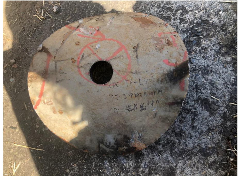
10. 開孔完成確認鐵片取出
