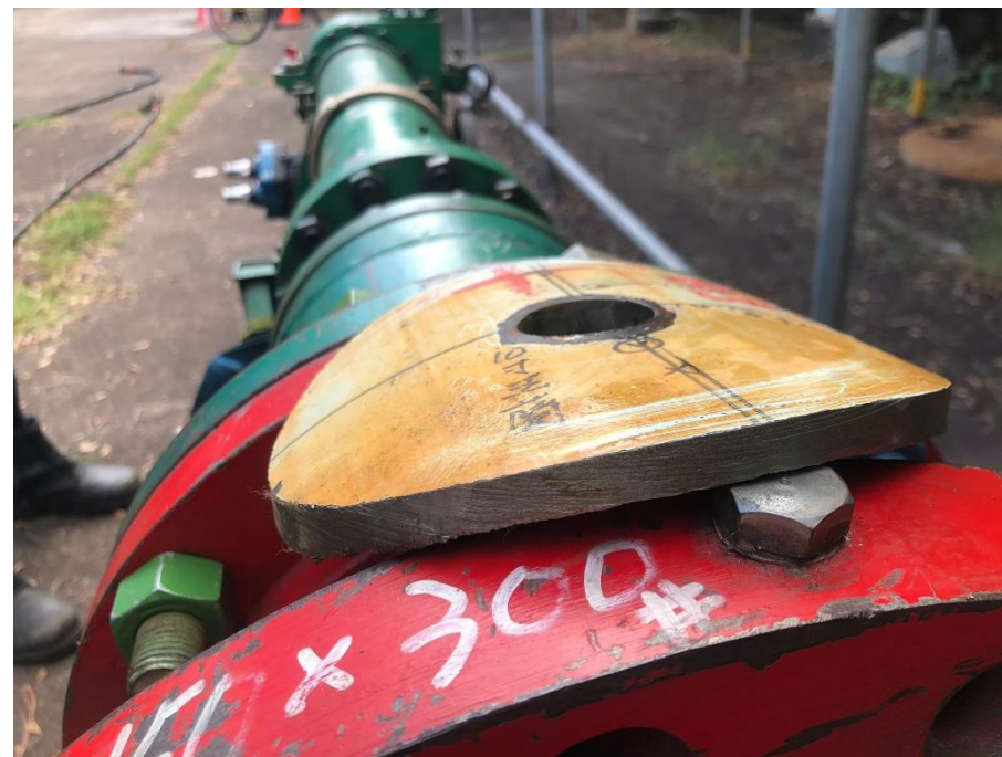
2. 開孔完成確認鐵片取出
