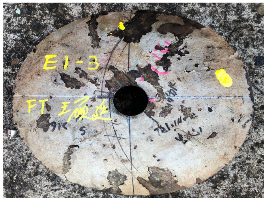
14. 開孔完成確認鐵片取出
