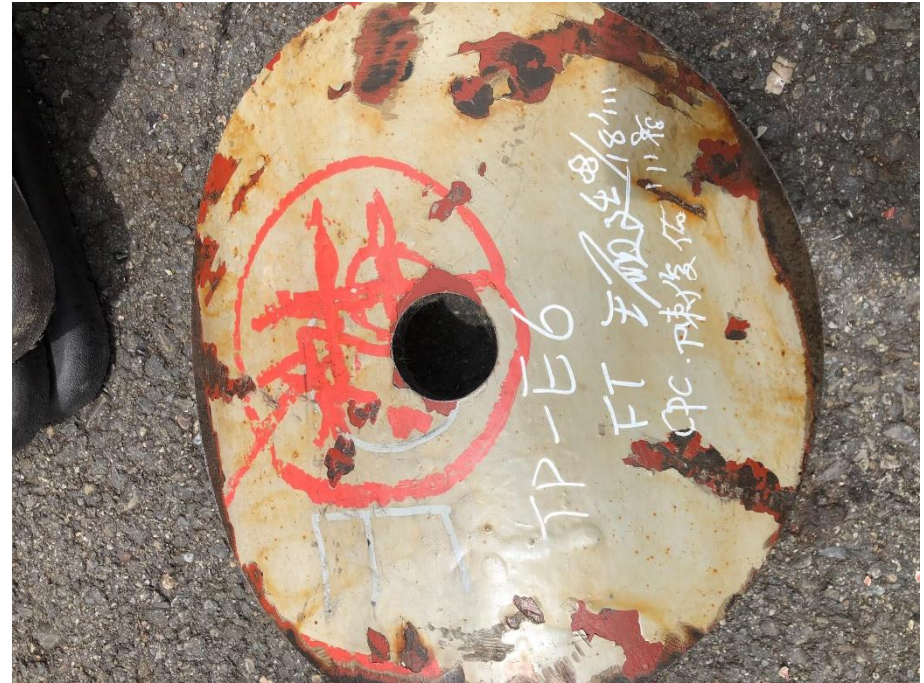
8. 開孔完成確認鐵片取出
