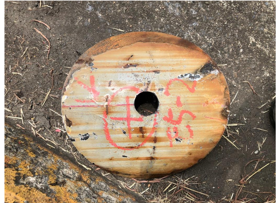
12. 開孔完成確認鐵片取出
