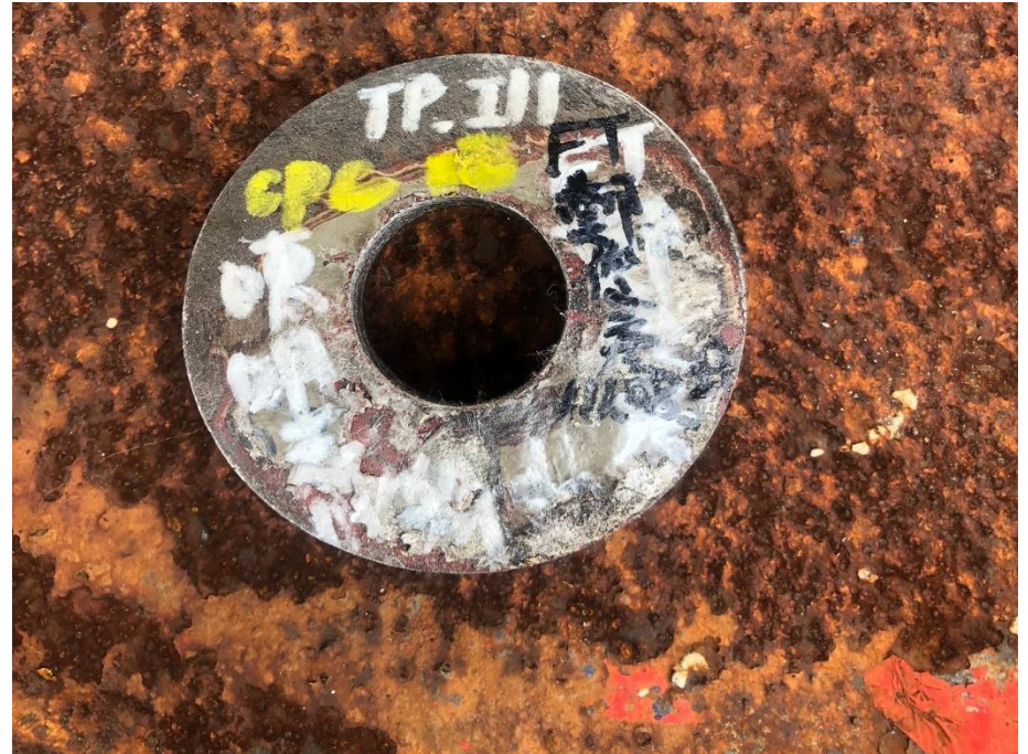
24. 開孔完成確認鐵片取出
