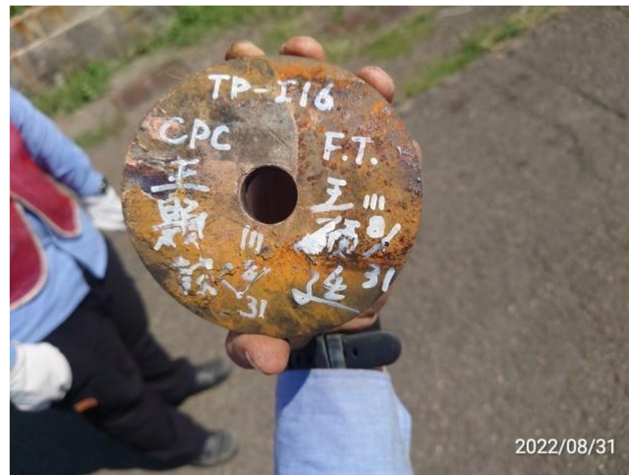
30. 開孔完成確認鐵片取出
