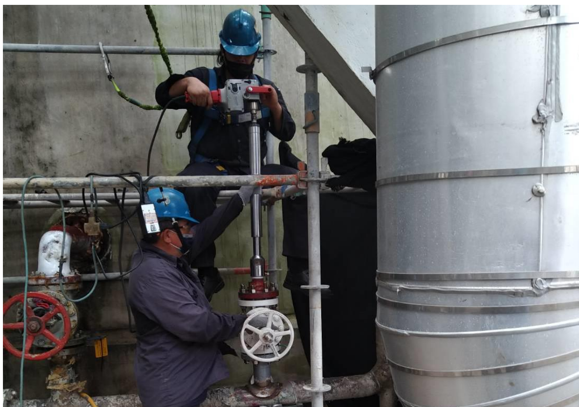
6. 管線安裝開孔機後進行開孔作業
