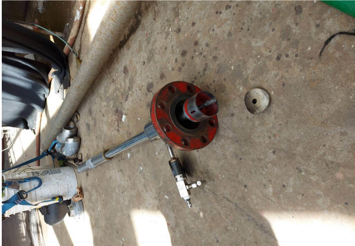
7. 管線開孔完成確認鐵片取出情形
