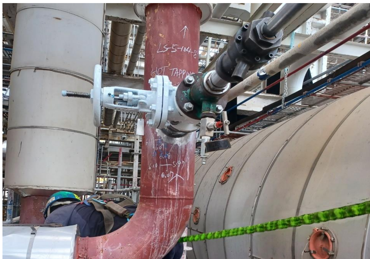
1. 開孔機安裝情形
