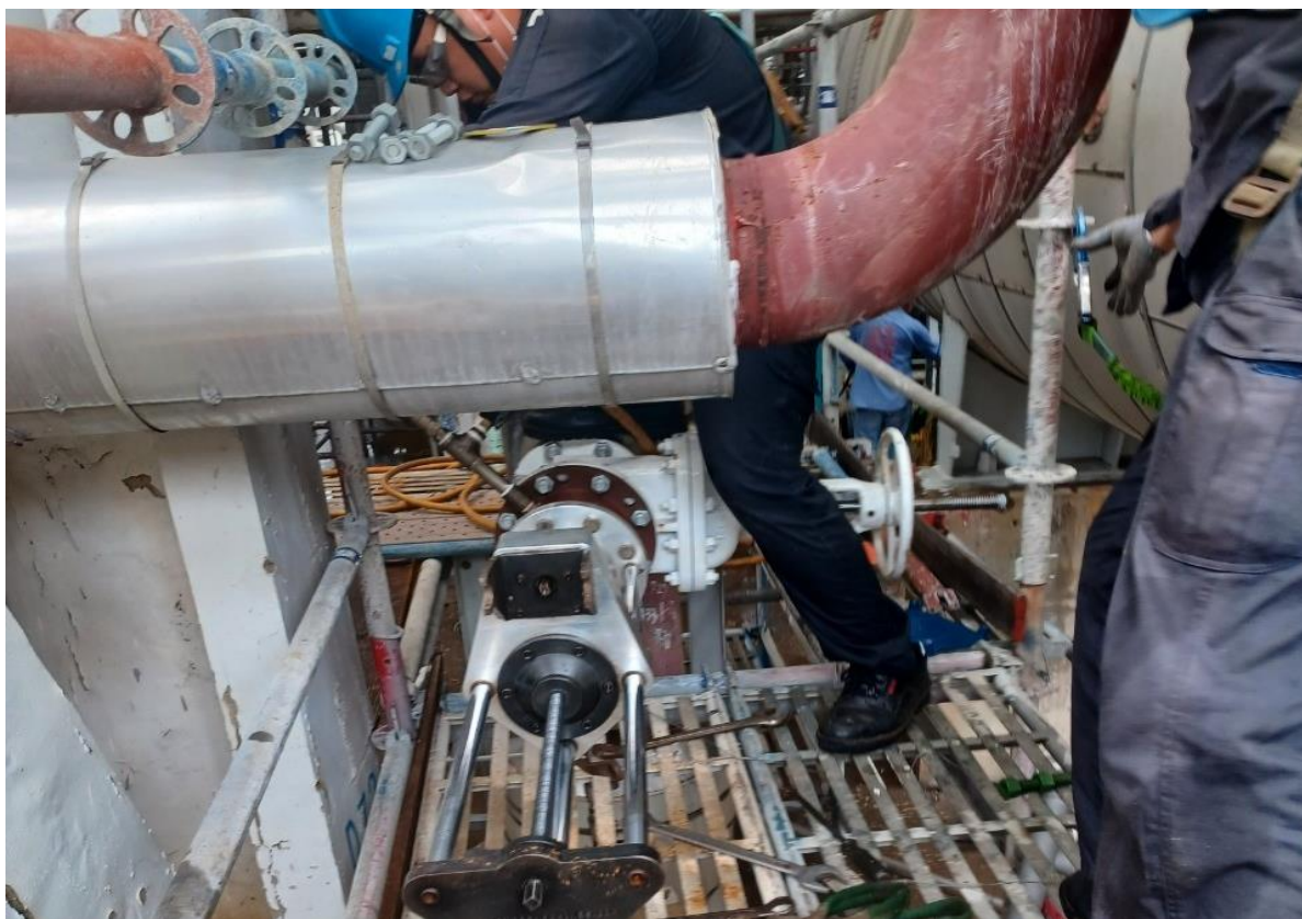
3. 短管法蘭焊接作業
