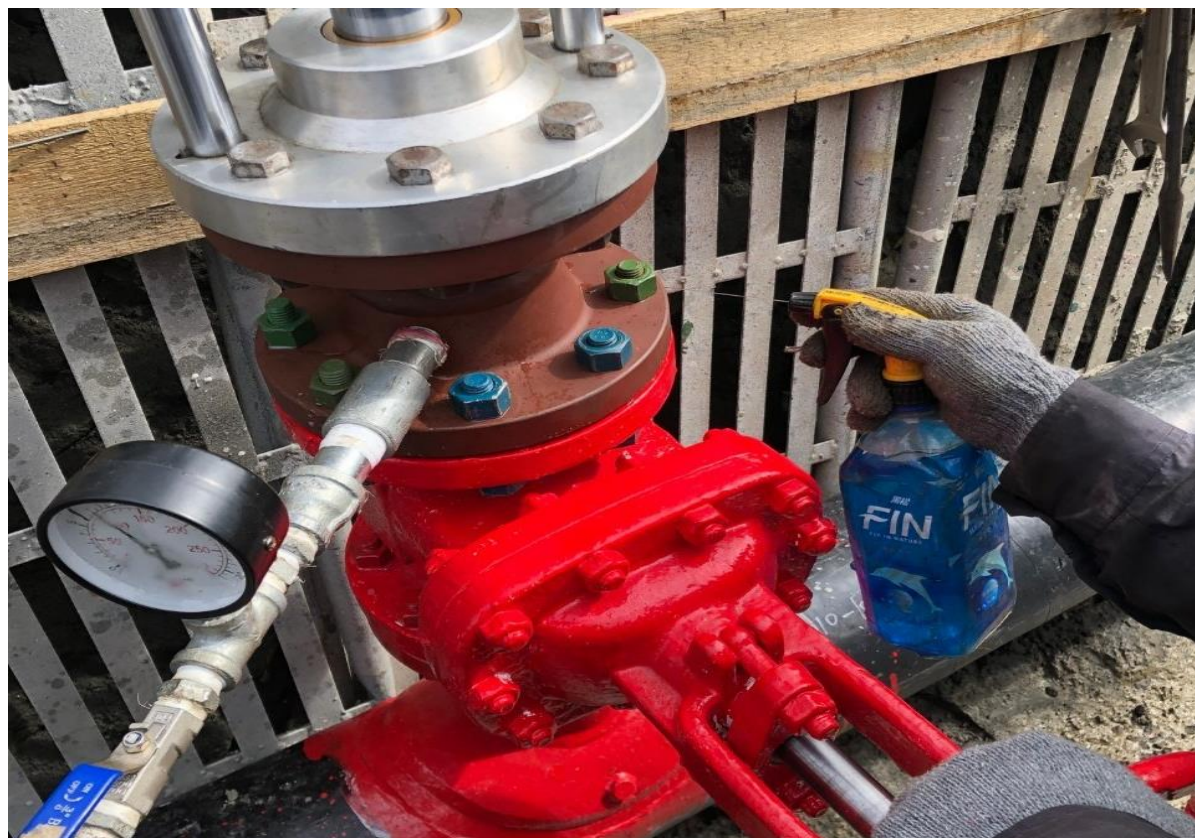
3. 4"開孔前試壓抓漏
