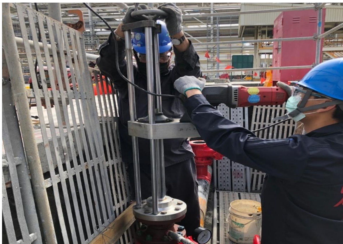
4. 人員安裝開孔機後進行開孔作業(4")
