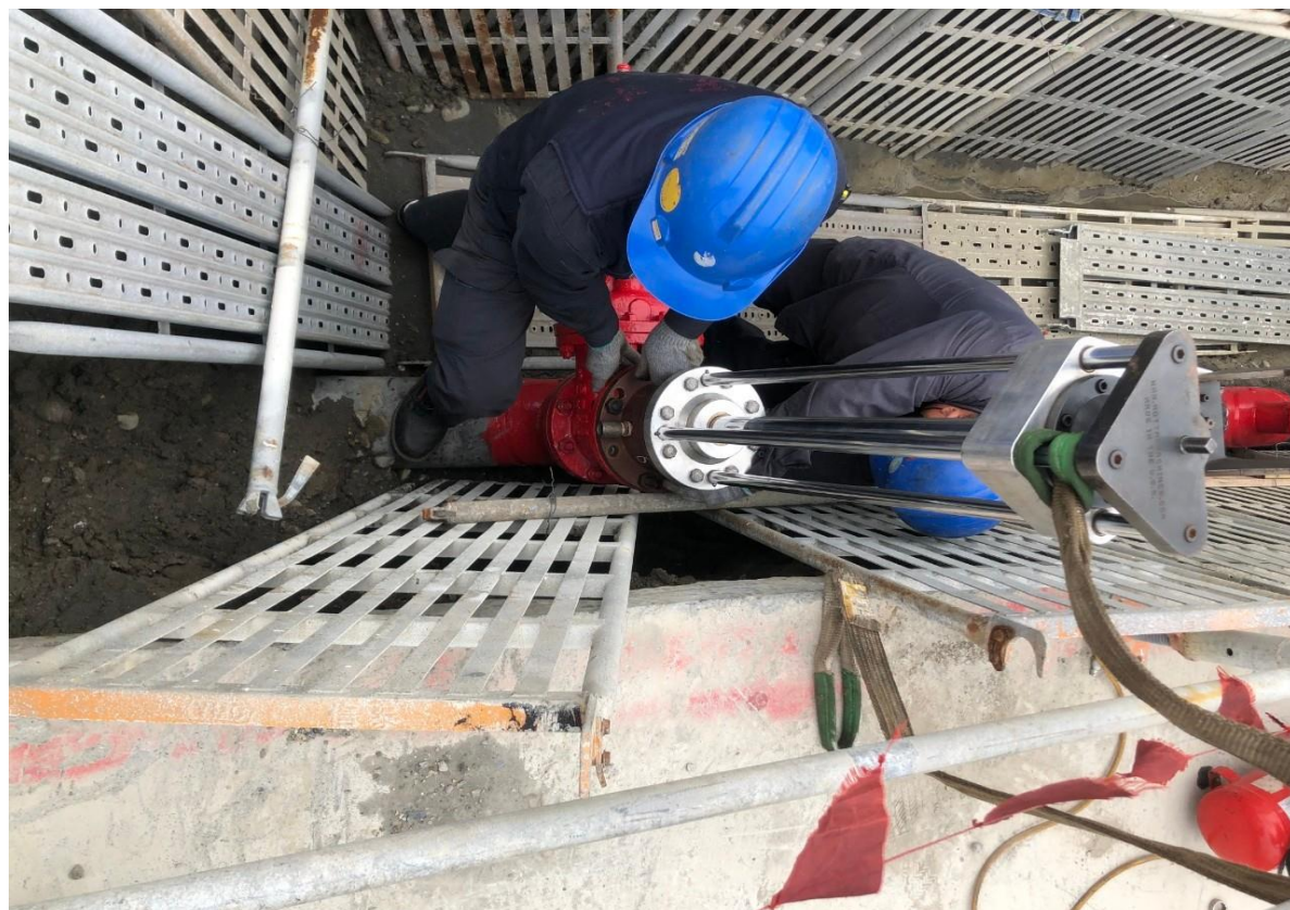
5. 安裝開孔機具(4")
