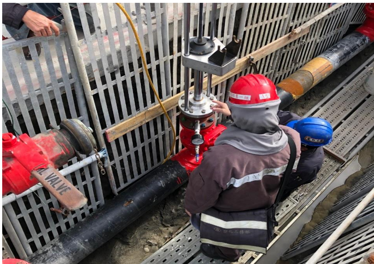
6. 開孔完成，業主確認
