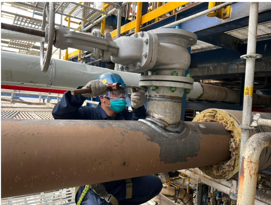
7. 閘閥安裝情形
