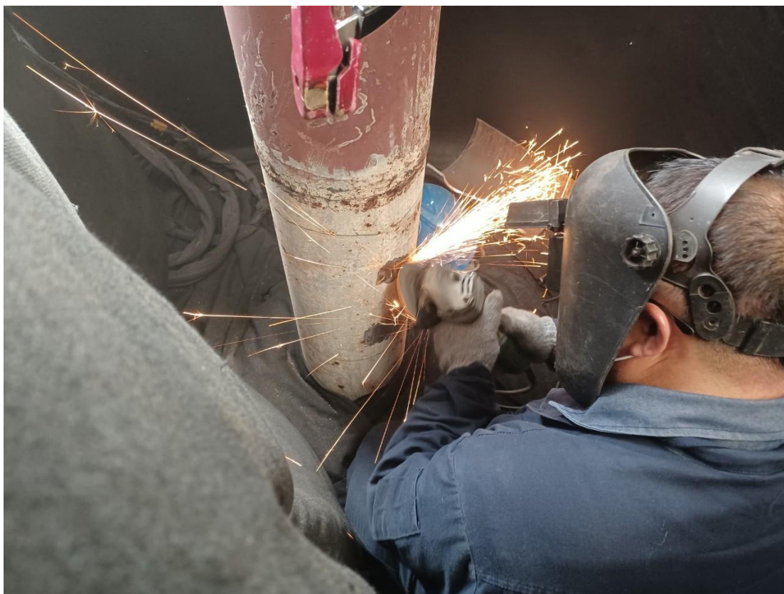
3.施作位置確認後進行研磨作業
