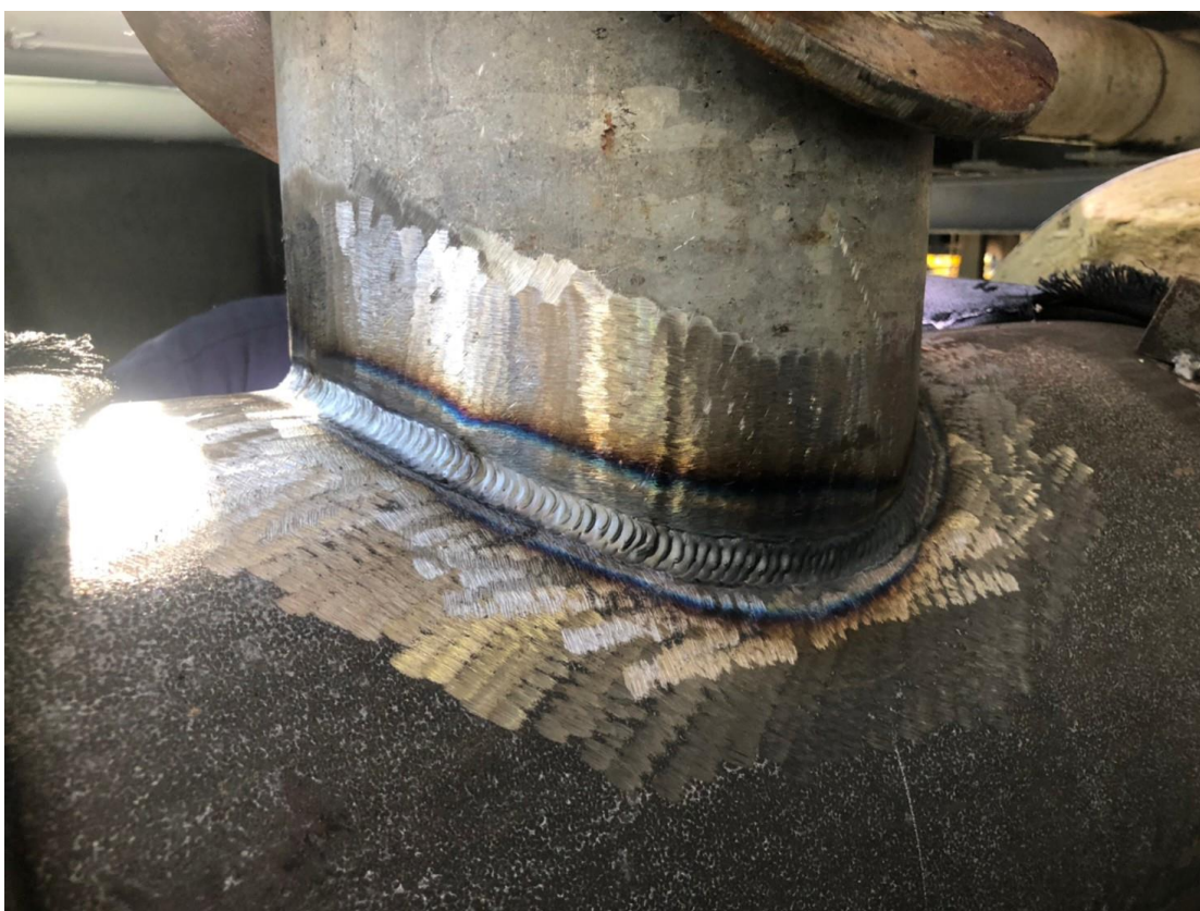
4. 短管焊接情形
