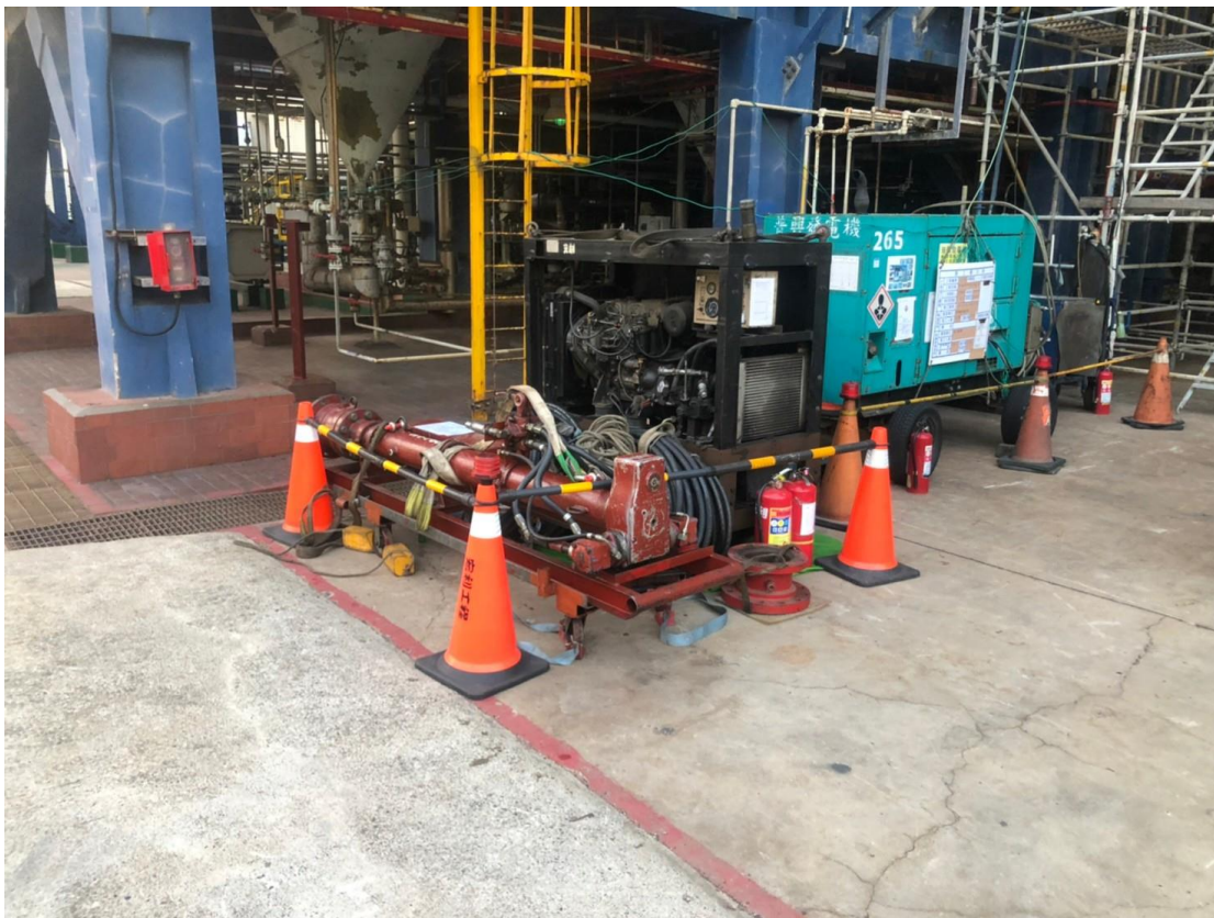
1. 開孔機具安裝作業
