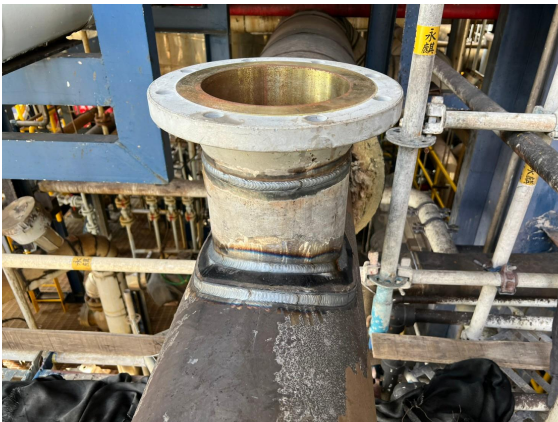
5. 補強板焊接完成情形
