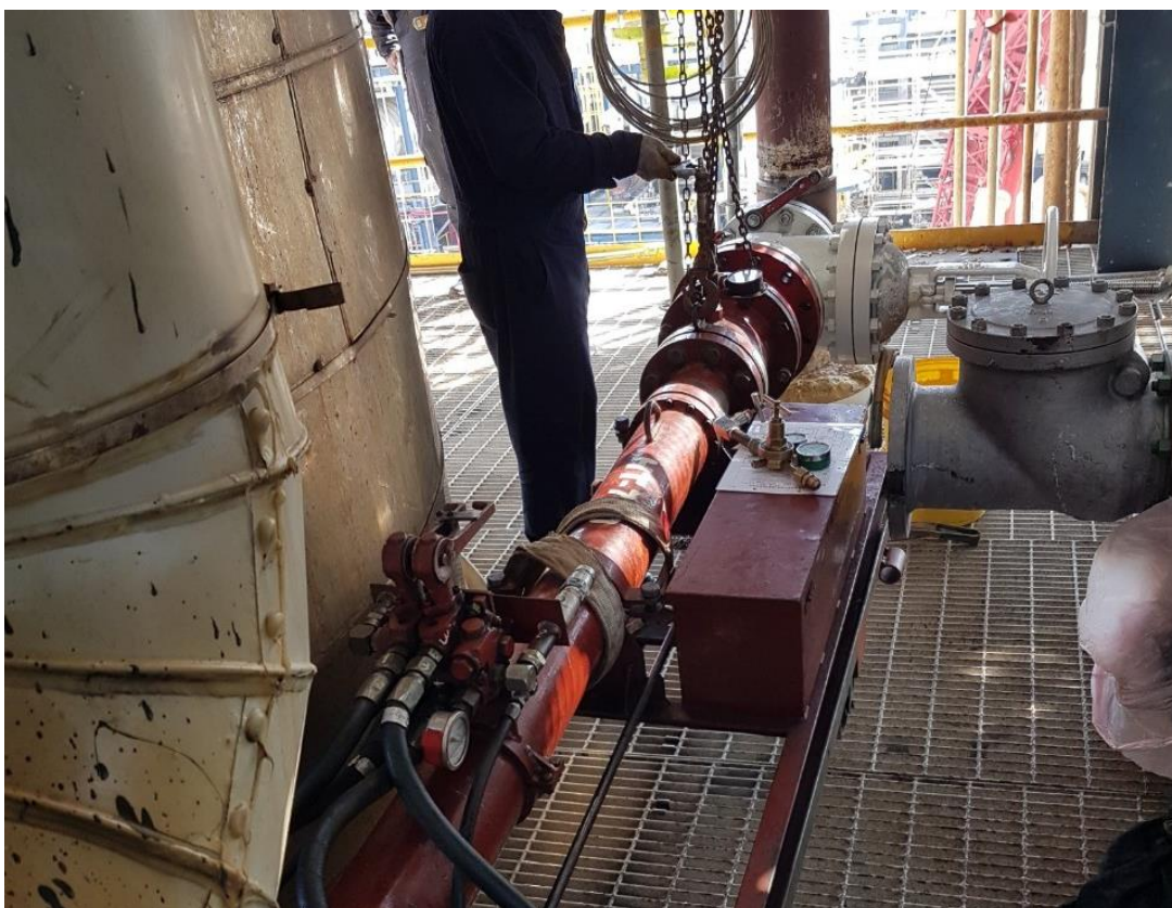
10. 安裝閘閥及開孔機情形
