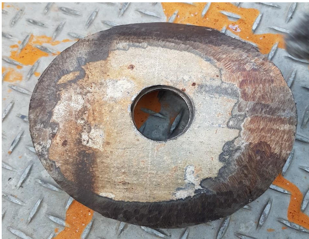
9. 開孔完成確認鐵片取出
