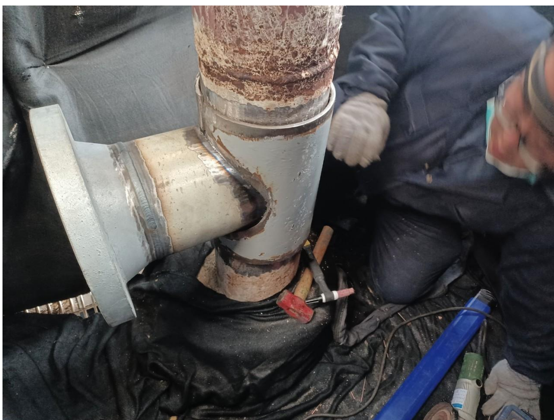
6. 同徑插管管線包覆焊接情形
