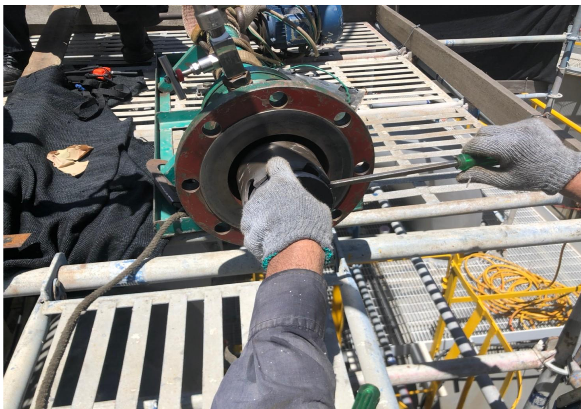
4. 開孔完成，確認鐵片取出
