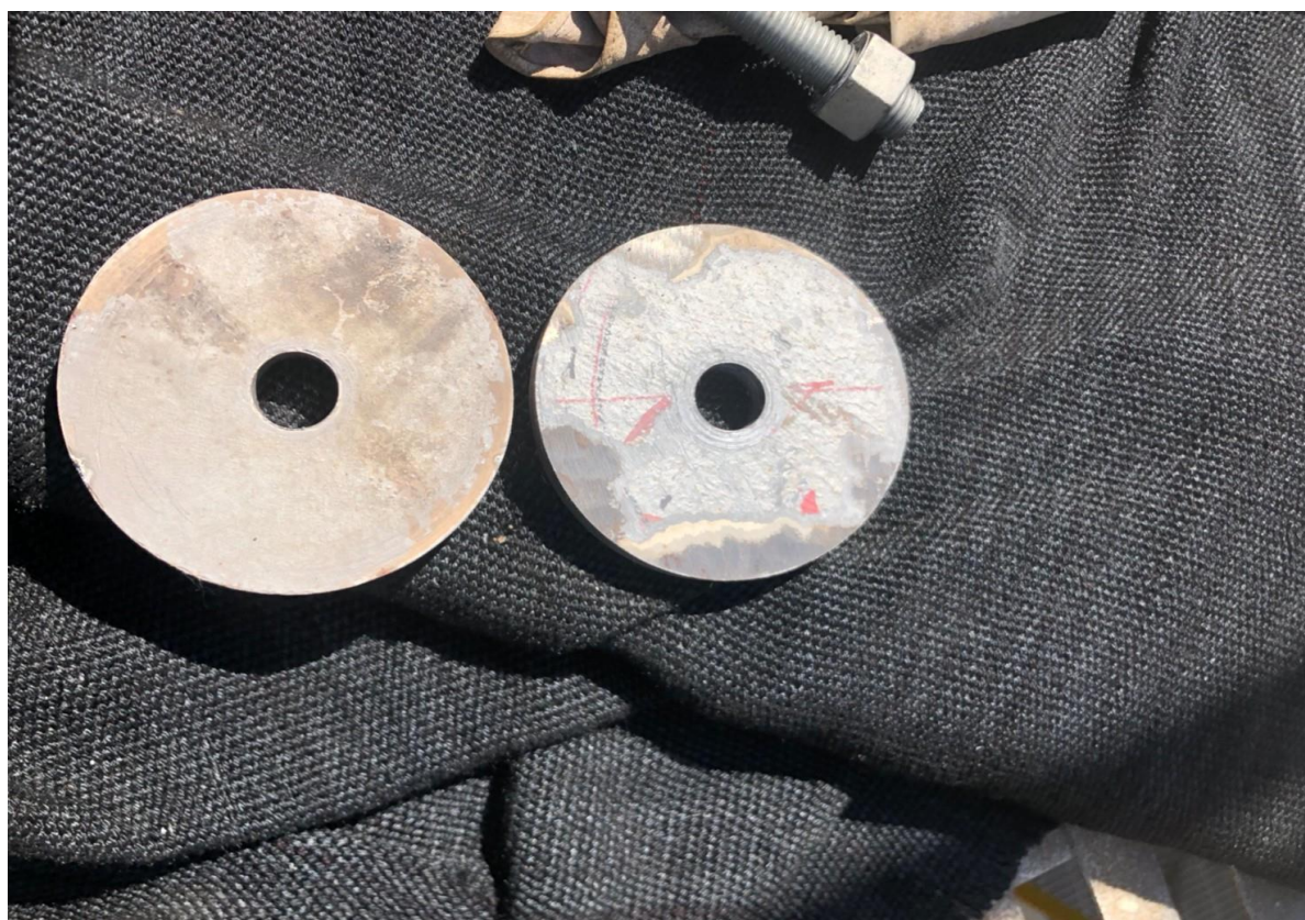
8. 線上開孔完成
