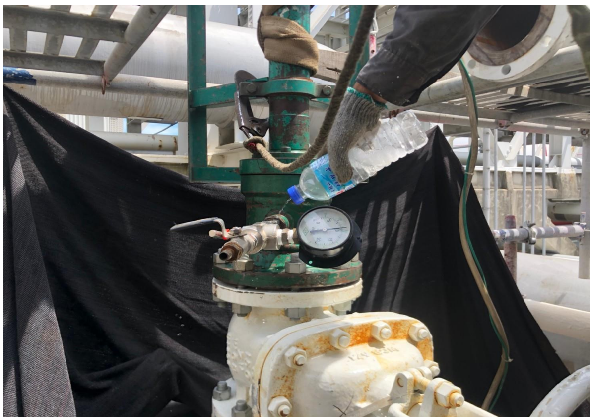
6. 試壓抓漏作業
