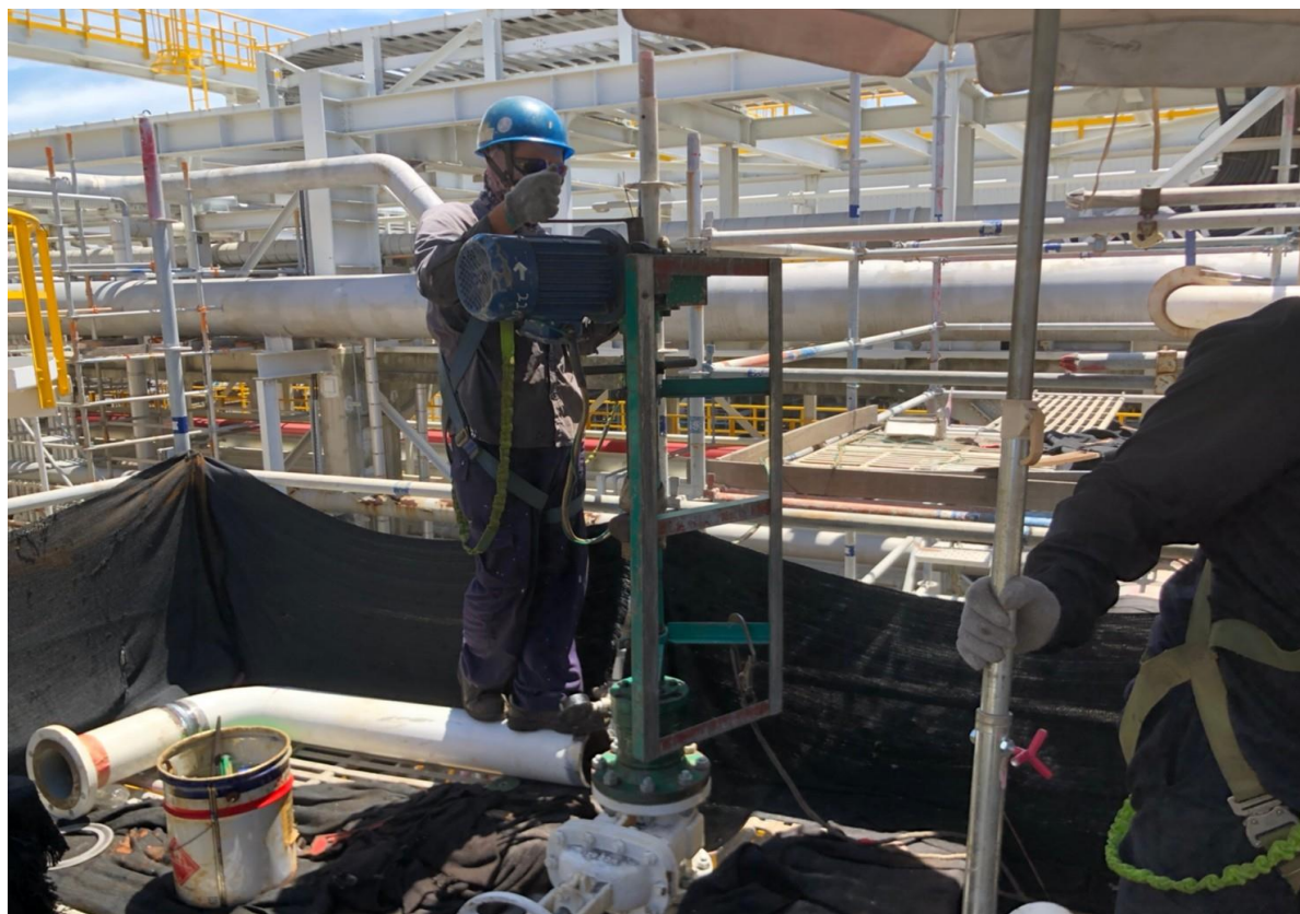
3. 人員進行開孔作業
