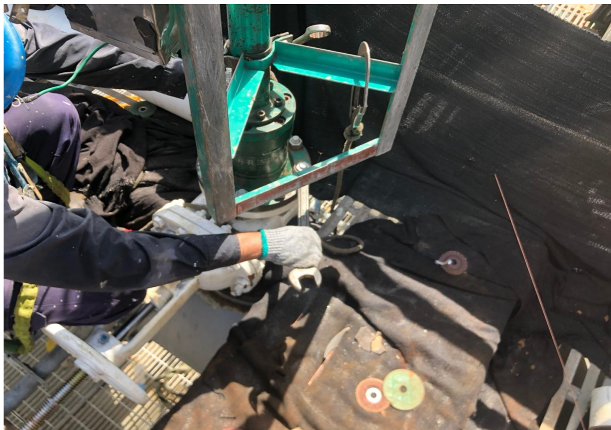
1. 開孔機具安裝作業
