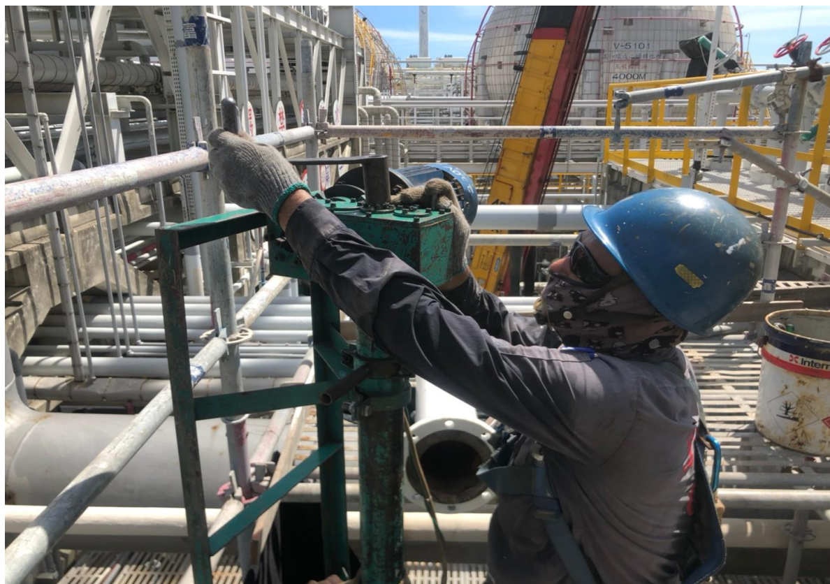
7. 人員進行開孔作業
