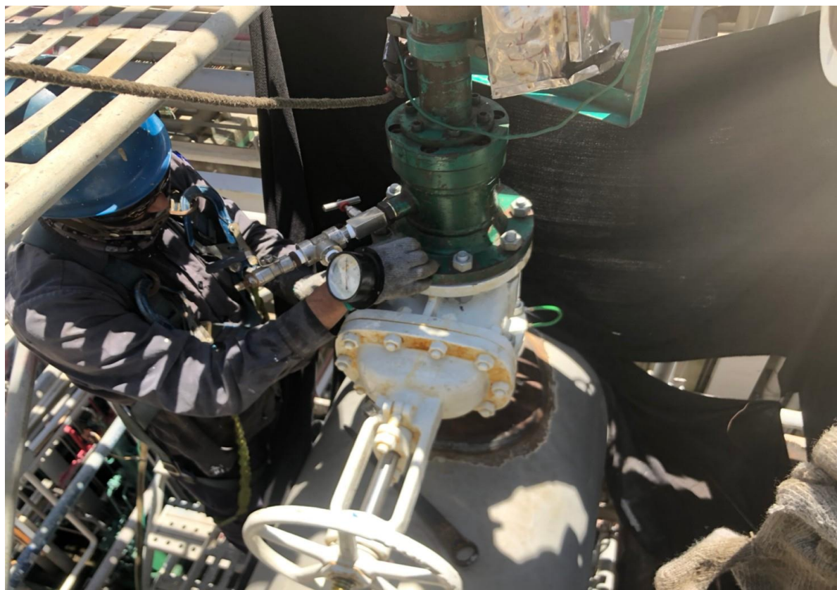
5. 開孔機安裝作業
