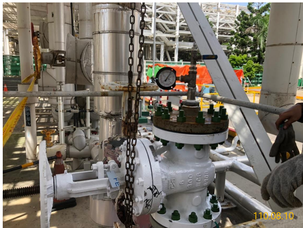
6. 人員進行管路試壓作業
