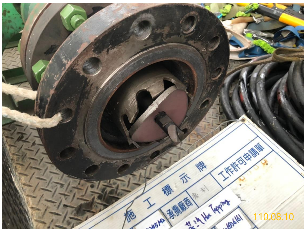
11. 開孔完成確認鐵片取出
