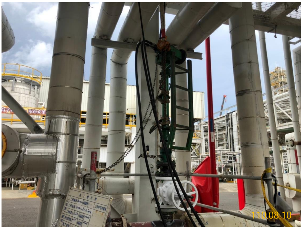
9. 開孔機安裝後並進行開孔作業
