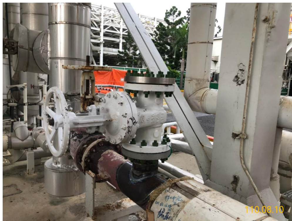
12. 施工完成，安裝盲法蘭
