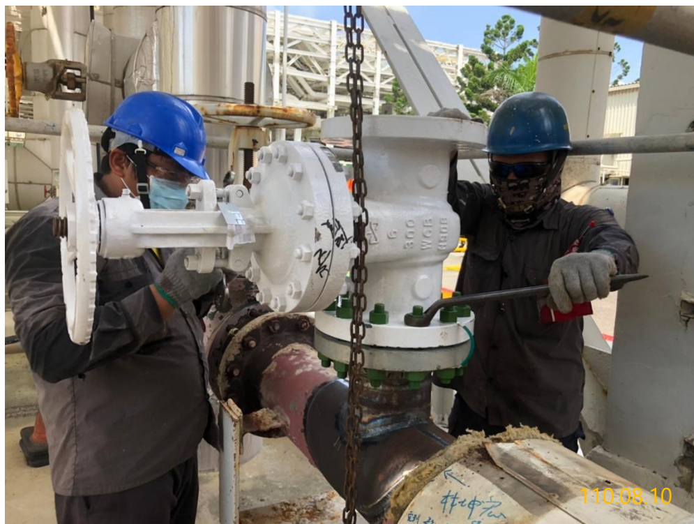
5. 6"x300lb 閘閥安裝作業
