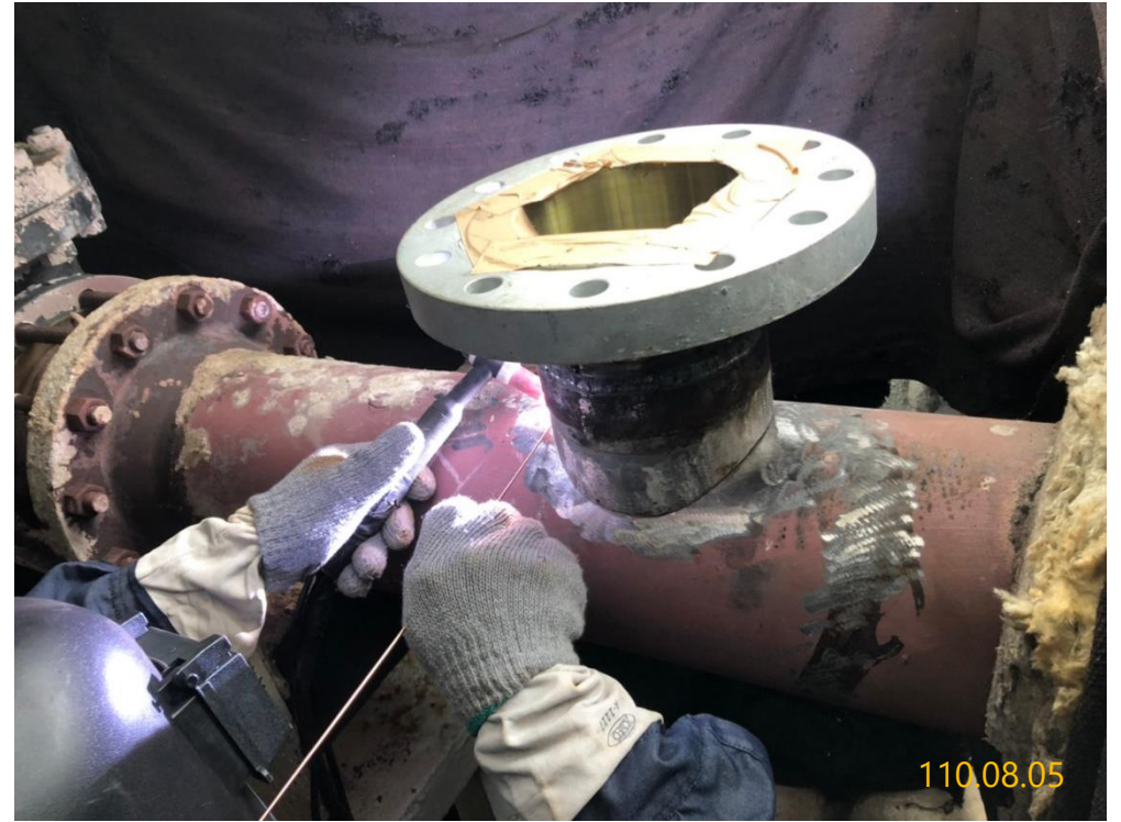
2. 管線研磨及短管法蘭組焊
