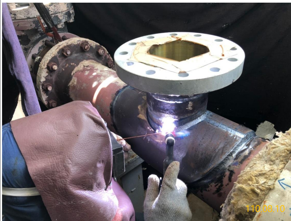
4.補強板焊接作業
