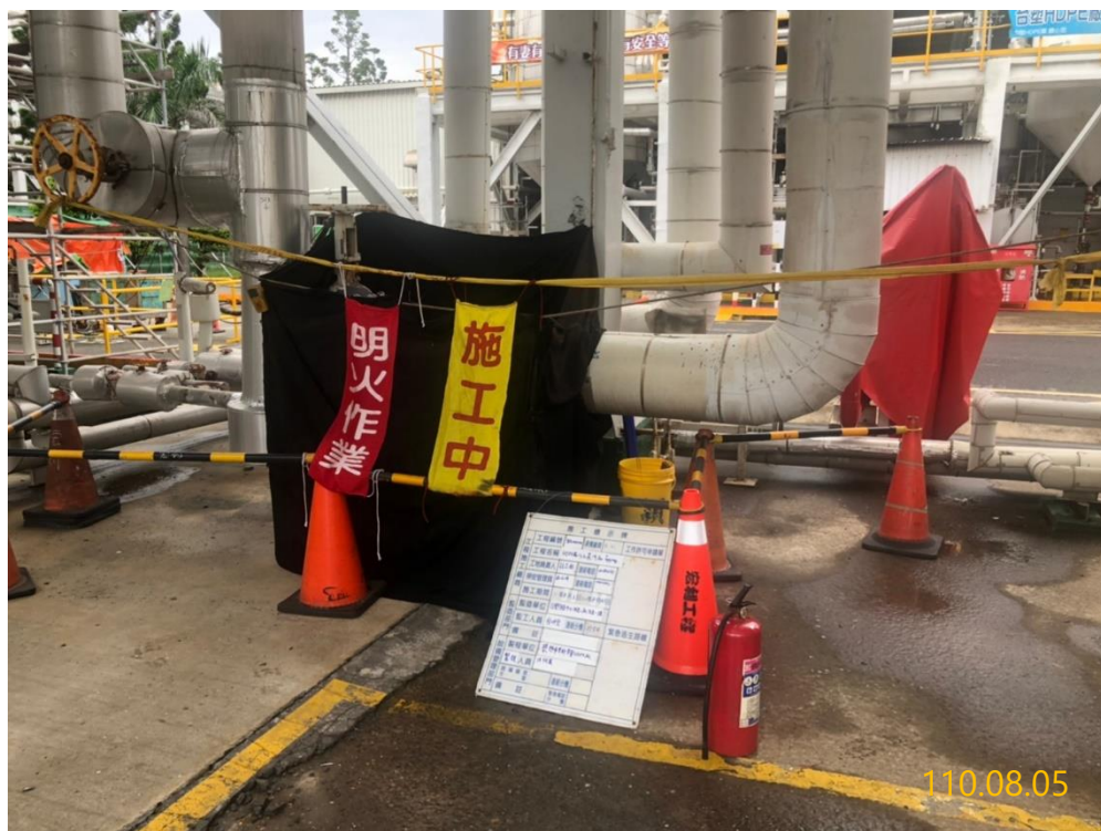
3.現場明火作業五面防護之情形
