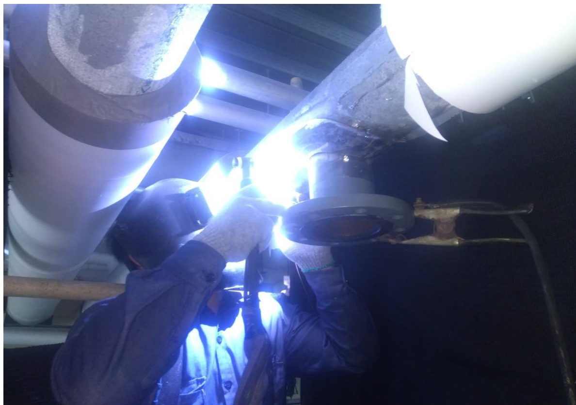
3. 管線 Tie-In 點焊接作業
