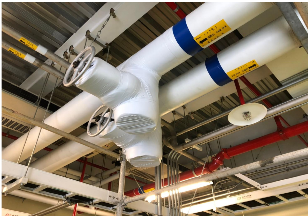
9. 施工完成，保溫復原
