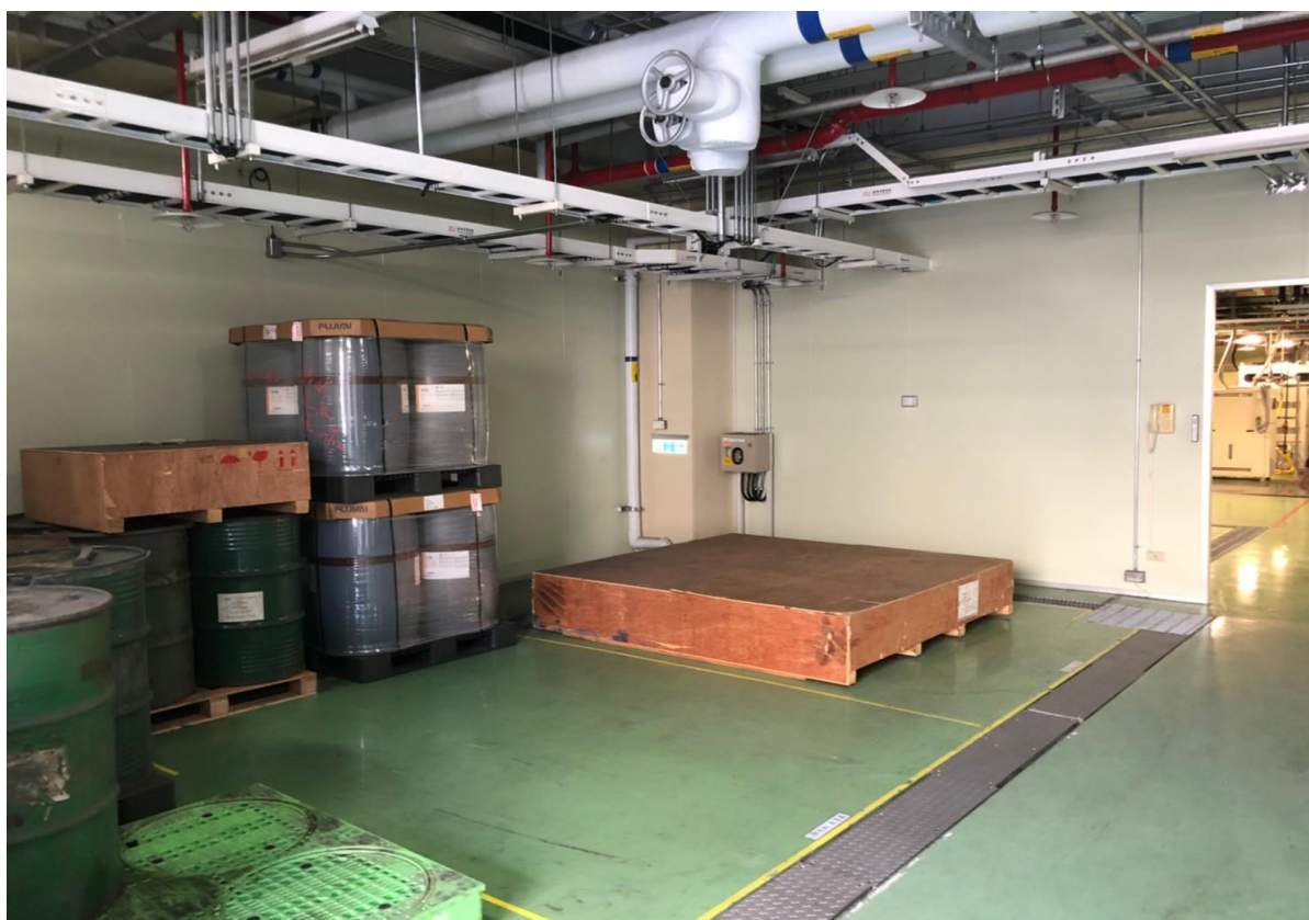
10. 施工完成環境整理及機具出廠
