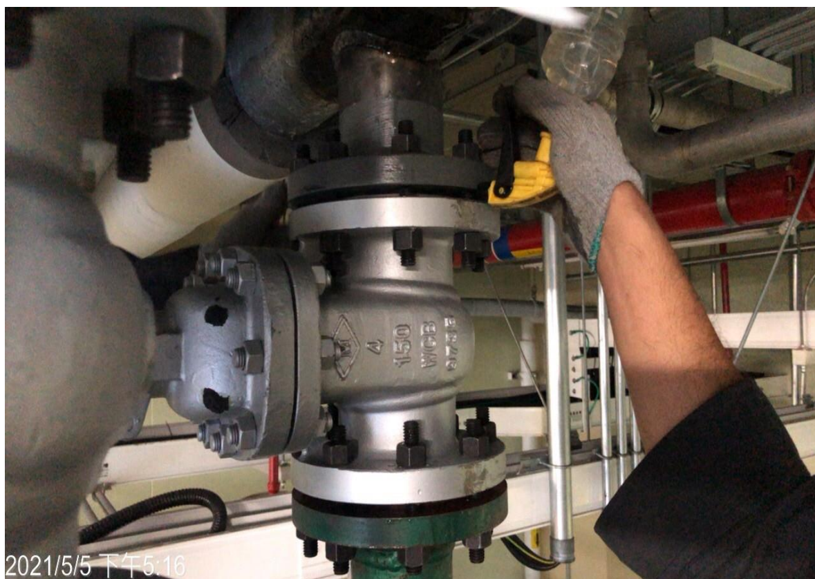
4. 閘閥安裝及試壓抓漏情形
