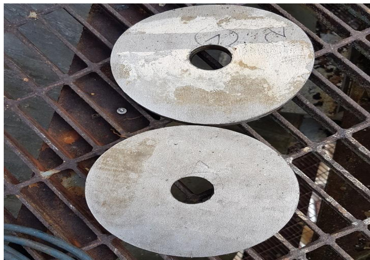
6. 人員開孔完成，確認鐵片取出(2)
