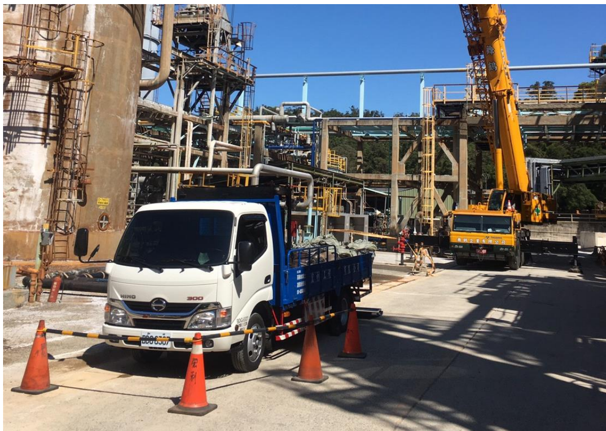
1. 機具定位並進行吊裝作業
