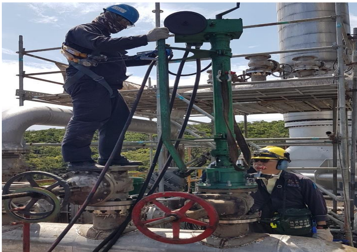
3. 人員進行開孔作業
