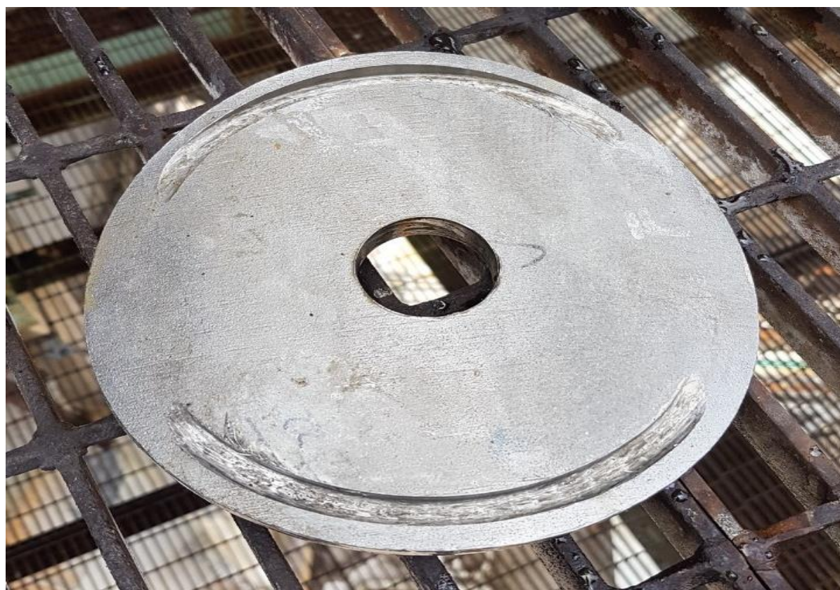
5. 人員開孔完成，確認鐵片取出(1)
