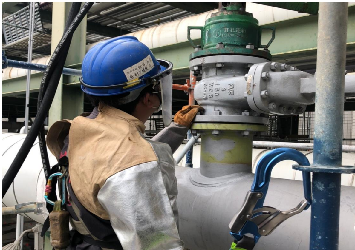
3. 人員進行開孔作業
