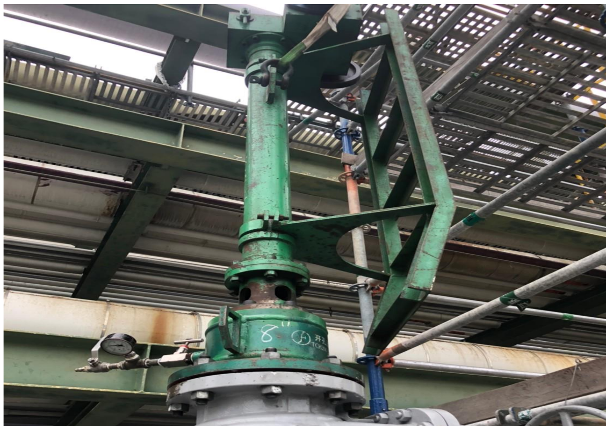
1. 開孔機安裝作業
