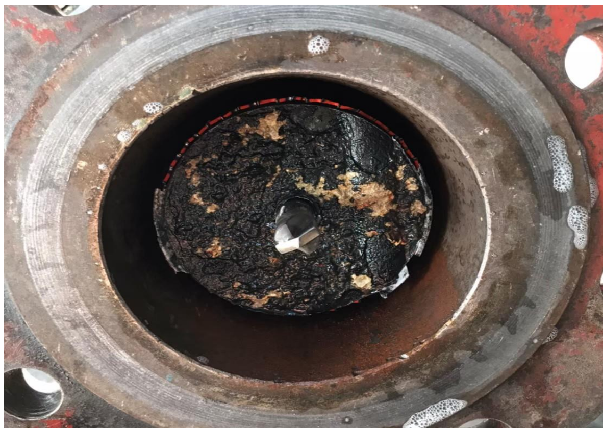
4. 人員開孔完成，確認鐵片取出
