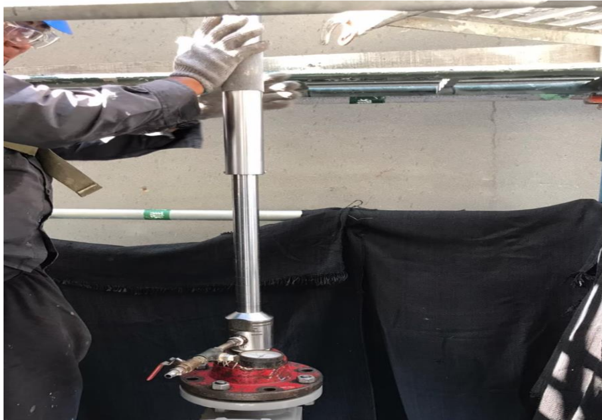
3. 人員進行開孔作業
