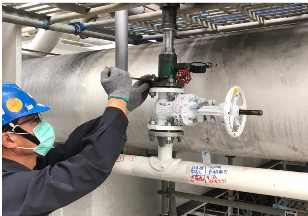
1. 開孔機安裝作業
