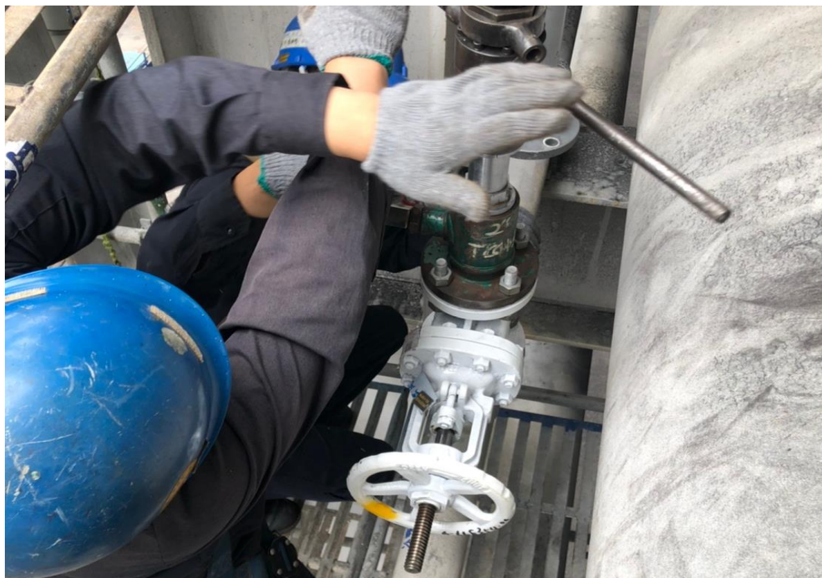
3. 人員進行開孔作業
