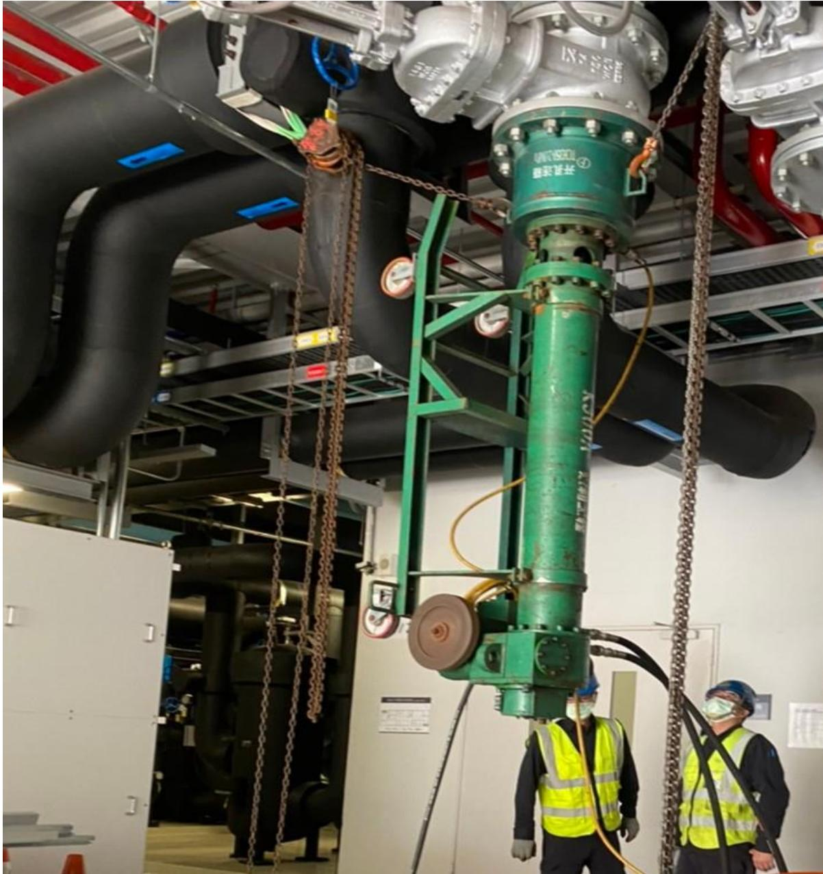
工程名稱：中部電子廠 14 吋冰水管活水開孔工程
