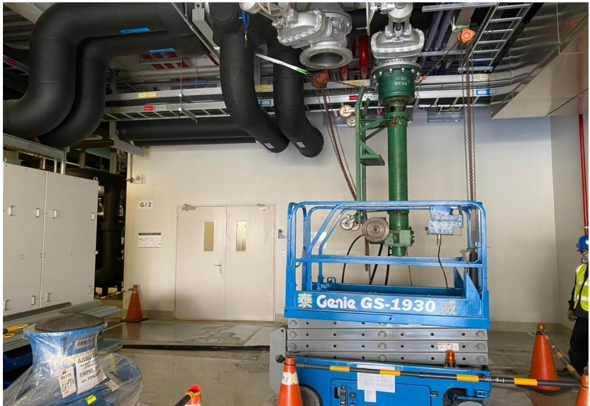
10. 開孔機具吊裝並進行開孔作業
