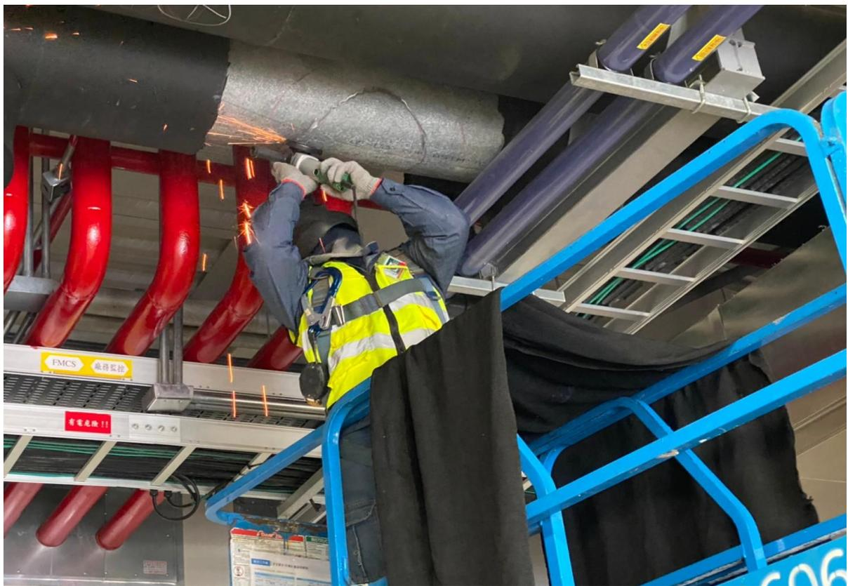
2. 施工管線進行管線研磨作業
