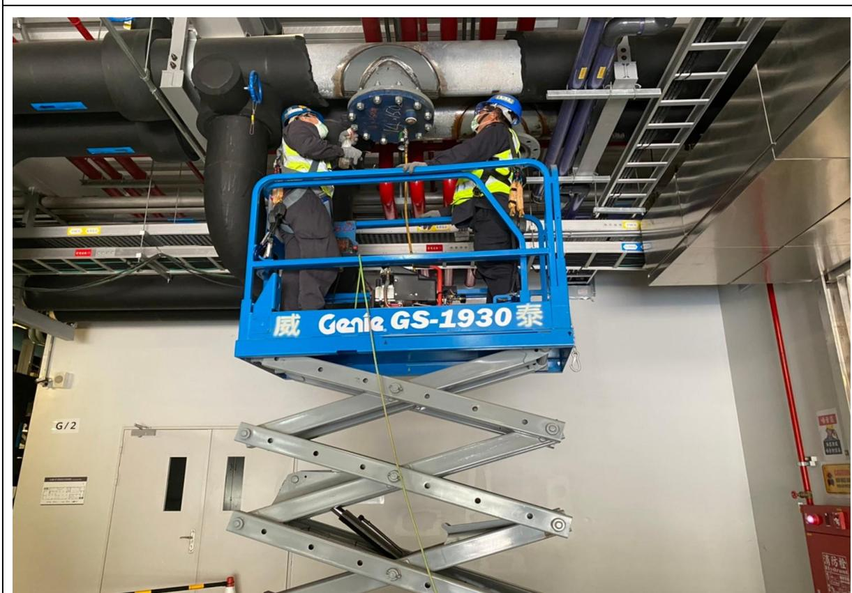
4. 管線焊接完成進行試壓作業
