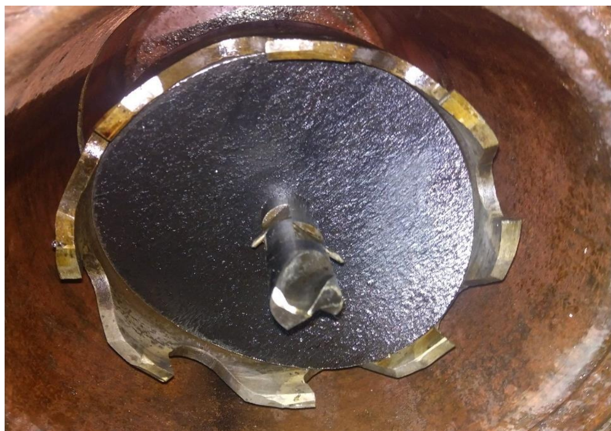
4. 開孔完成，確認鐵片取出
