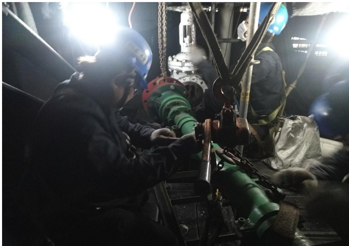
1. 開孔機安裝作業
