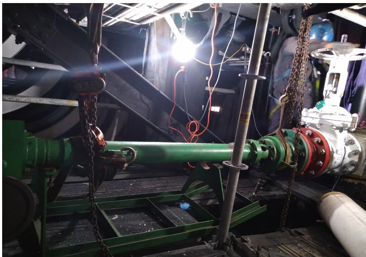
3. 人員開孔完成，閘閥關閉
