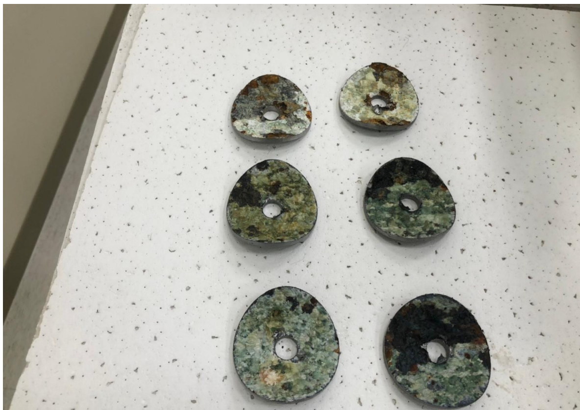
7.開孔完成確認鐵片取出
