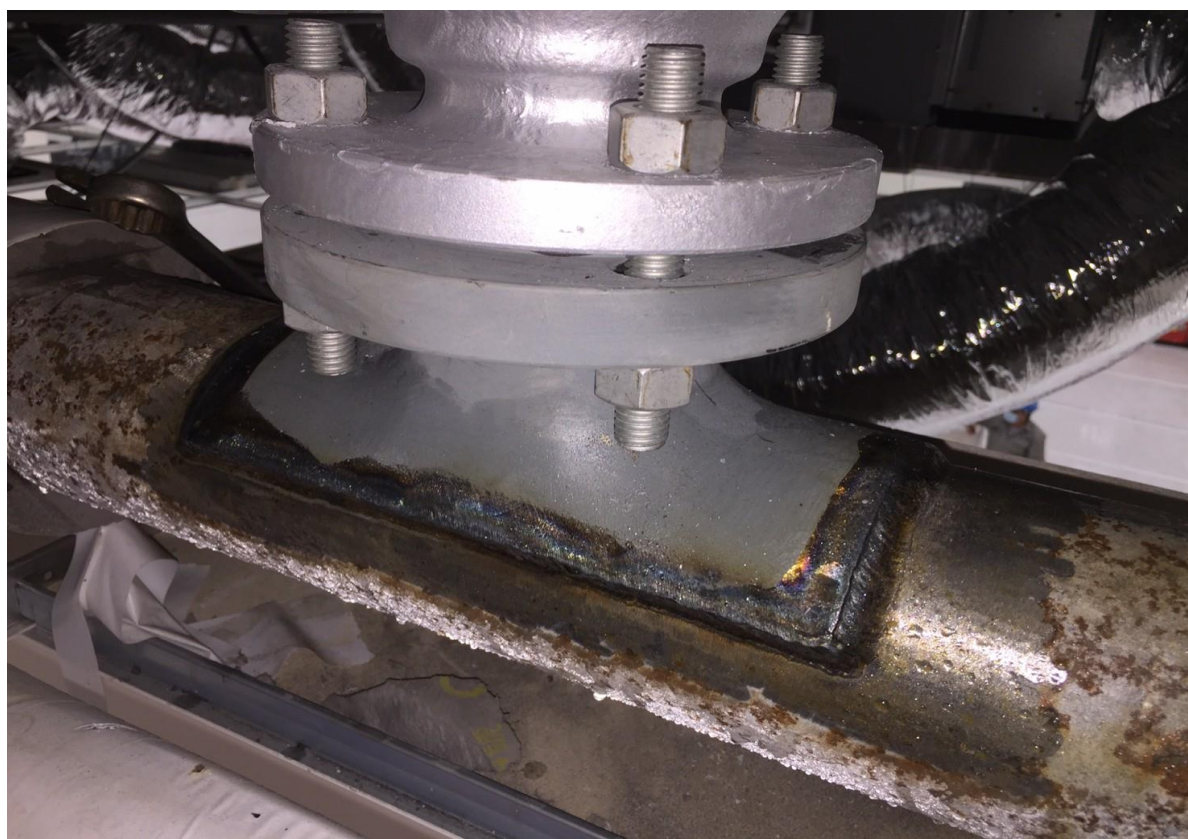
2. 焊道檢查作業
