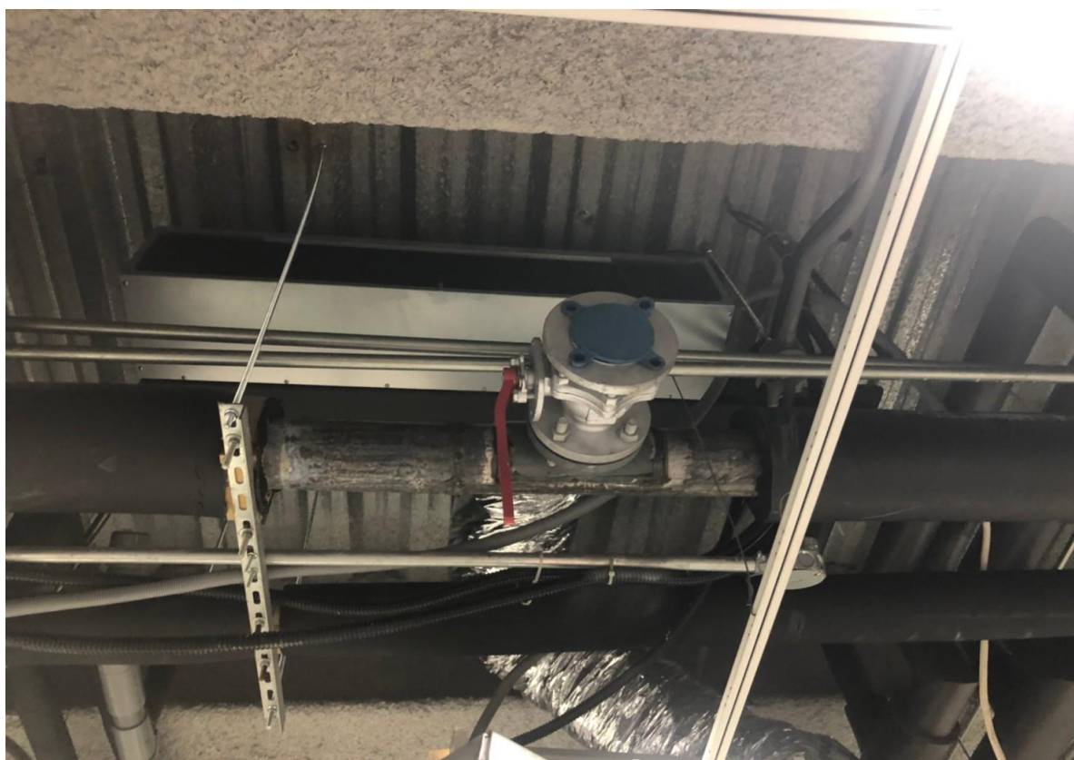
8. 施工完成將球閥關閉，並交由配管廠商配管
