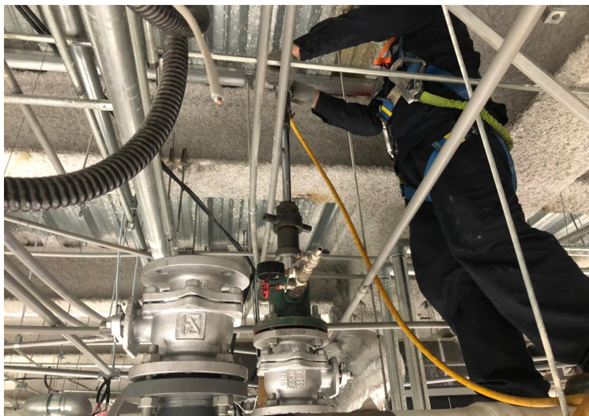
6. 人員進行開孔作業
