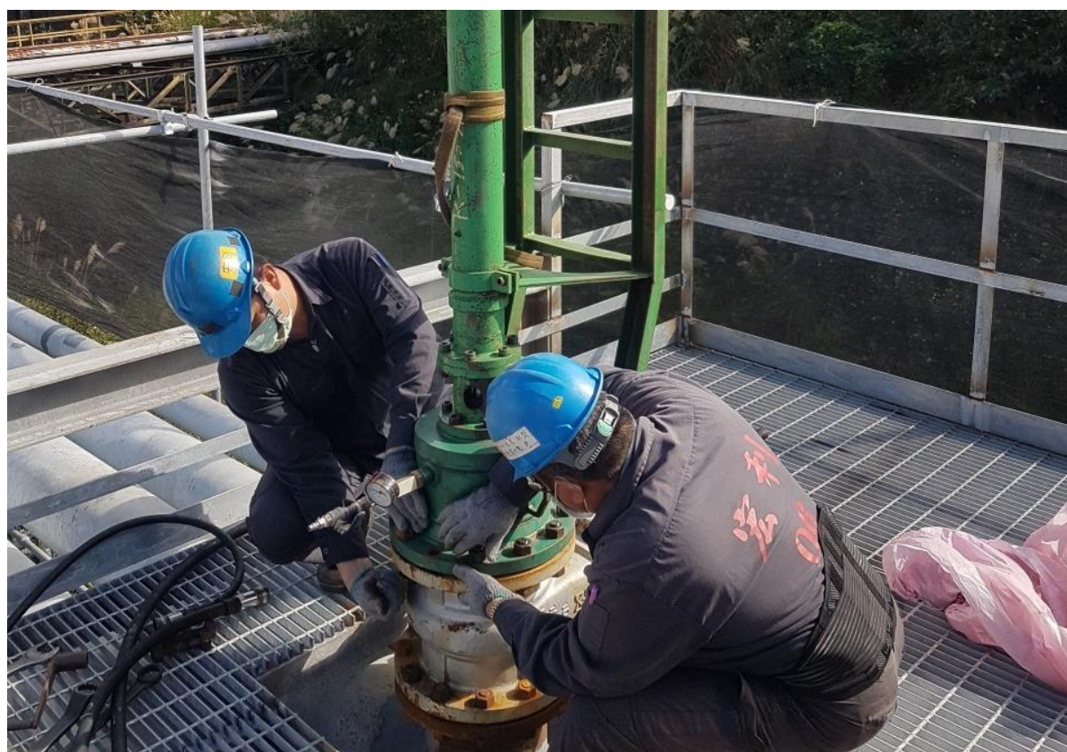
2. 開孔機安裝作業
