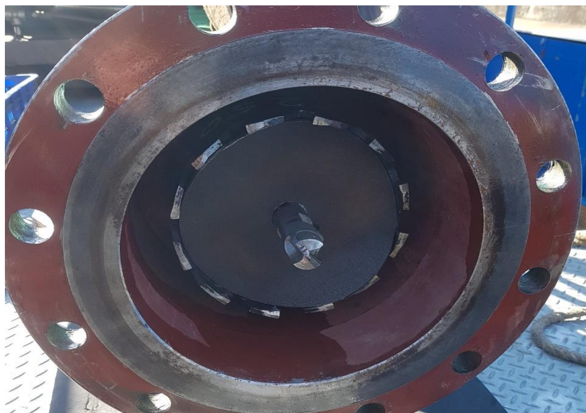
4. 施工完成，確認開孔鐵片取出
