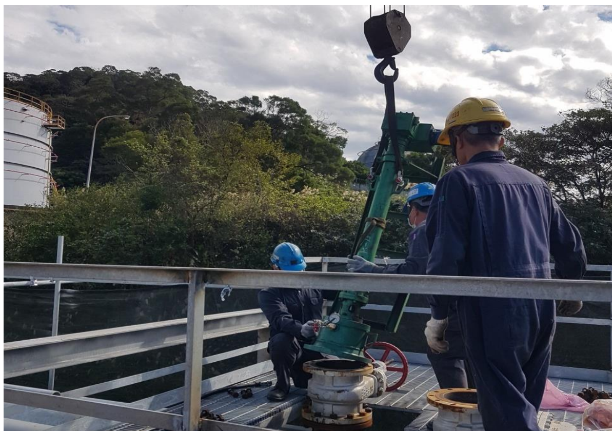
1. 開孔機吊裝並安裝
