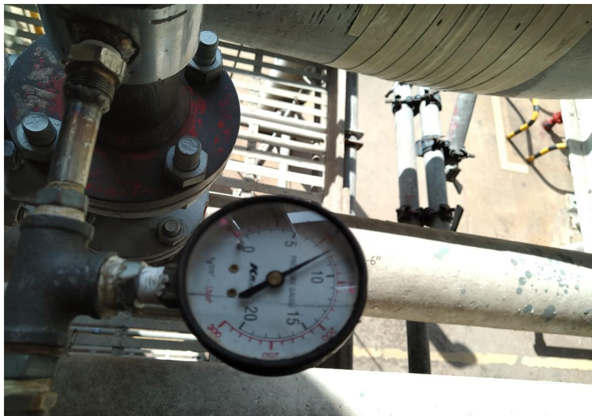
1. 開孔前試壓作業
