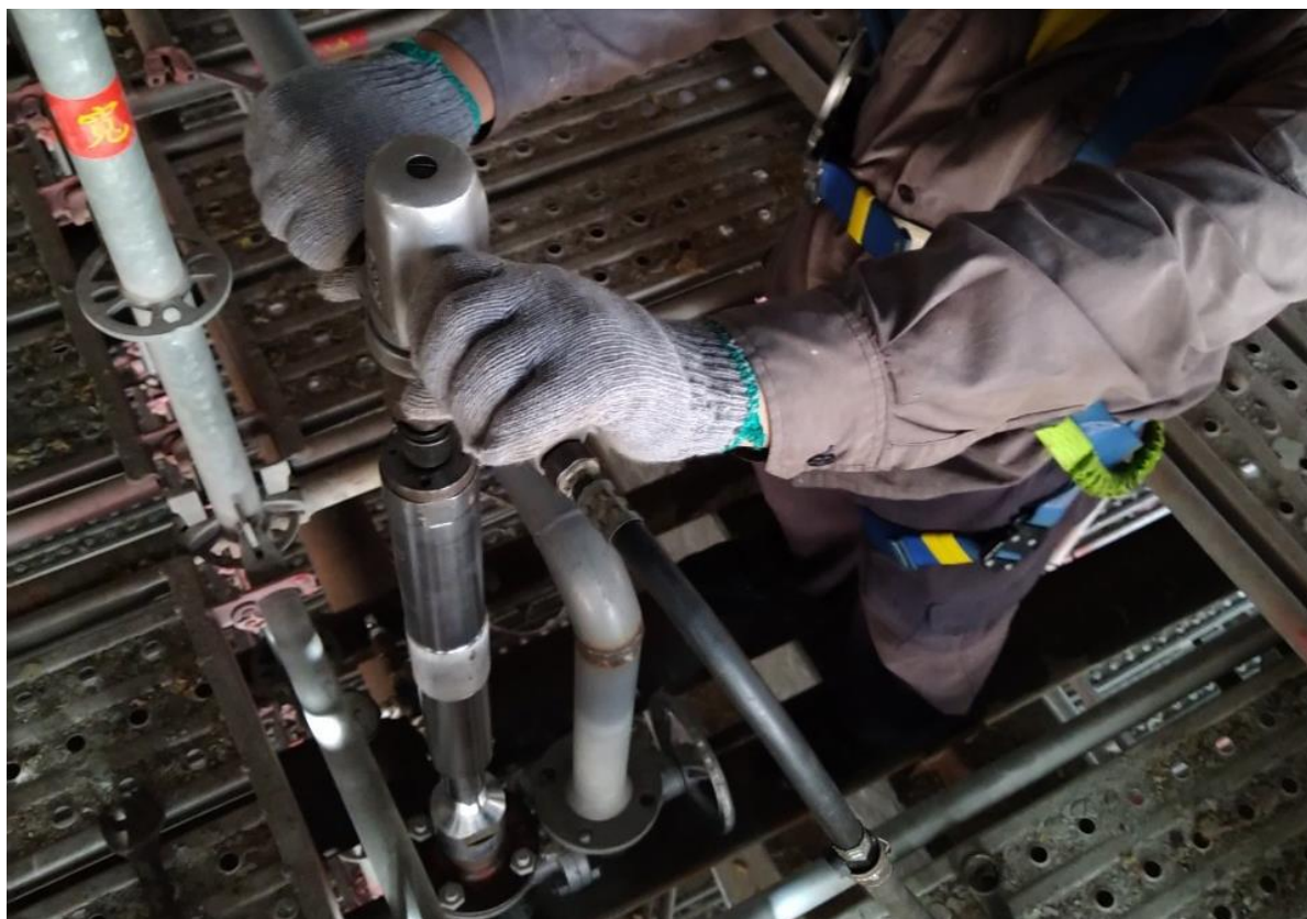
3. 人員操作開孔機情形(2)
