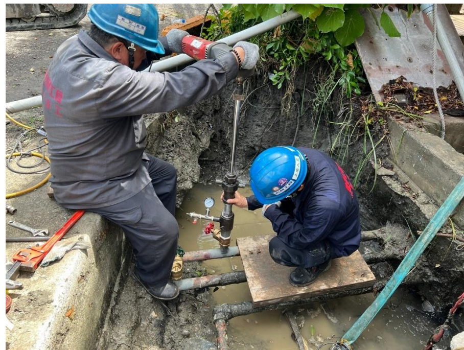
20. 人員執行開孔作業
