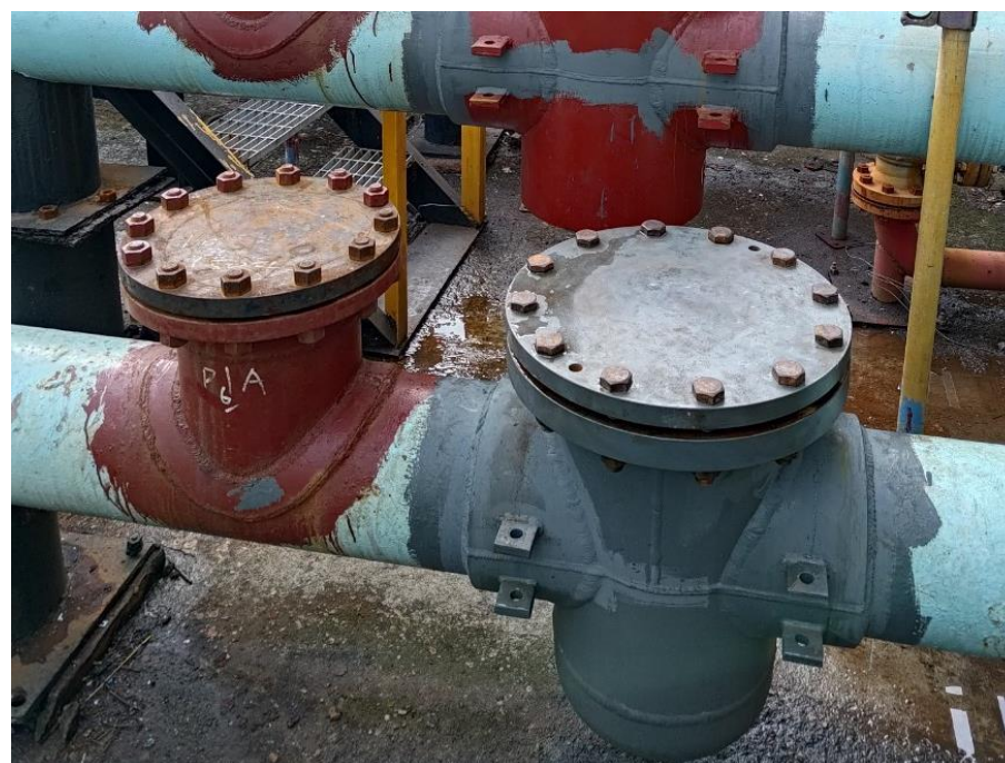
38. 人員執行斷管作業後確認料塊取出
