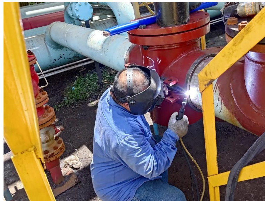
40. 四通模具銲接作業
