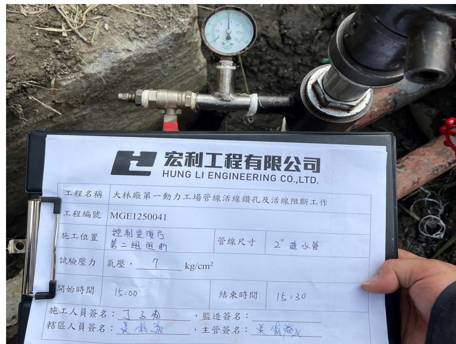
18. 管線開孔前試壓作業
