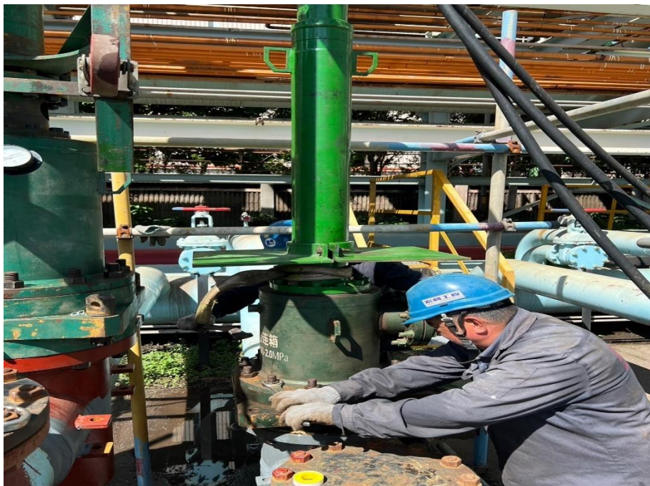
33. 人員安裝阻斷器後進行阻斷作業
