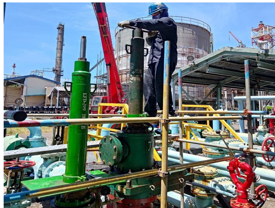
44. 人員安裝阻斷器進行阻斷作業
