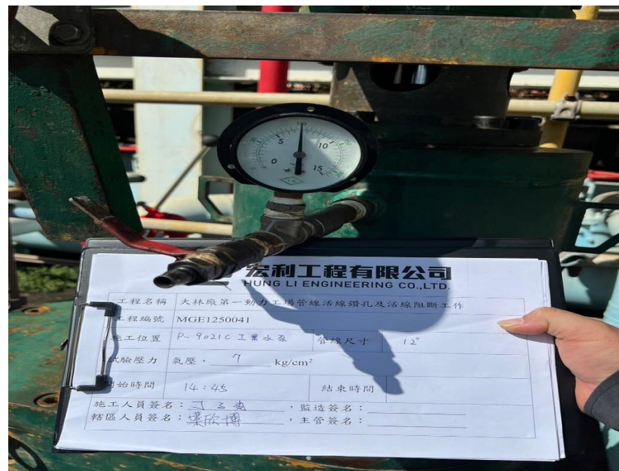
42. 管線開孔前進行試壓作業
