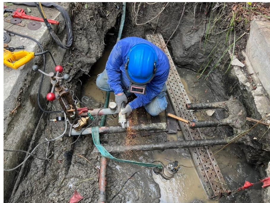
22. 管線切管作業
