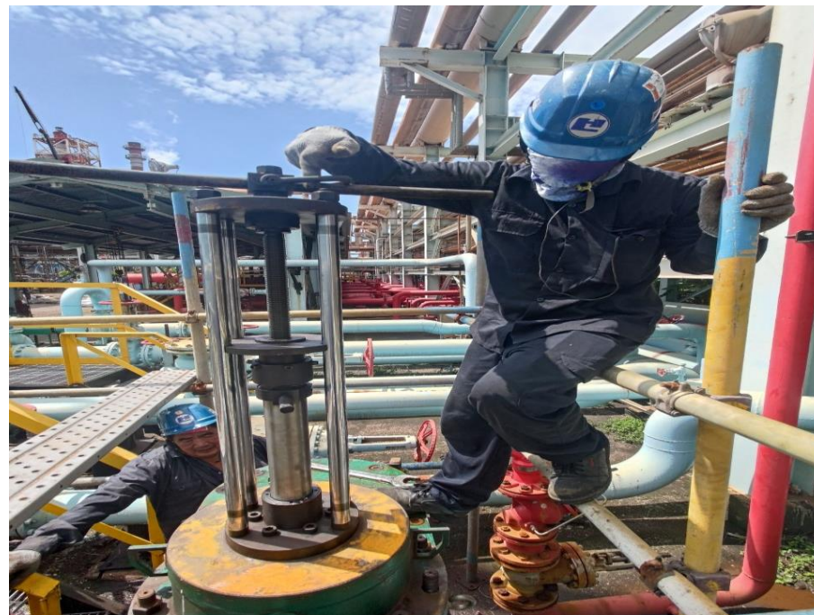
46. 人員安裝下堵器進行下堵作業
