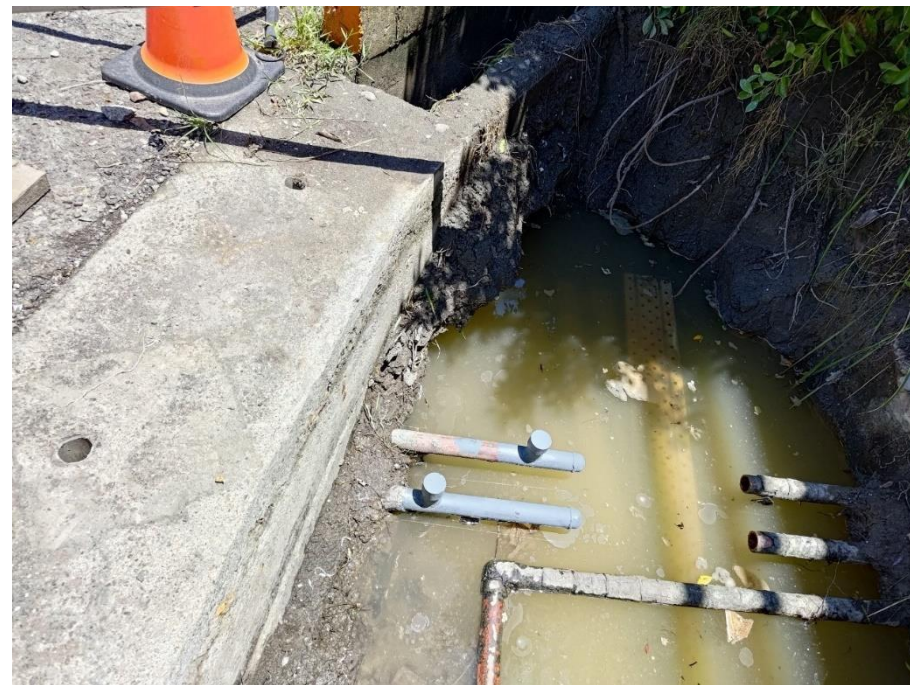
26. 不斷水阻斷封焊施工完成
