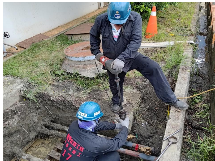
8. 人員進行開孔作業
