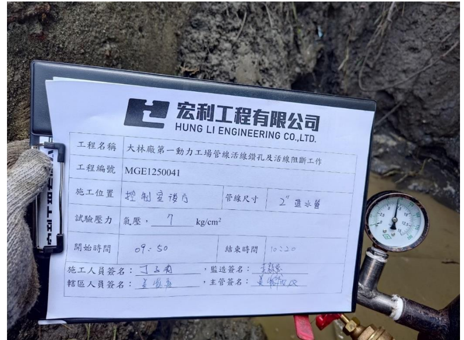
6. 開孔前管線進行試壓作業
