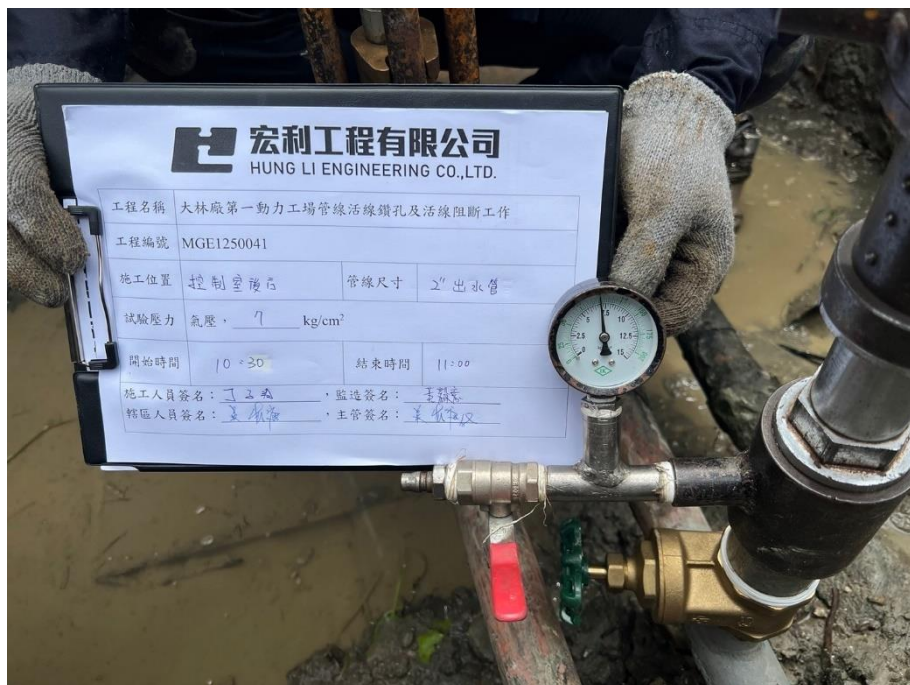
7. 開孔前管線進行試壓作業
