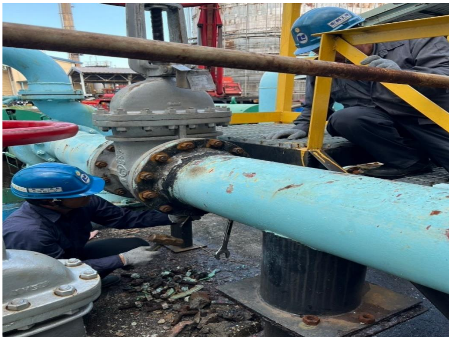
45. 阻斷後進行閥件更換作業
