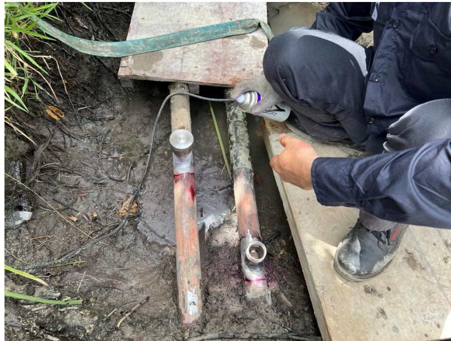
16. 管線 PT 試驗(液滲檢測)
