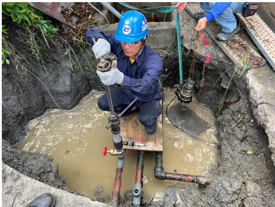
17. 人員安裝開孔機具
