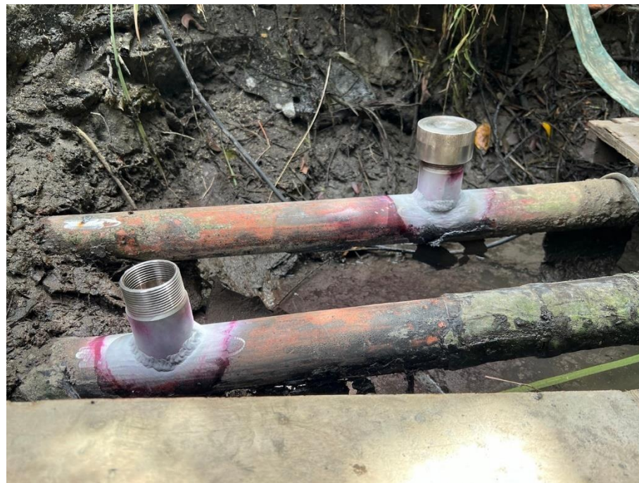
4. 管線 PT 試驗-1(液滲檢測)
