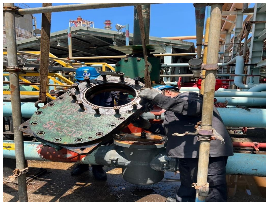
36. 下堵完成移除夾板閥
