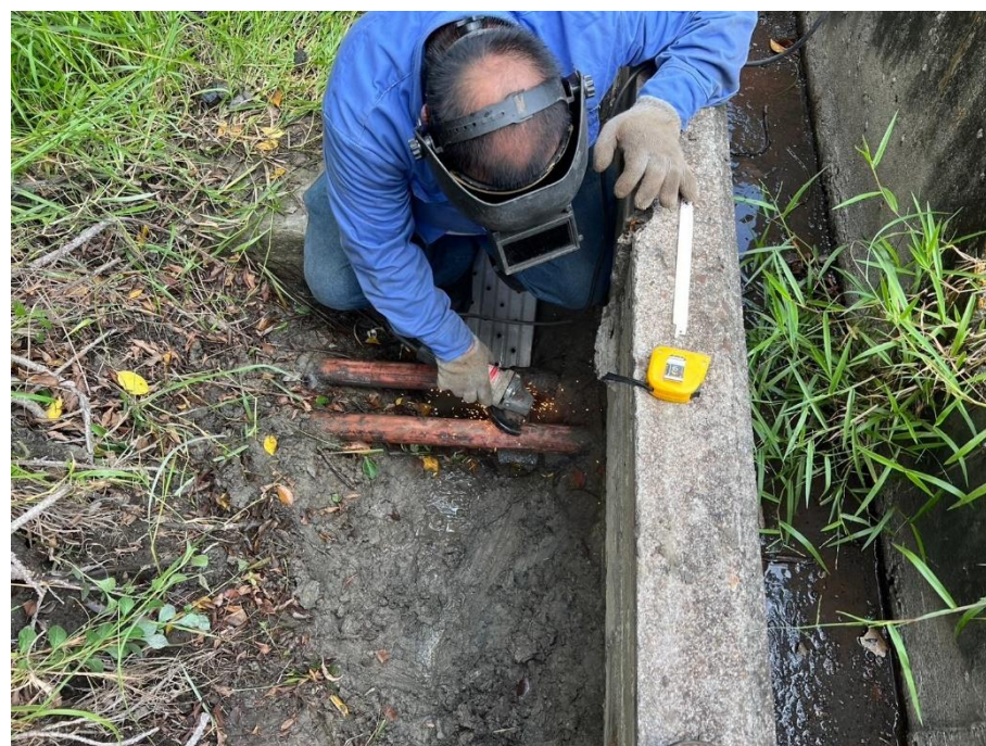
2. 管線研磨作業
