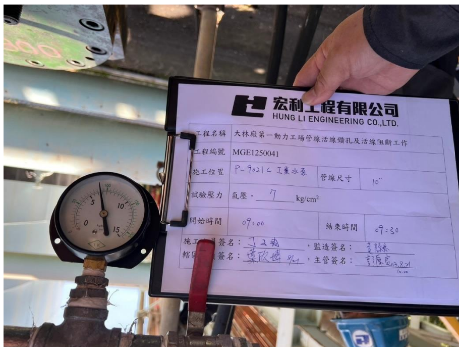
31. 管線開孔前試壓作業
