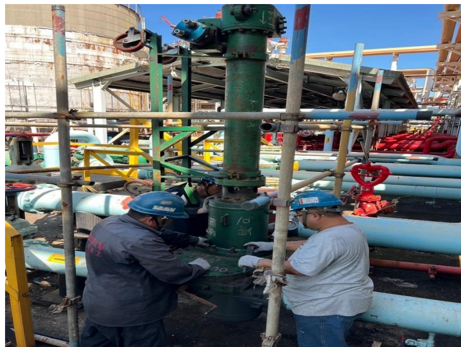
30. 人員安裝夾板閥及開孔機具
