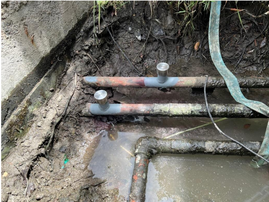
5. 管線 PT 試驗後油漆作業
