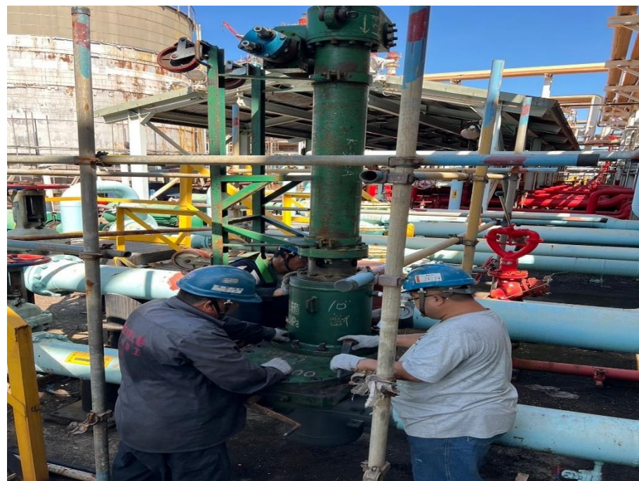
30. 人員安裝夾板閥及開孔機具
