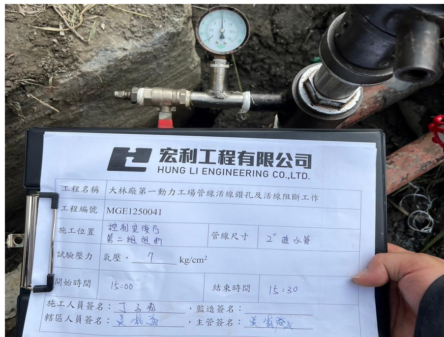
18. 管線開孔前試壓作業
