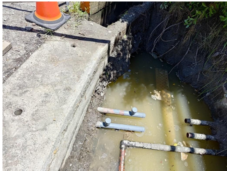
26. 不斷水阻斷封焊施工完成
