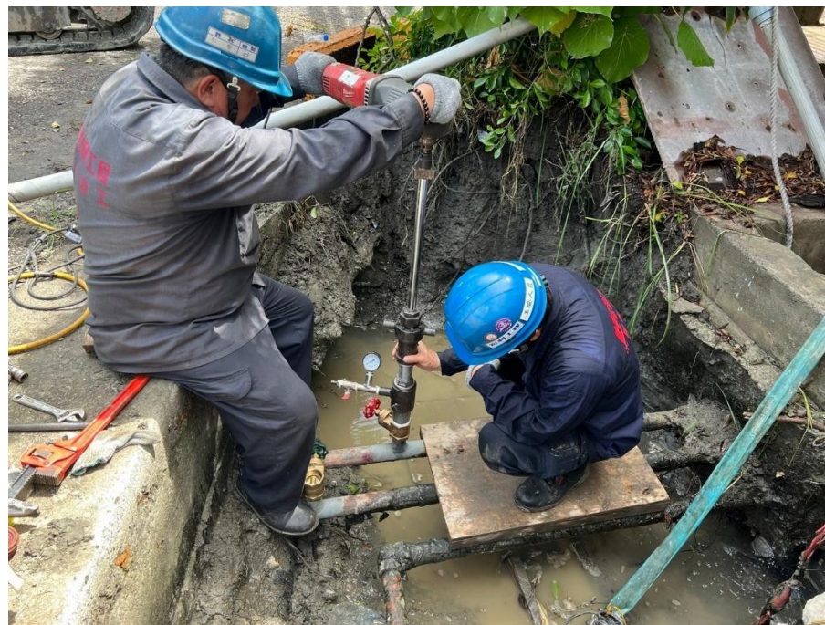
20. 人員執行開孔作業
