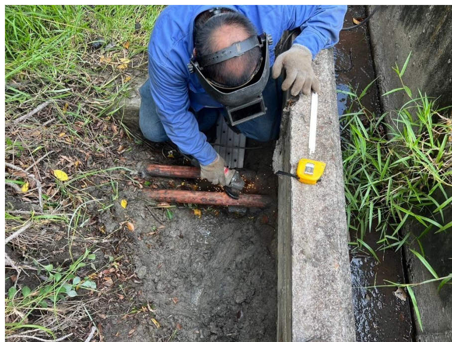
2. 管線研磨作業
