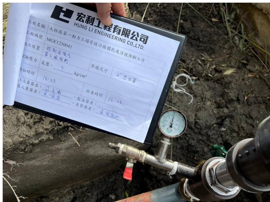
19. 管線開孔前試壓作業
