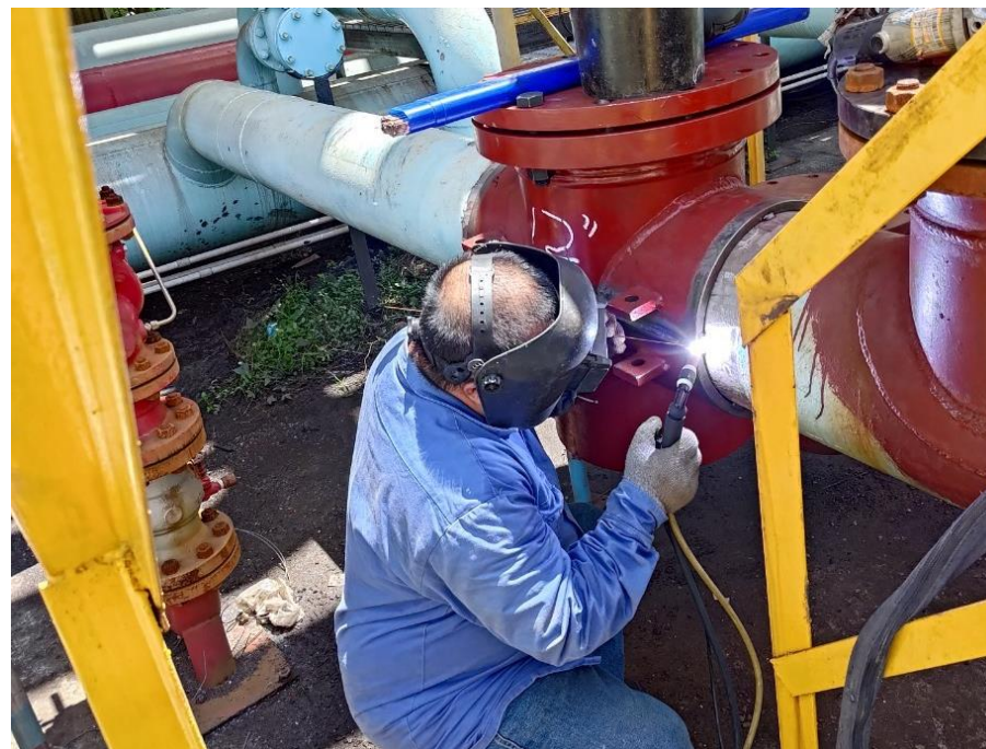
40. 四通模具銲接作業
