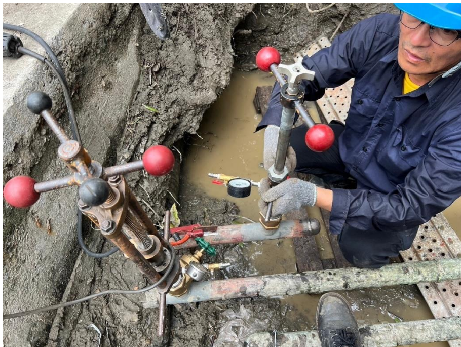
25. 管線進行下堵作業
