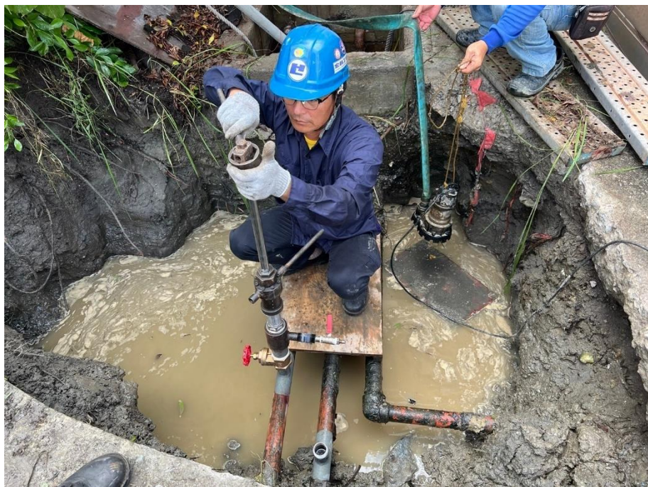
17. 人員安裝開孔機具
