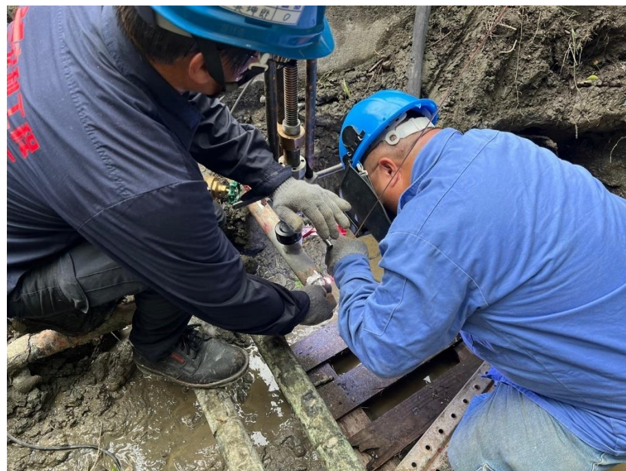
24. 管線封焊作業
