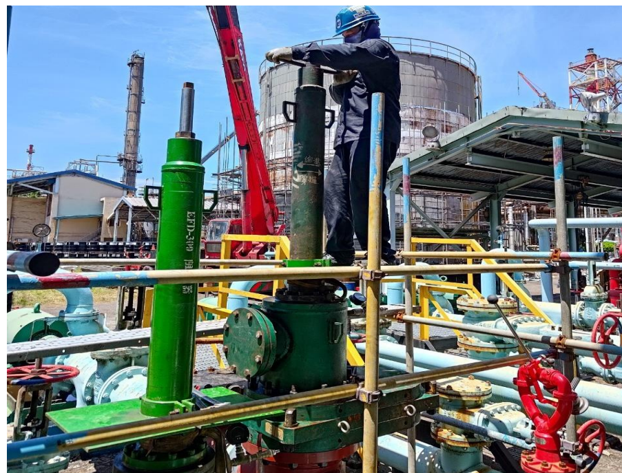
44. 人員安裝阻斷器進行阻斷作業
