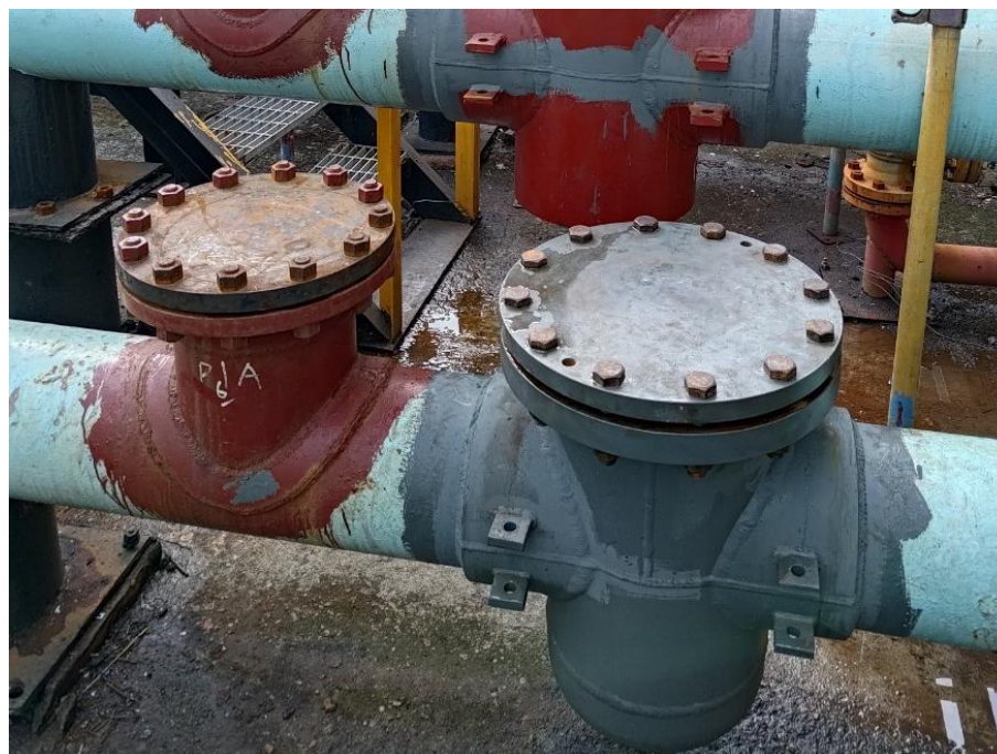
38. 人員執行斷管作業後確認料塊取出
