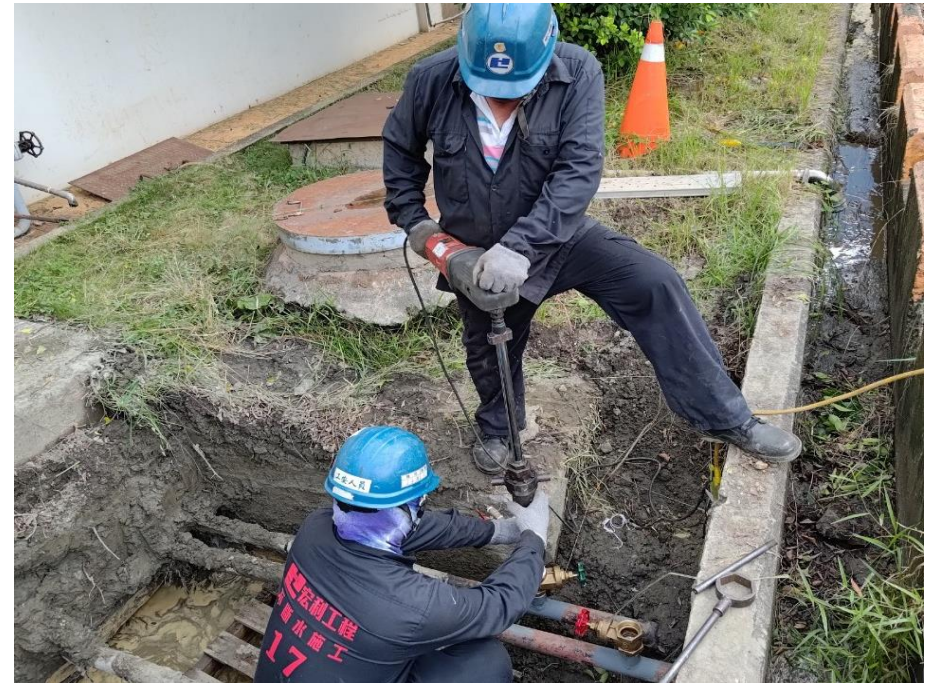
8. 人員進行開孔作業
