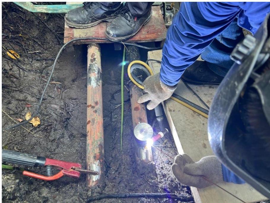
15. 模具焊接作業
