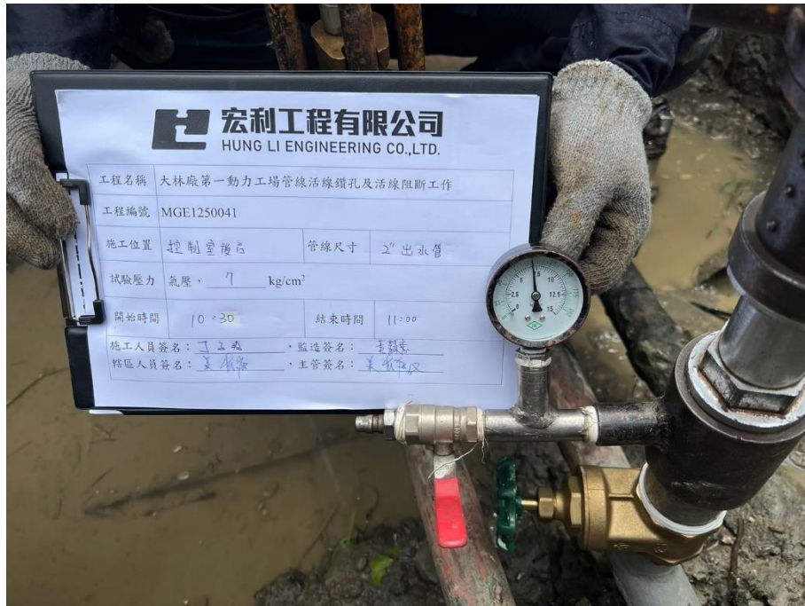
7. 開孔前管線進行試壓作業
