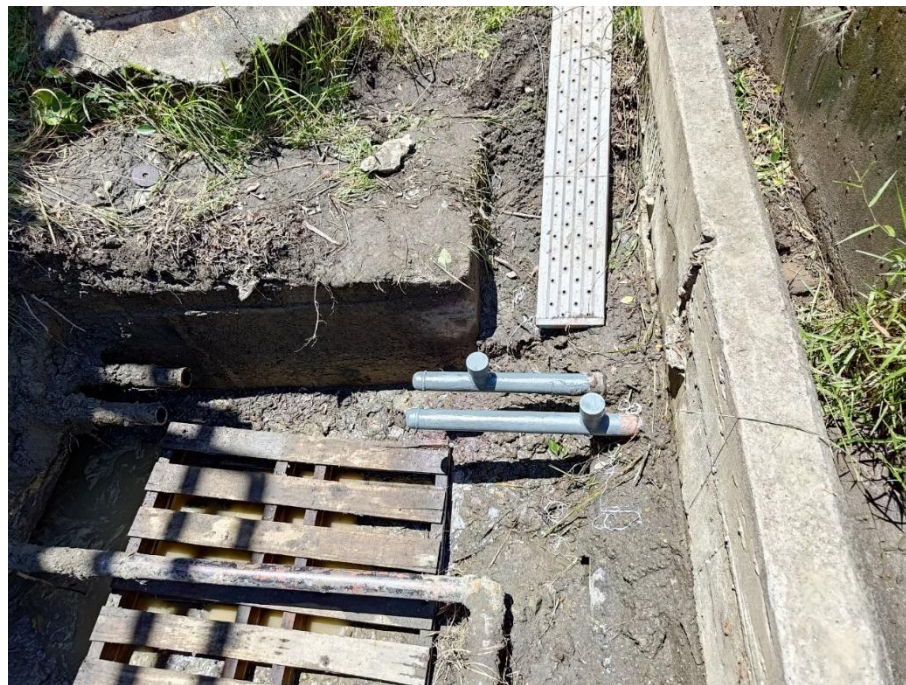
14. 不斷水阻斷封焊施工完成
