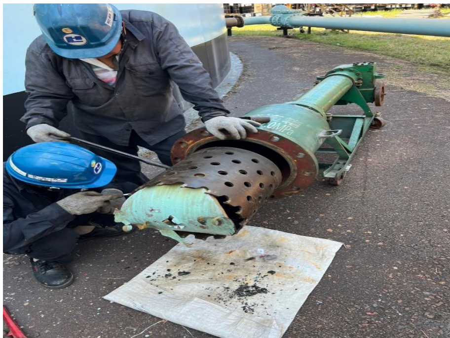
43. 斷管完成確認料塊取出
