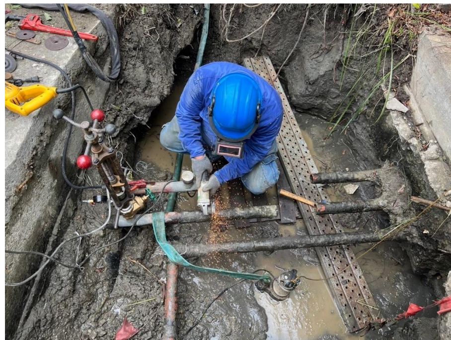
22. 管線切管作業
