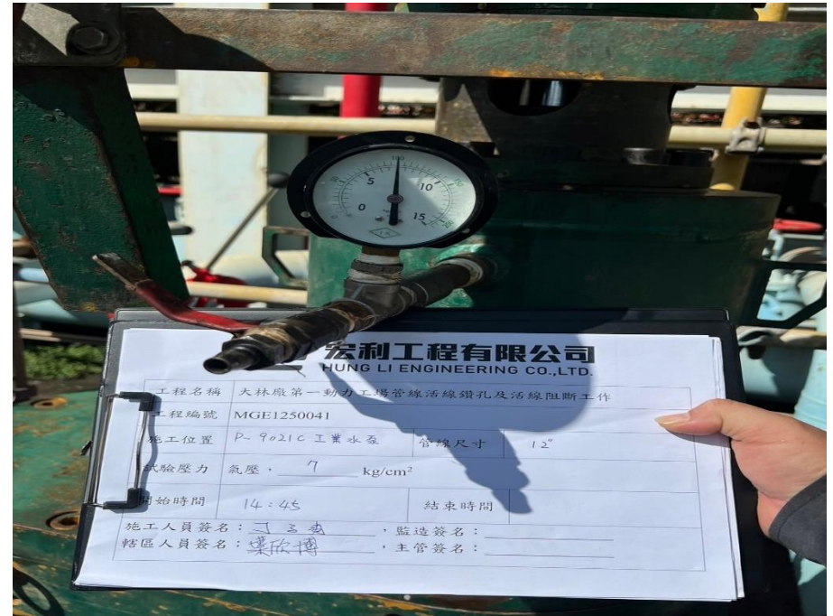
42. 管線開孔前進行試壓作業
