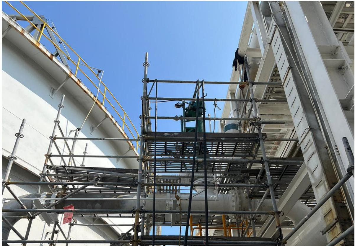
7. 試壓後進行開孔作業
