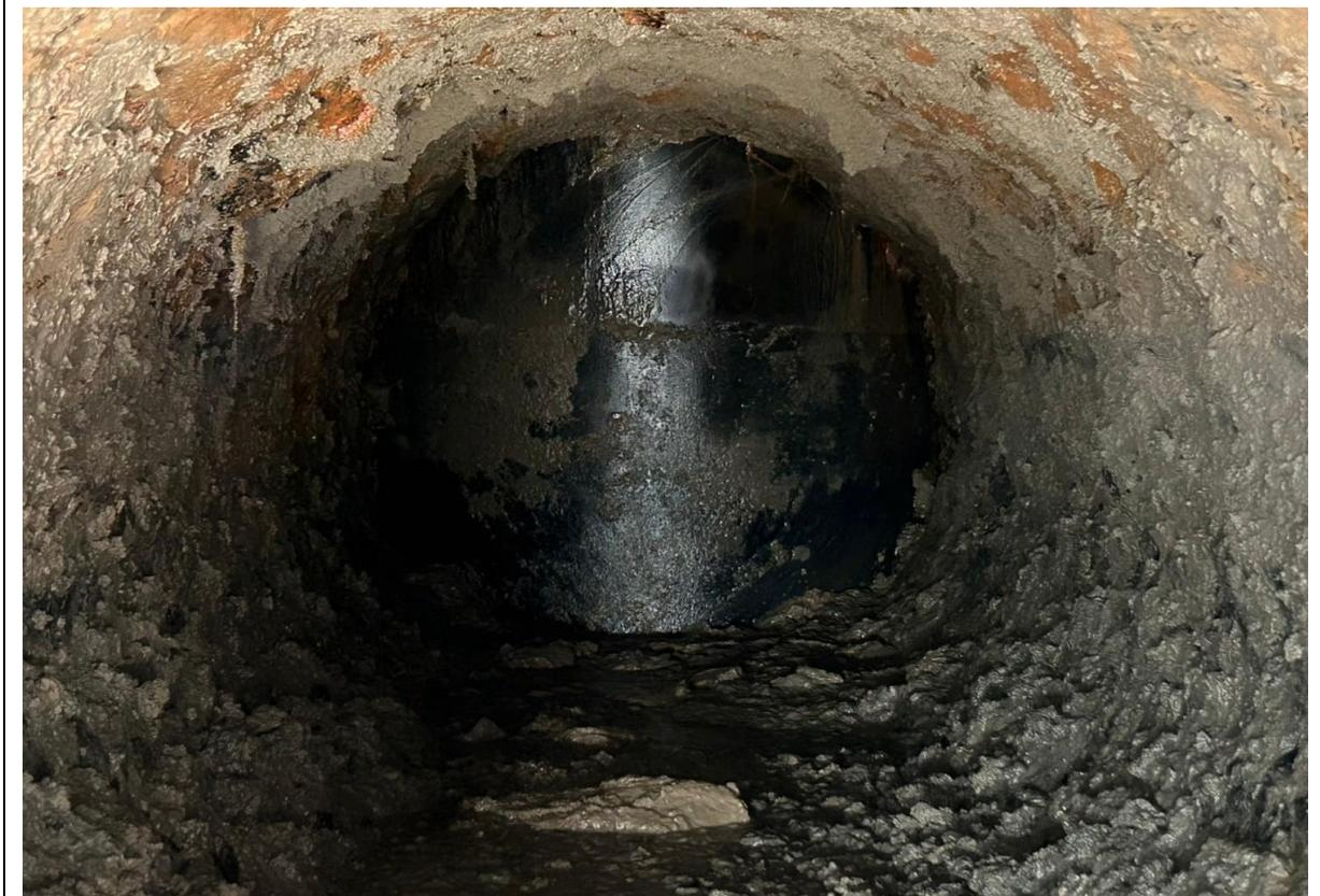
24. 管線阻斷後切管內部情形(阻斷率 99%)
