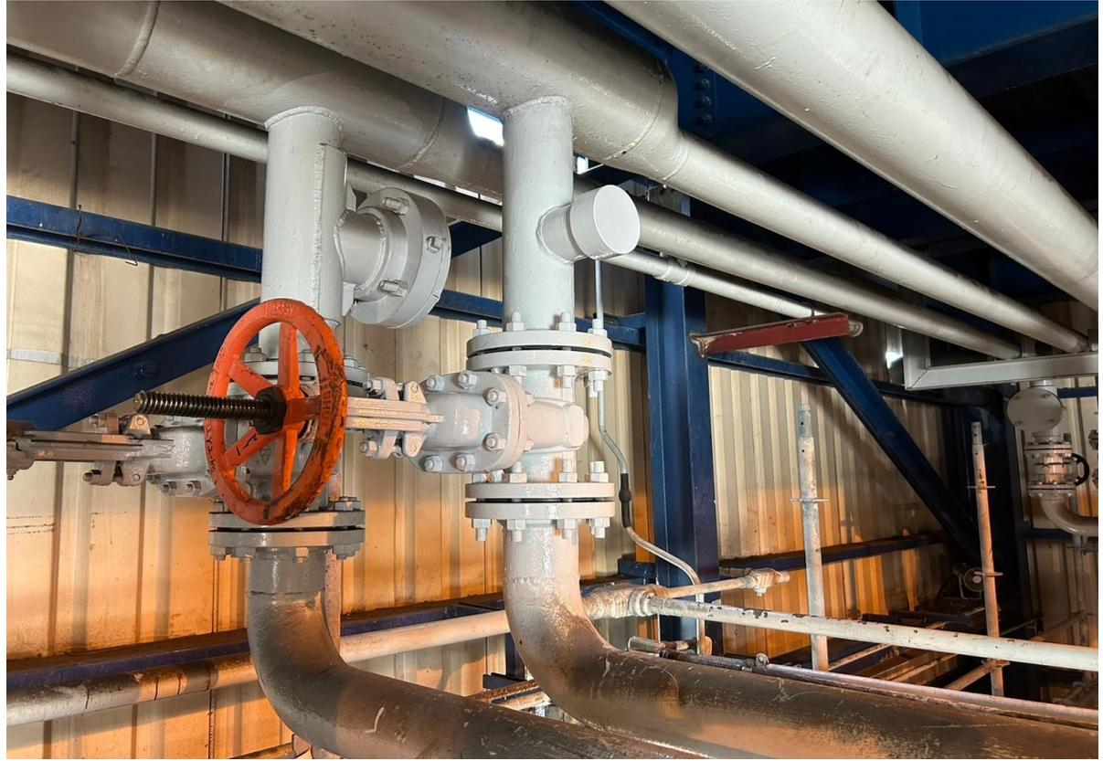
11. 不斷水施工及管線增設閥件作業完成
