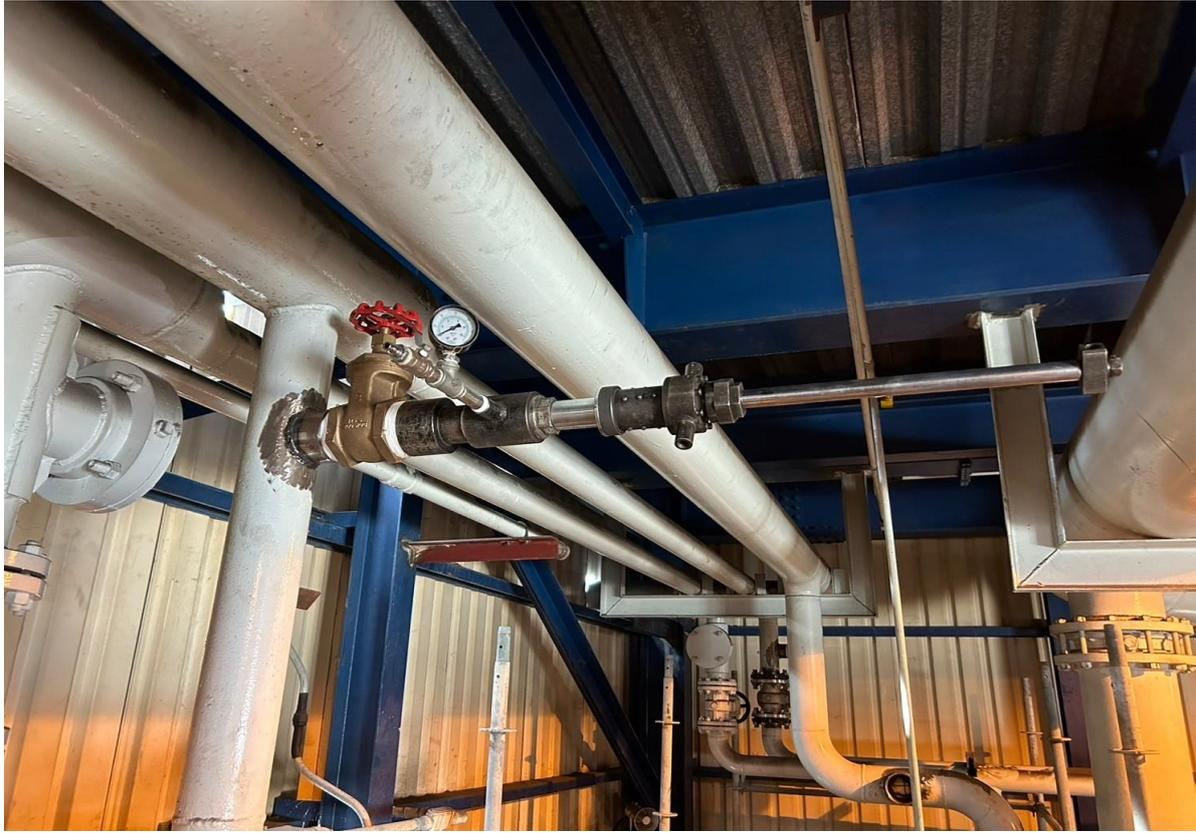
9. 安裝閥件及開孔機具後進行開孔作業
