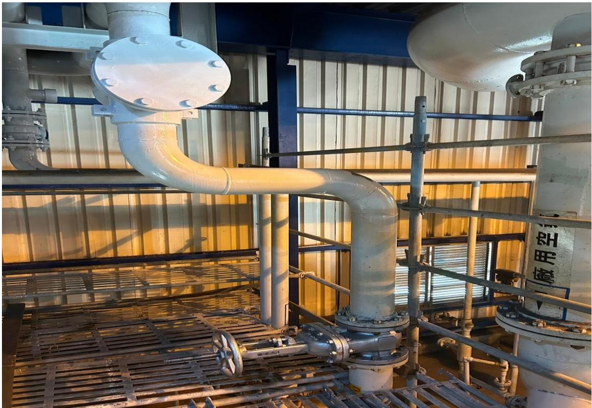
28. 管線阻斷作業後更換閥件完成
