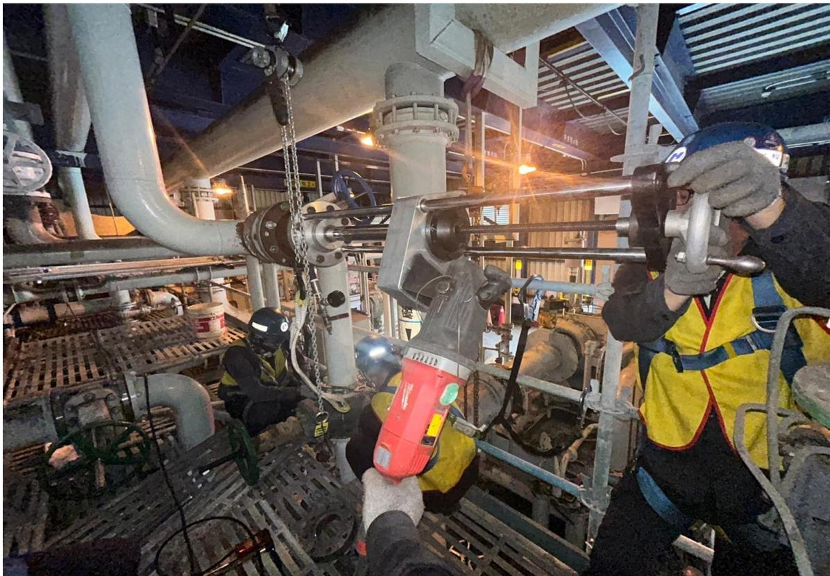
20. 安裝閥件及開孔機具後進行開孔作業
