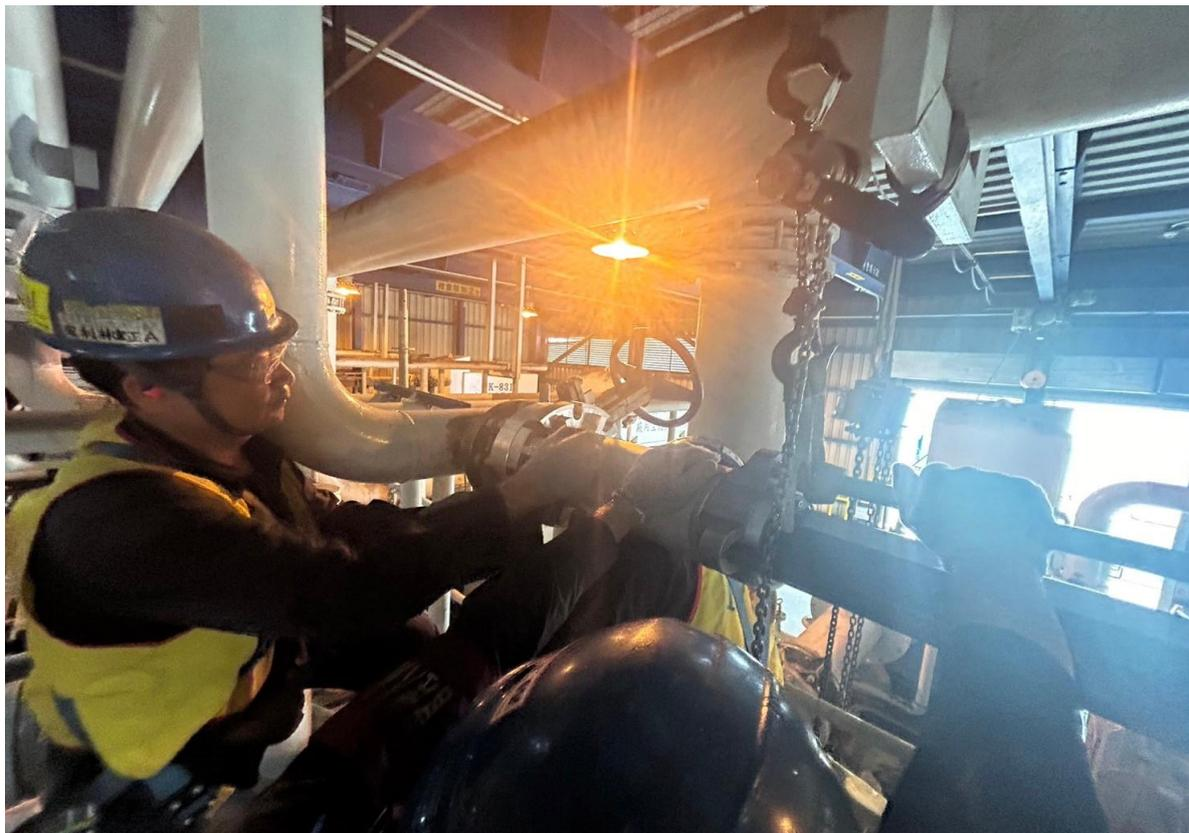
21. 安裝阻斷機具後進行阻斷作業
