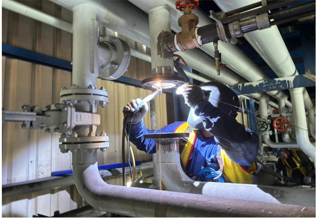
13. 安裝阻斷器後進行切管焊接作業
