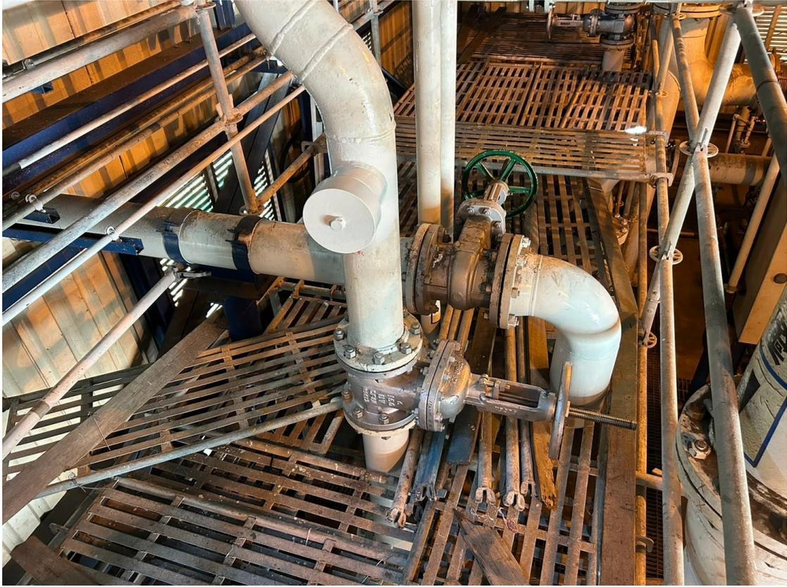
19. 管線阻斷後更換閥件完成
