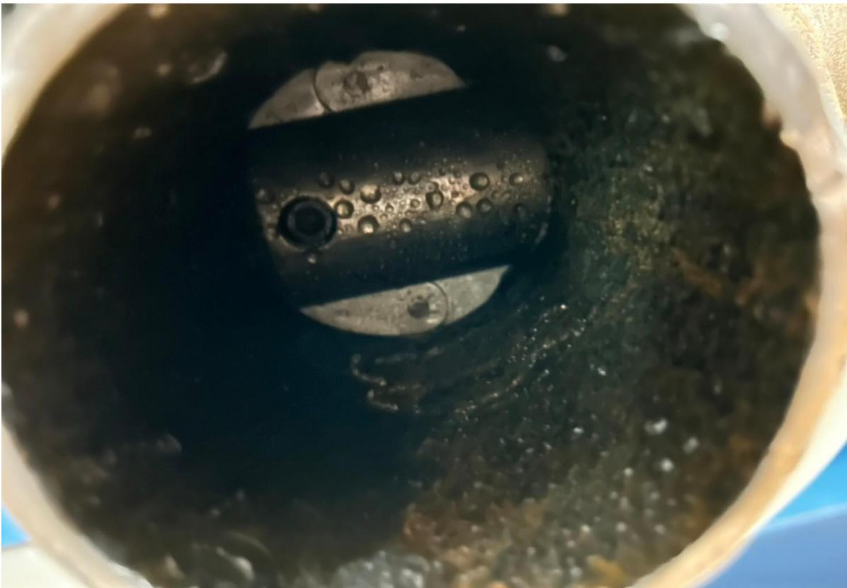
6. 阻斷後確認管內阻斷情形(阻斷率 99%)
