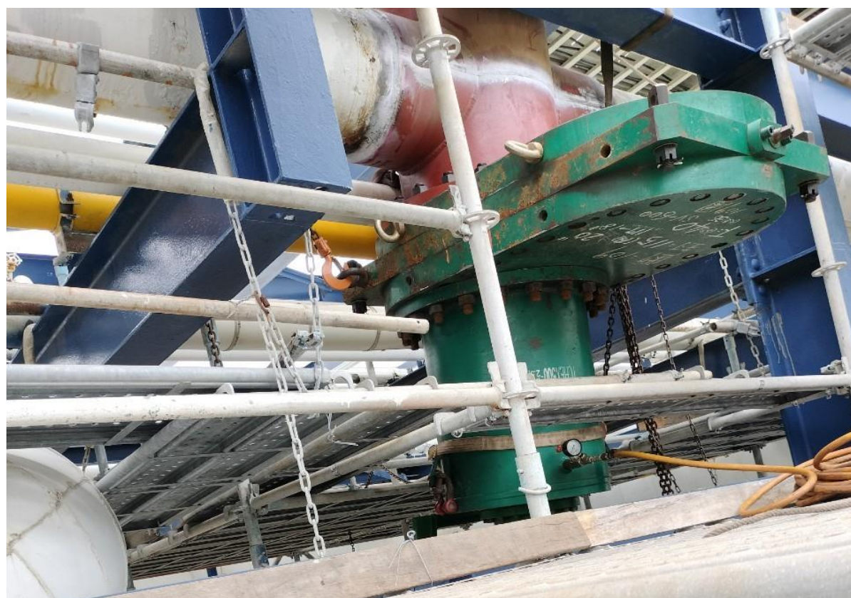
4.開孔前試壓作業
