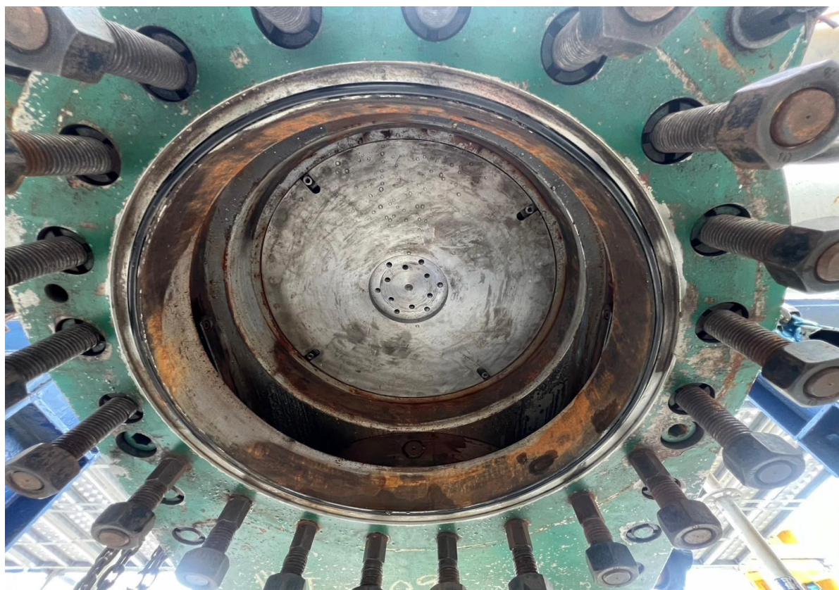
10. 下堵作業完成
