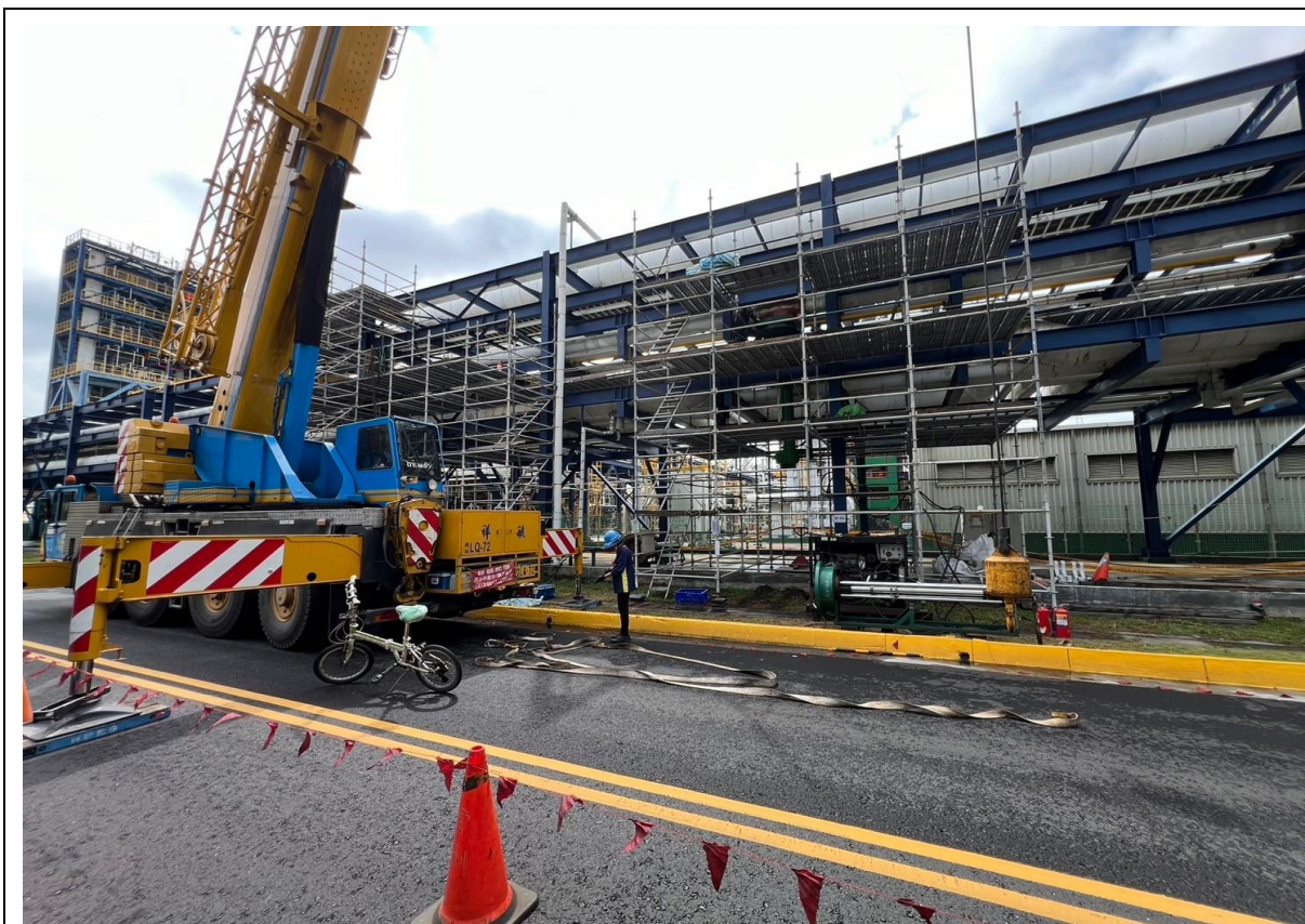
1. 現場機具定位情形
