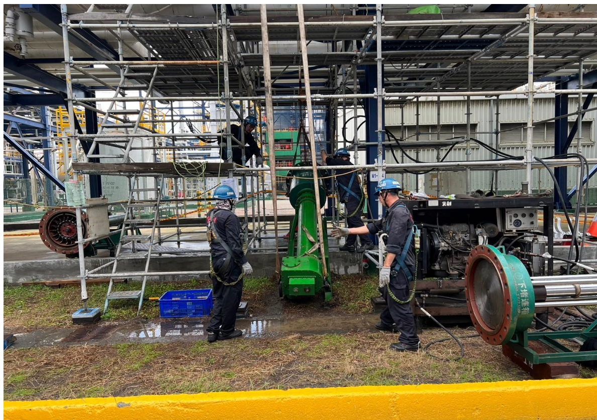
5. 斷管完成移除開孔機具
