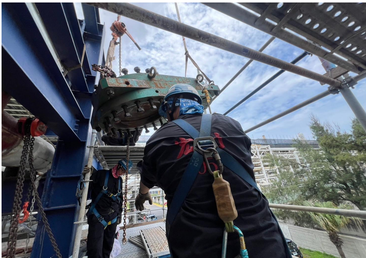
11. 夾板閥移除作業
