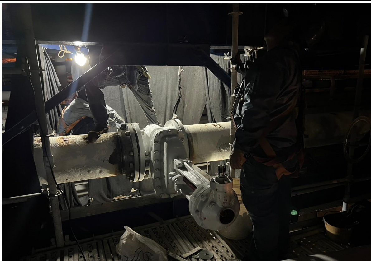
8. 阻斷後增設閥件完成
