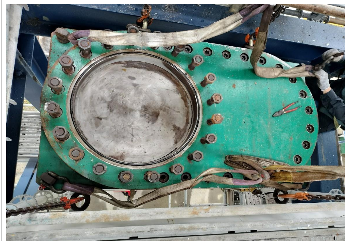
2. 夾板閥吊裝情形
