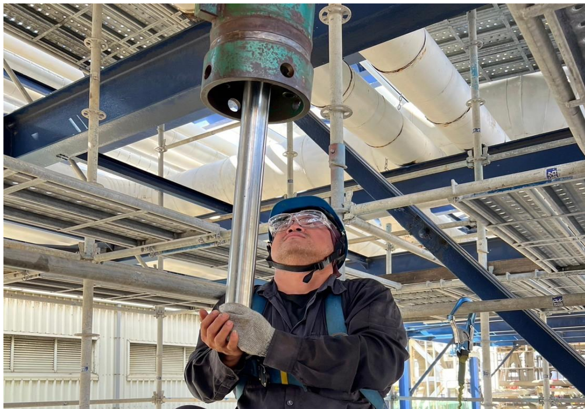
7. 人員安裝開孔機後進行試壓作業
