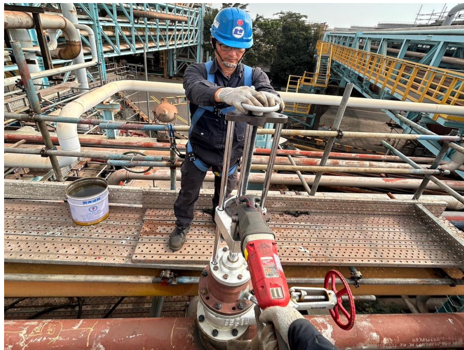
4. 人員執行開孔作業
