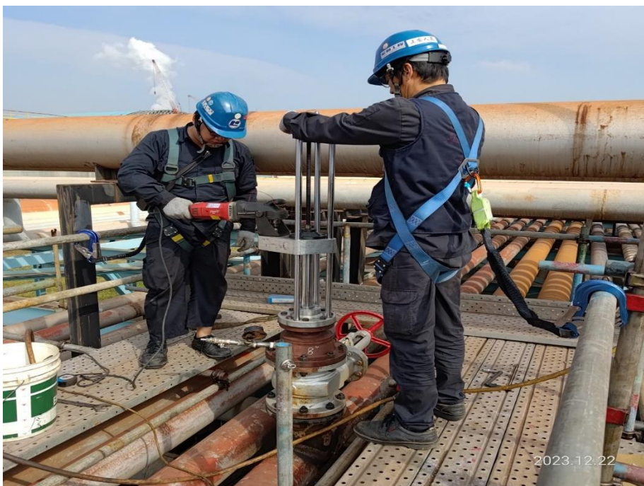
7. 人員執行開孔作業
