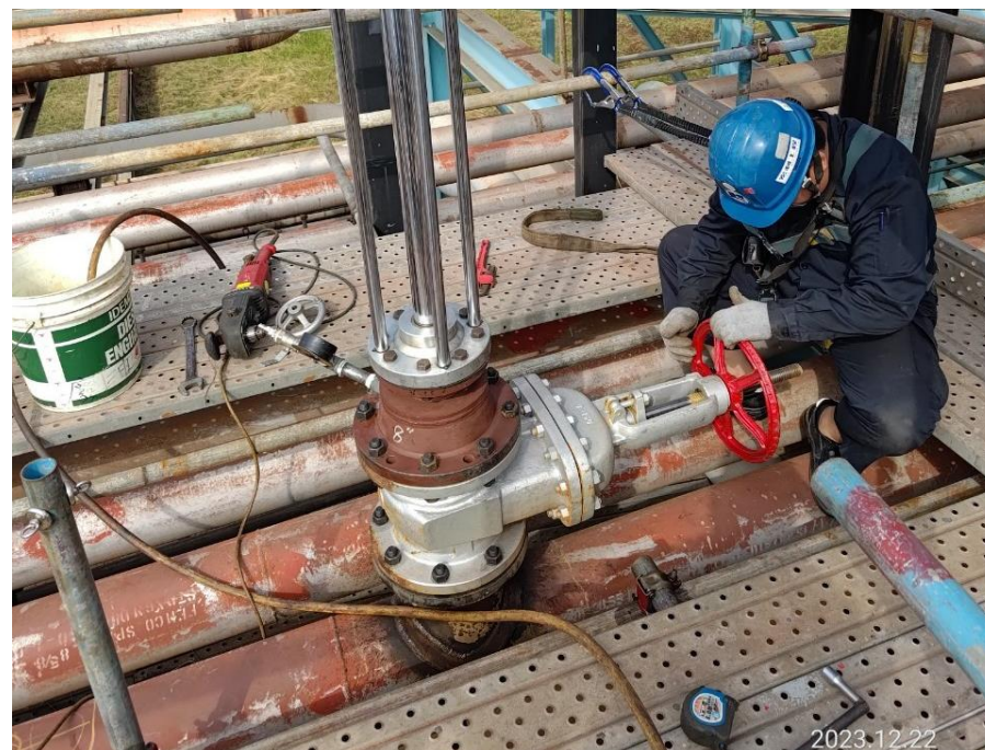
6. 第二口機具閥件安裝情形
