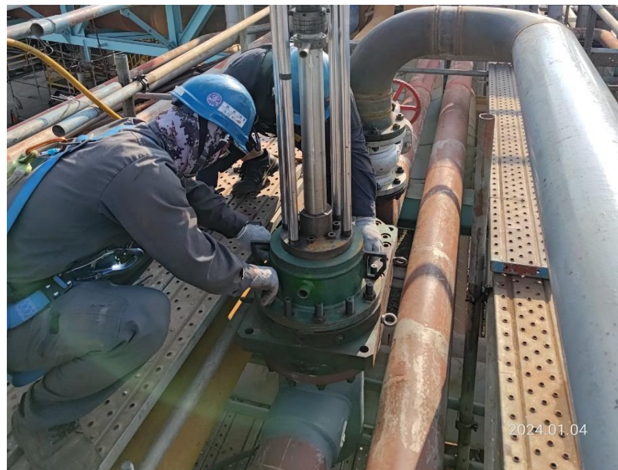
18. 移除阻斷器後進行下堵作業
