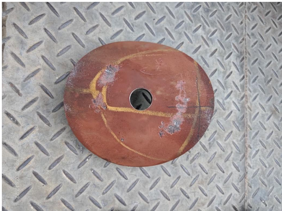
5. 開孔完成確認鐵片取出
