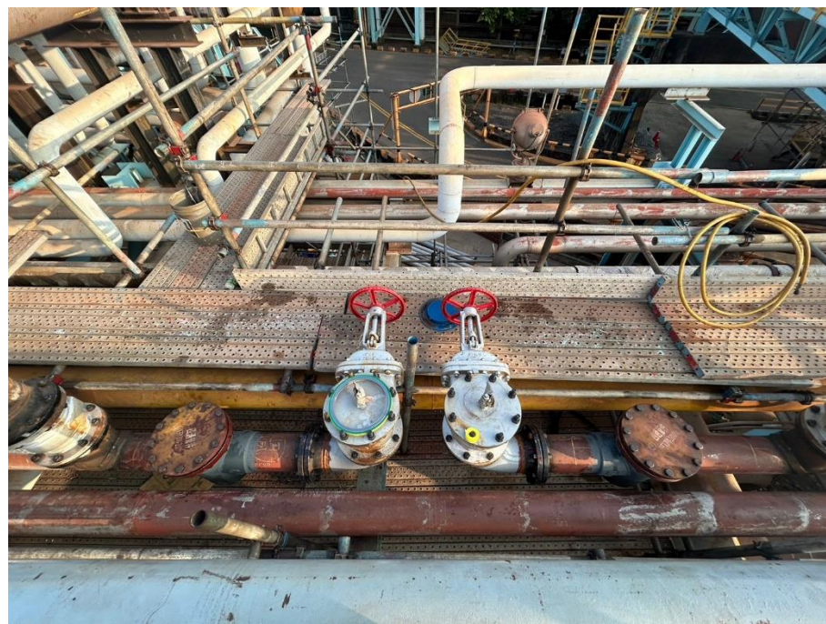
20. 管線活線雙阻斷+旁通後增設閥件施工完成
