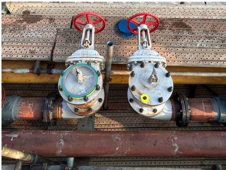
17. 管線增設閥件完成
