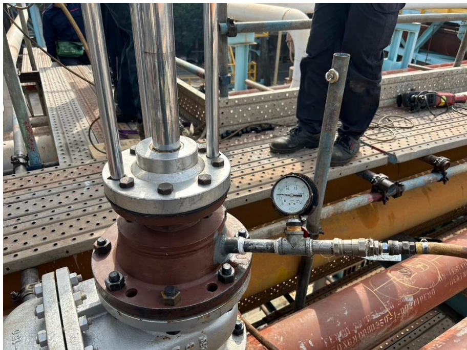
3. 管線試壓作業
