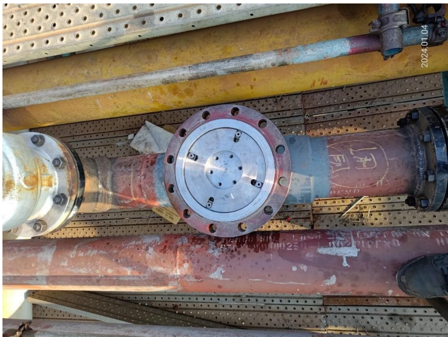
19. 下堵作業完成
