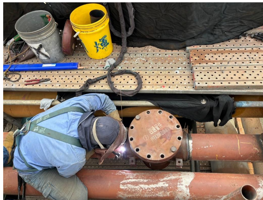
10. 模具焊接作業
