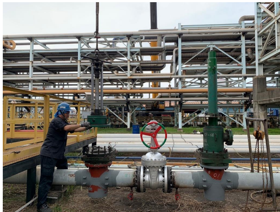
14. 管線增設閥件完成
