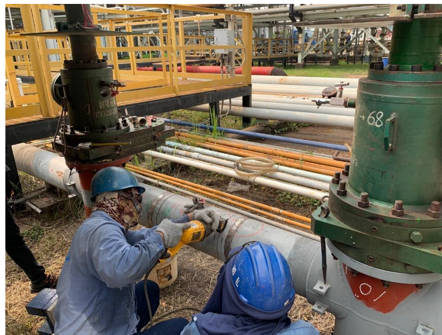
12. 管線切管作業
