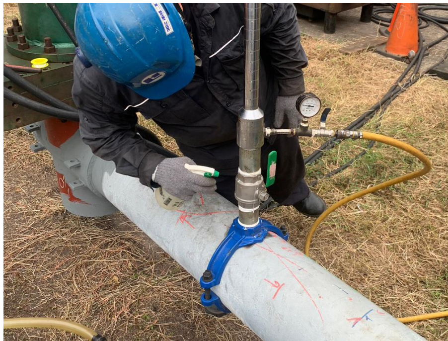
8. 試壓抓漏作業
