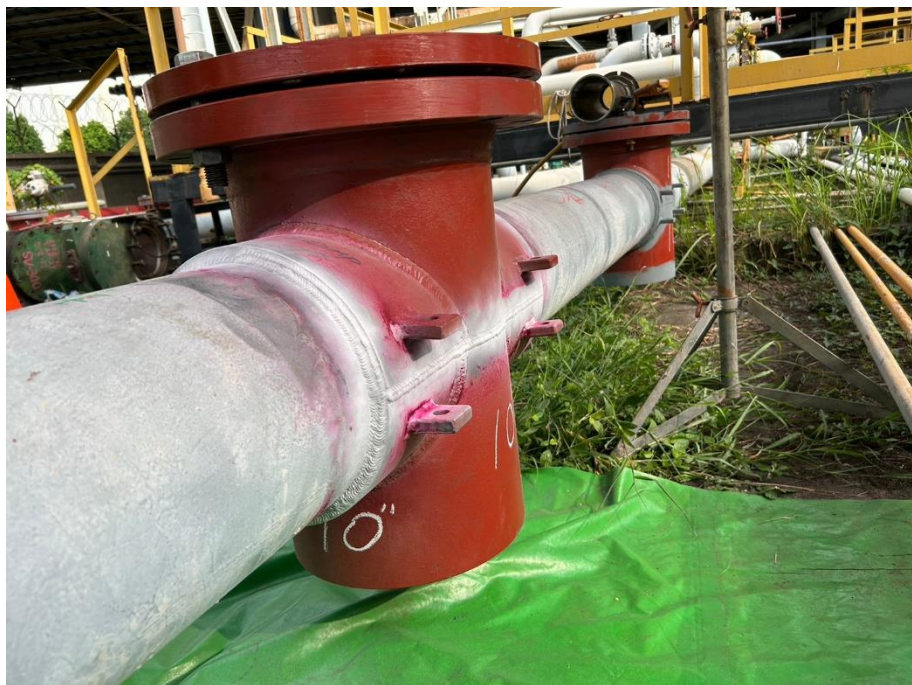
3. 焊道 PT 檢查作業
