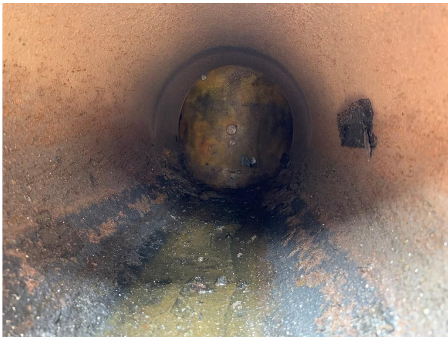
13. 切管後管內阻斷情形，阻斷率 99%
