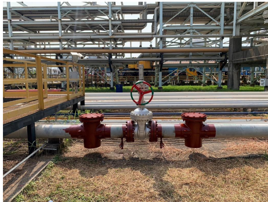
16. 施工完成油漆作業
