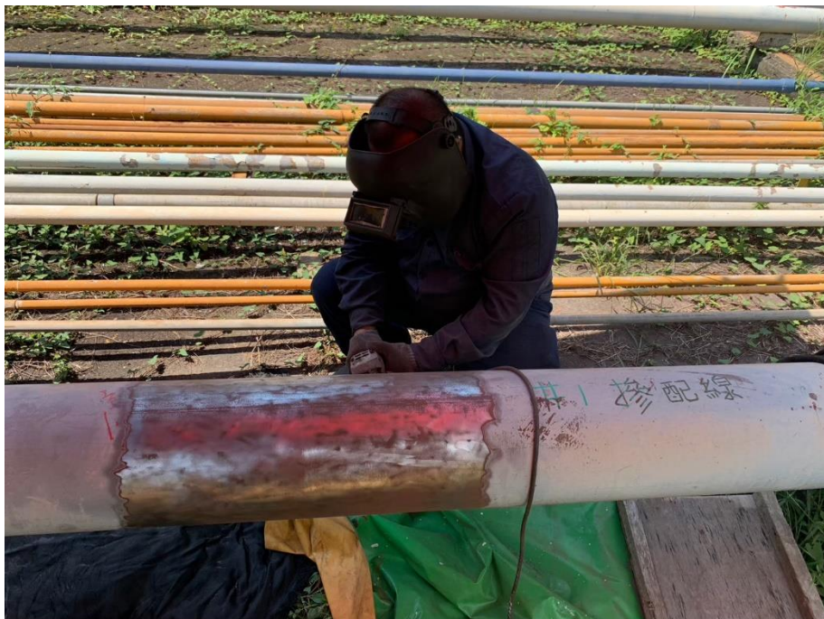
1. 管線研磨作業
