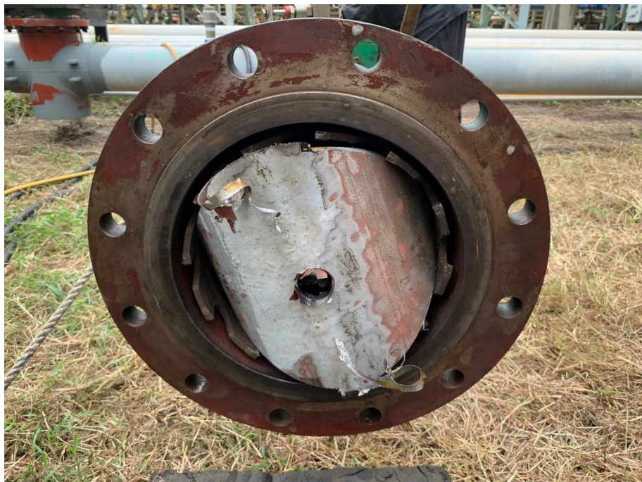
7. 斷管完成確認料塊取出
