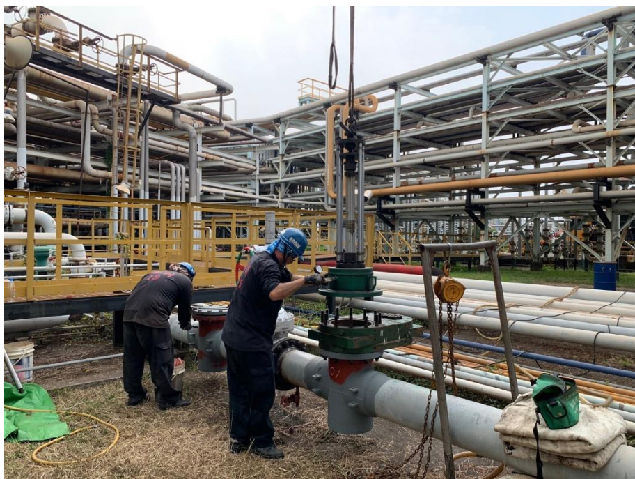
15. 管線進行下堵作業
