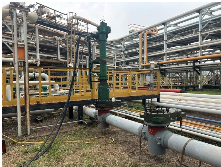
6. 人員執行斷管作業
