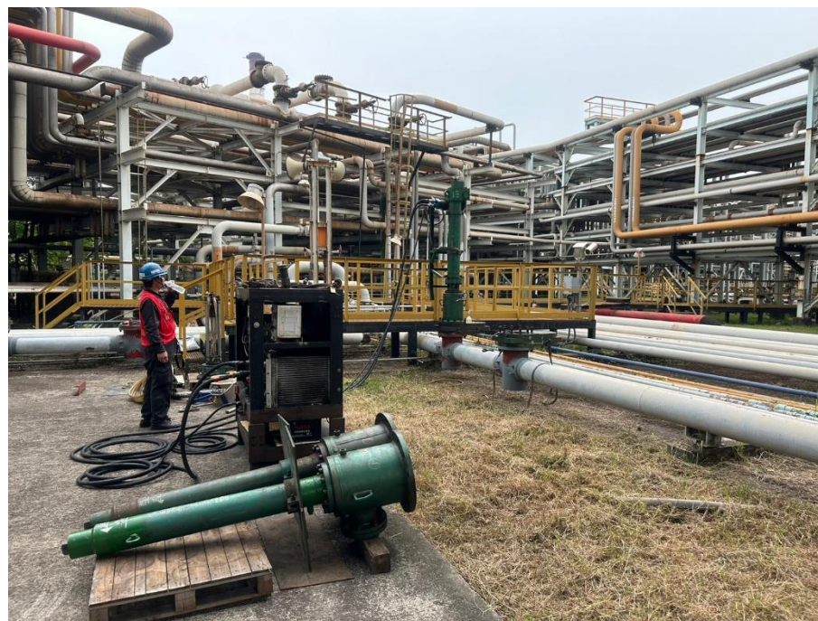
4. 閥件及開孔機具安裝作業
