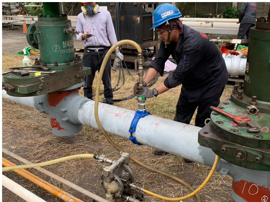
11. 阻斷後進行排油作業
