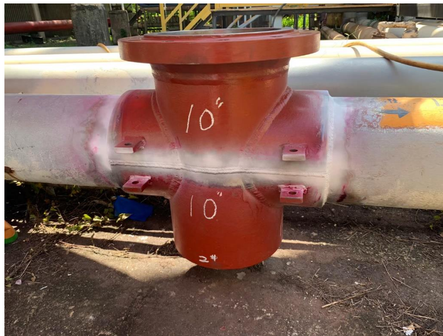
4. 焊道 PT 檢查
