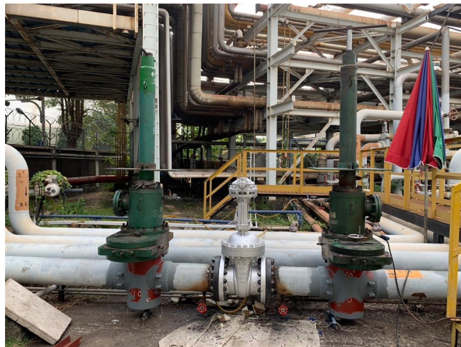
14. 管線增設閥件完成
