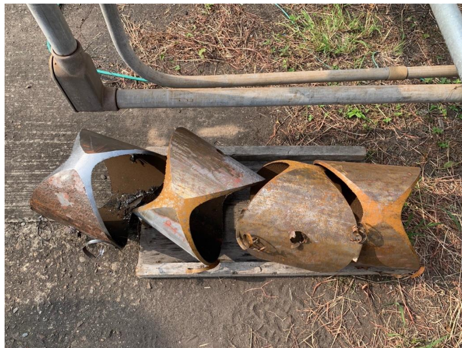
8. 斷管完成確認料塊取出
