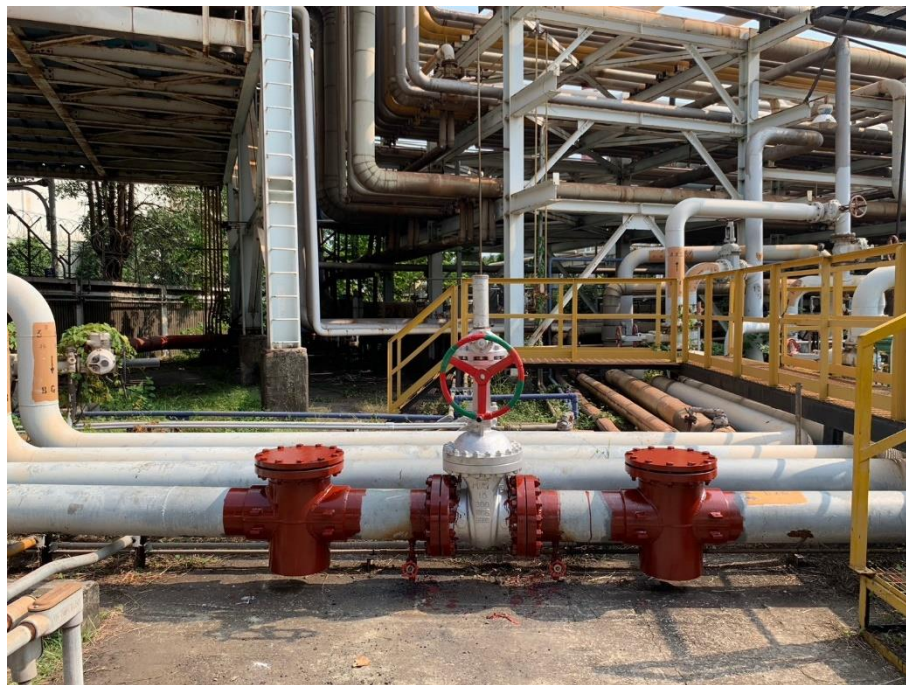
16. 施工完成油漆作業
