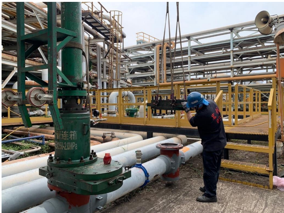
5. 閥件及開孔機具安裝作業
