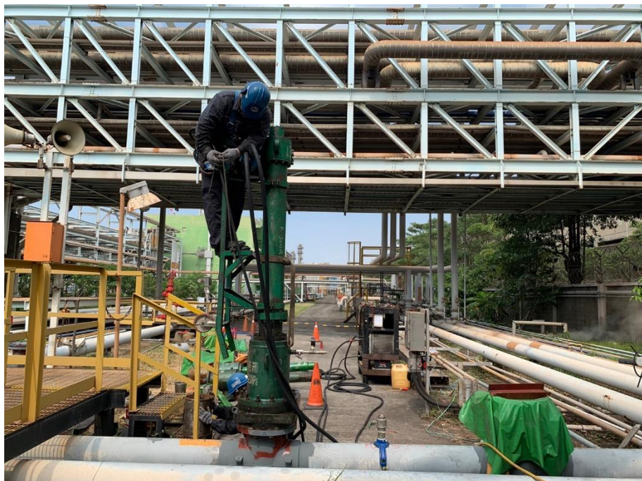
7. 人員執行斷管作業
