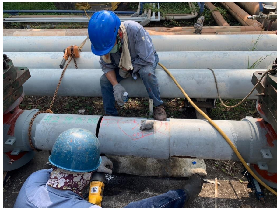
12. 管線切管作業
