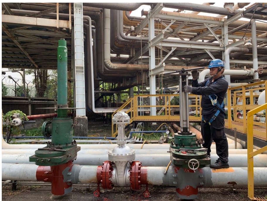
15. 管線進行下堵作業
