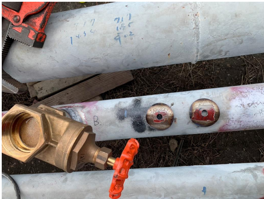
9. 開孔完成確認鐵片取出
