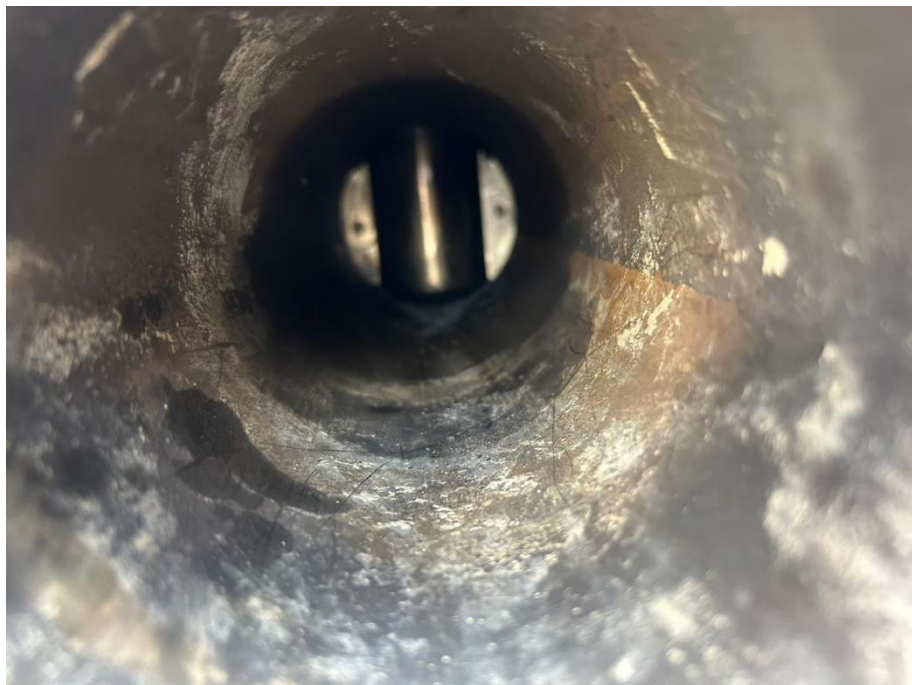
13. 切管後管內阻斷情形，阻斷率 99%
