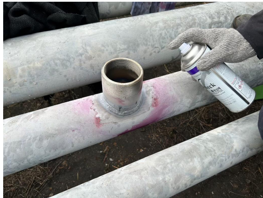
2. 焊道 PT 檢查
