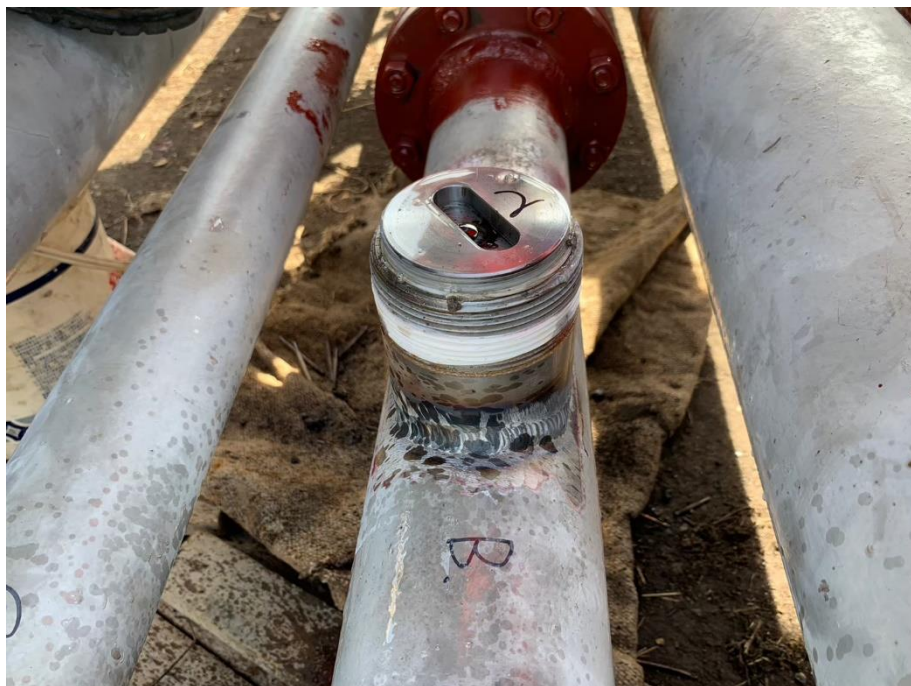
15. 管線進行下堵作業
