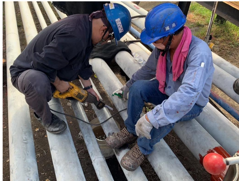
12. 管線切管作業
