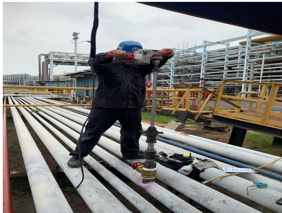
8. 人員執行開孔作業
