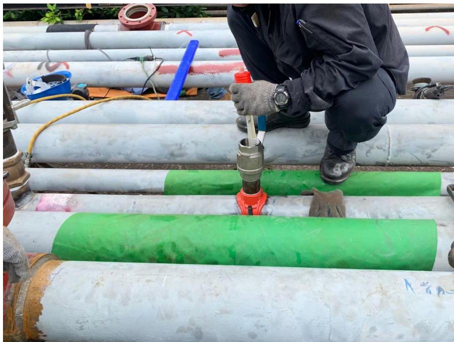
11. 管線內部油品抽油作業
