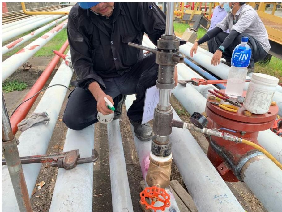
5. 閥件及開孔機具安裝作業
