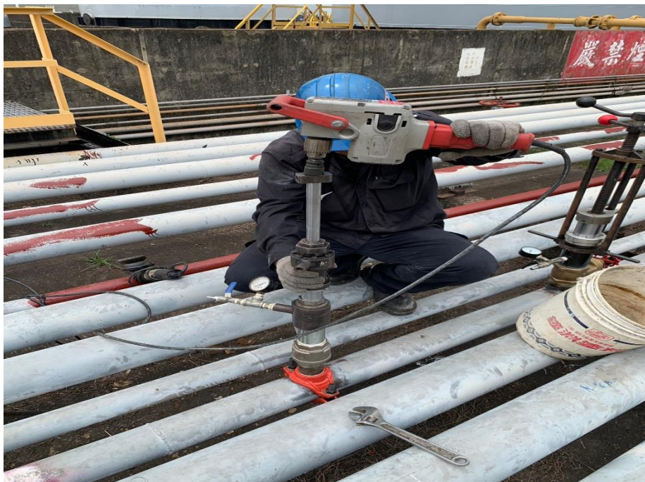
7. 排油開孔作業
