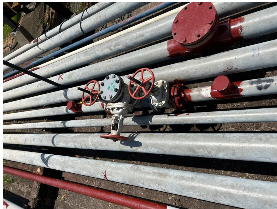
16. 施工完成油漆作業
