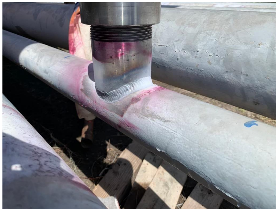
2. 焊道 PT 檢查
