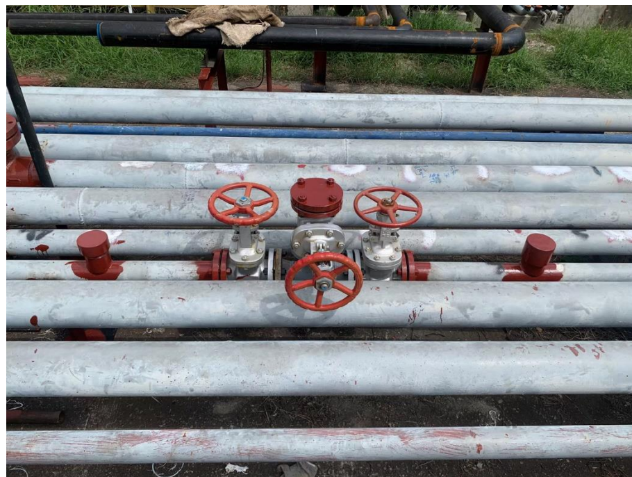
16. 施工完成油漆作業
