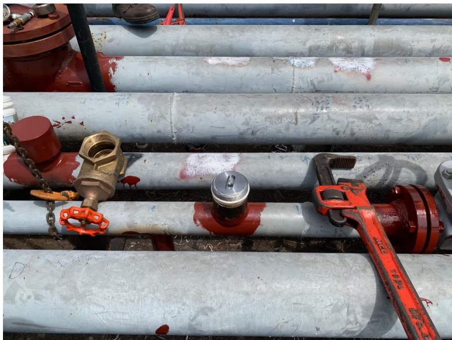
15. 管線進行下堵作業
