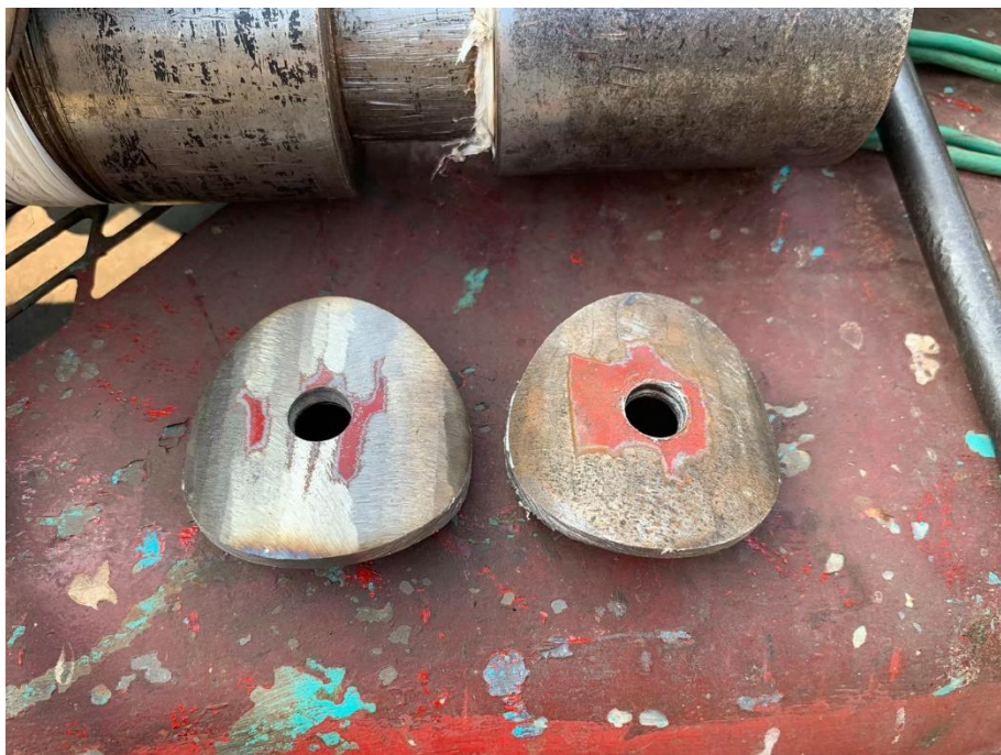
9. 開孔完成確認鐵片取出
