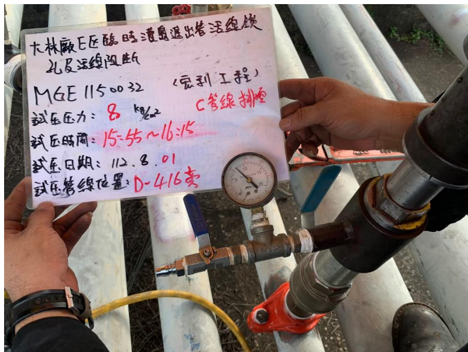
7. 試壓後排油開孔作業
