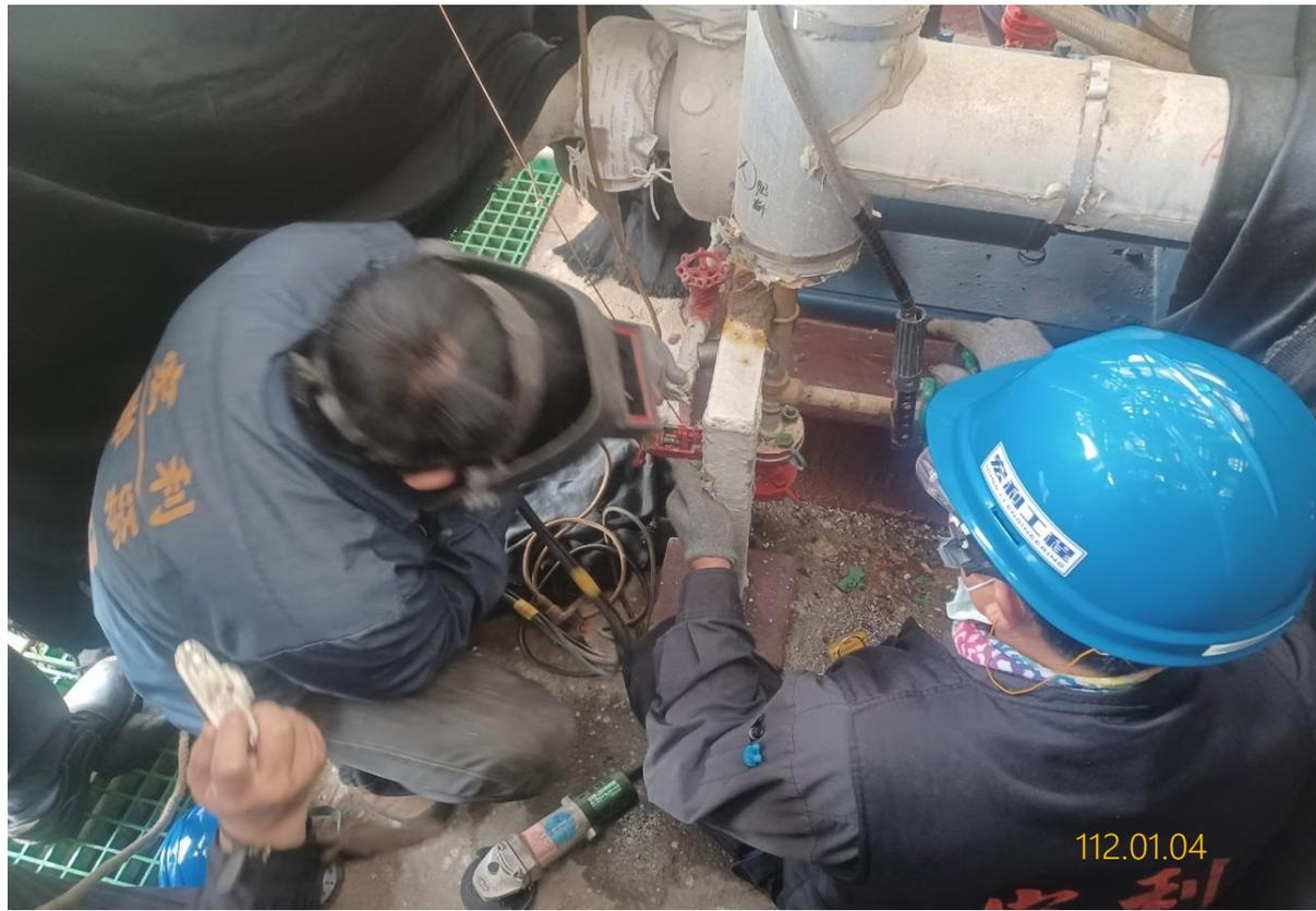
13. 模具焊接及管線溫度測量作業
