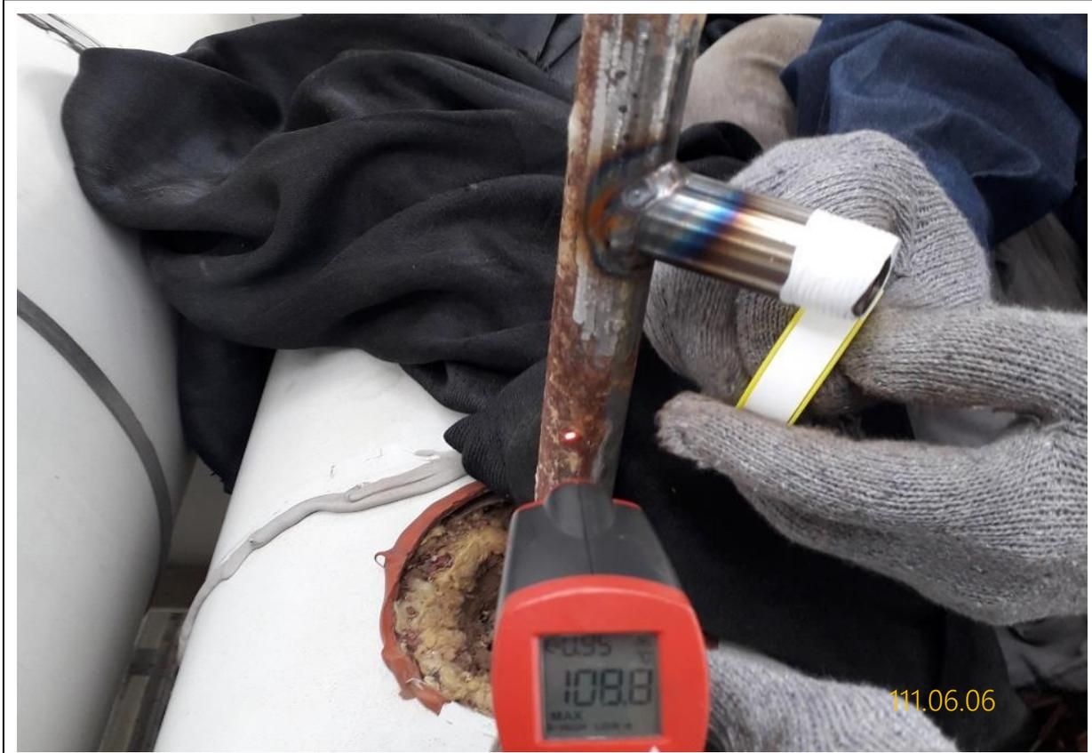
3. 模具焊接及管線溫度測量作業
