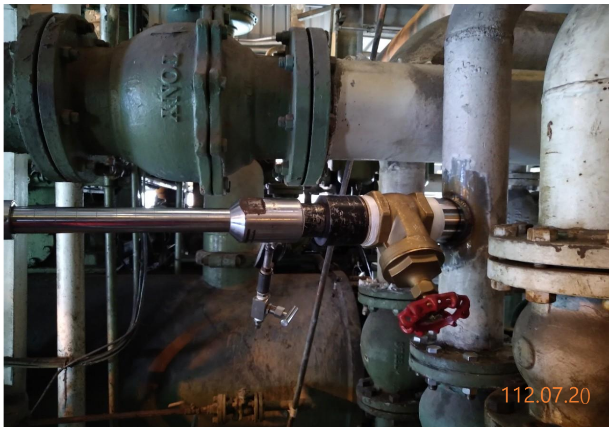
3.人員安裝閥件及開孔機具
