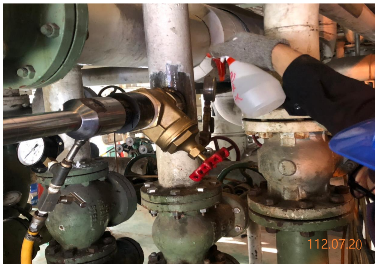
4.試壓抓漏作業
