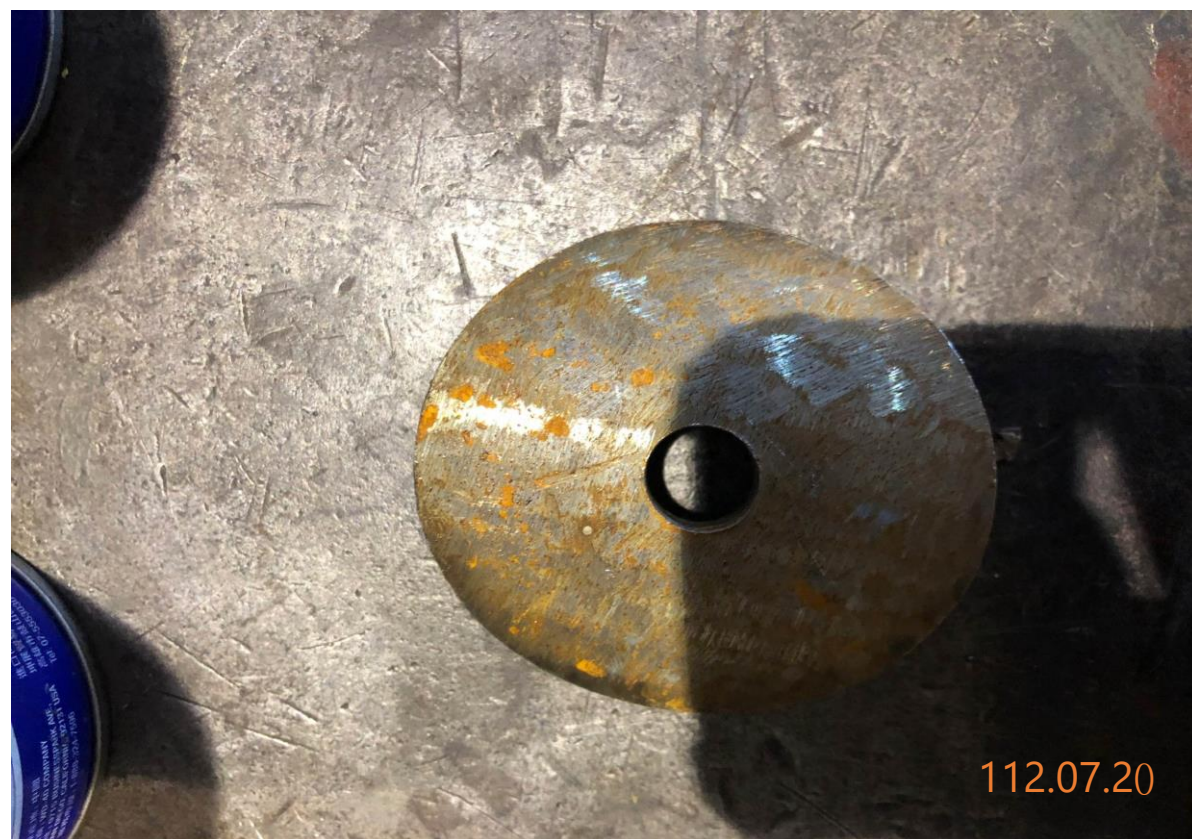
6. 開孔完成確認鐵片取出
