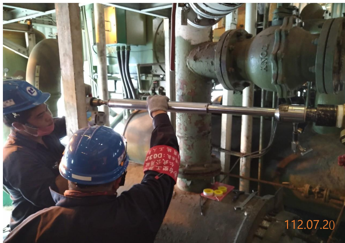
5. 人員進行開孔作業
