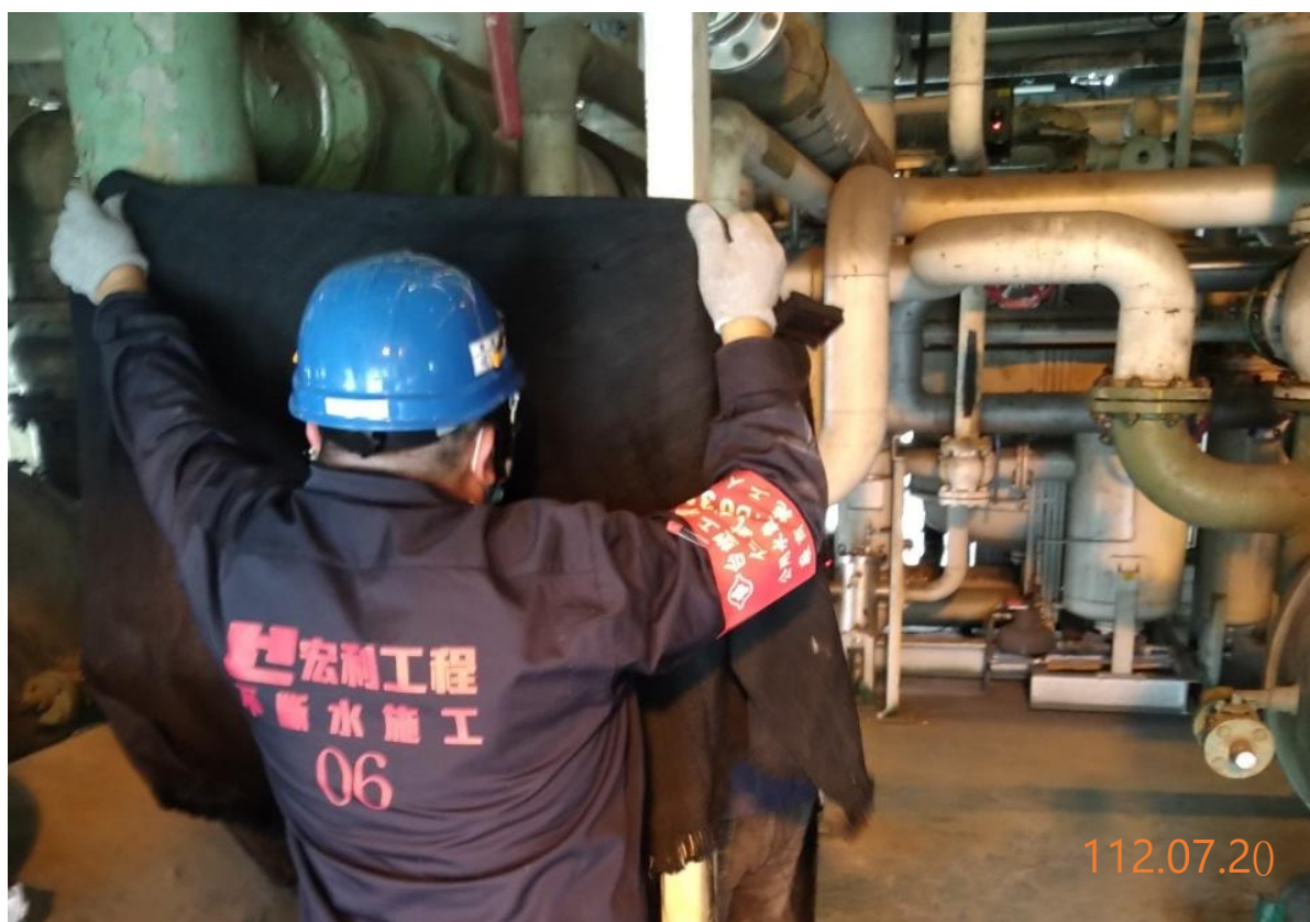
2. 施工位置防火毯鋪設情形
