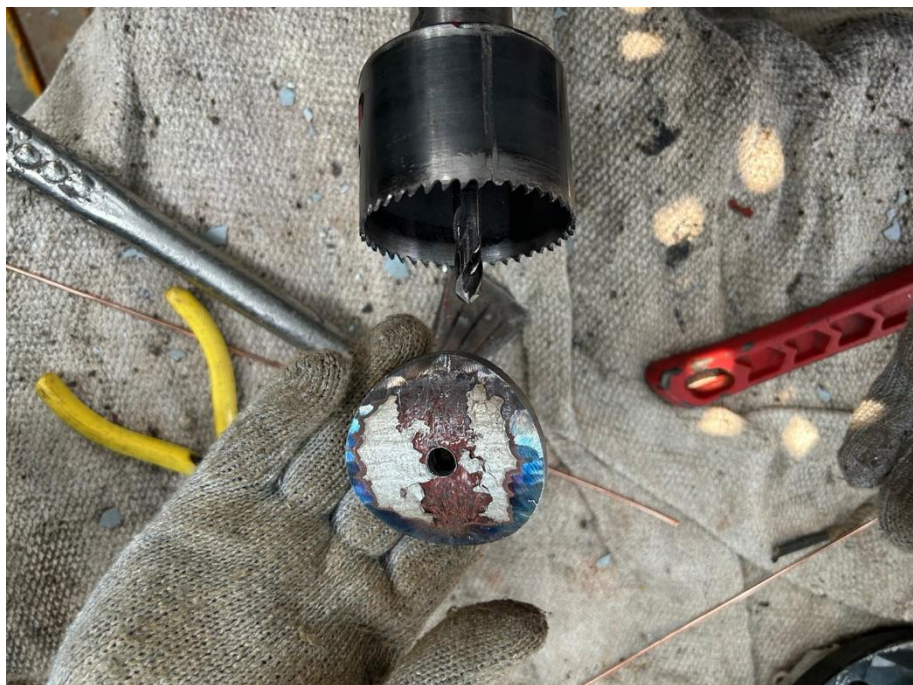
11. 開孔完成確認鐵片取出(4'')
