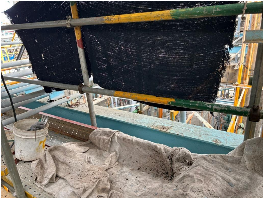
3. 防火毯鋪設情形
