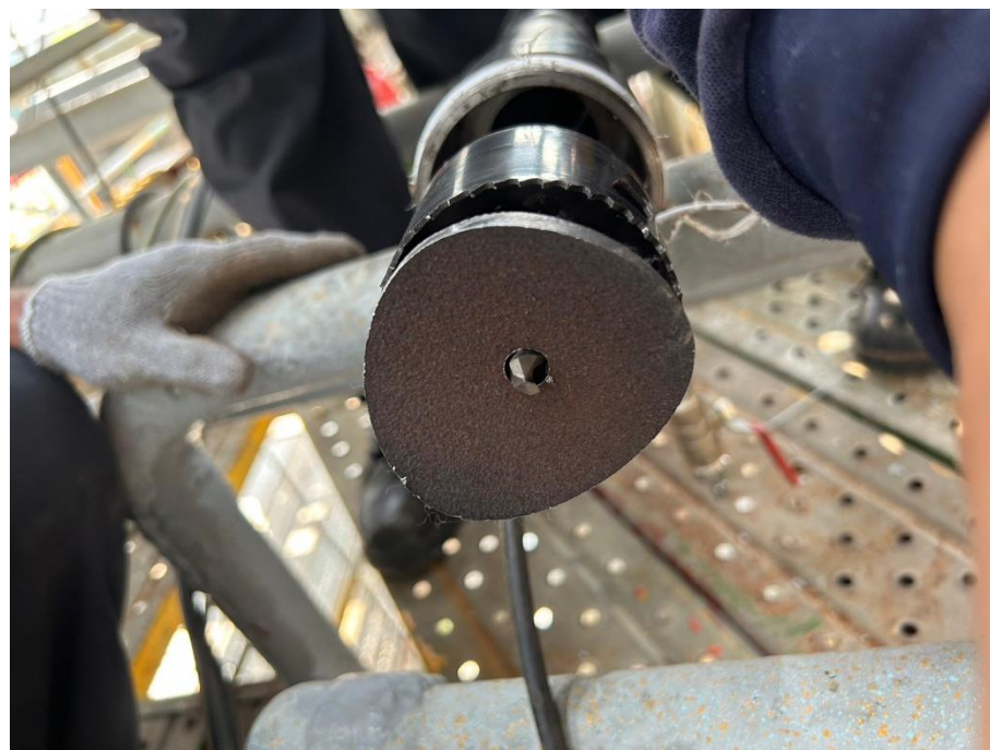
10. 開孔完成確認鐵片取出(4")
