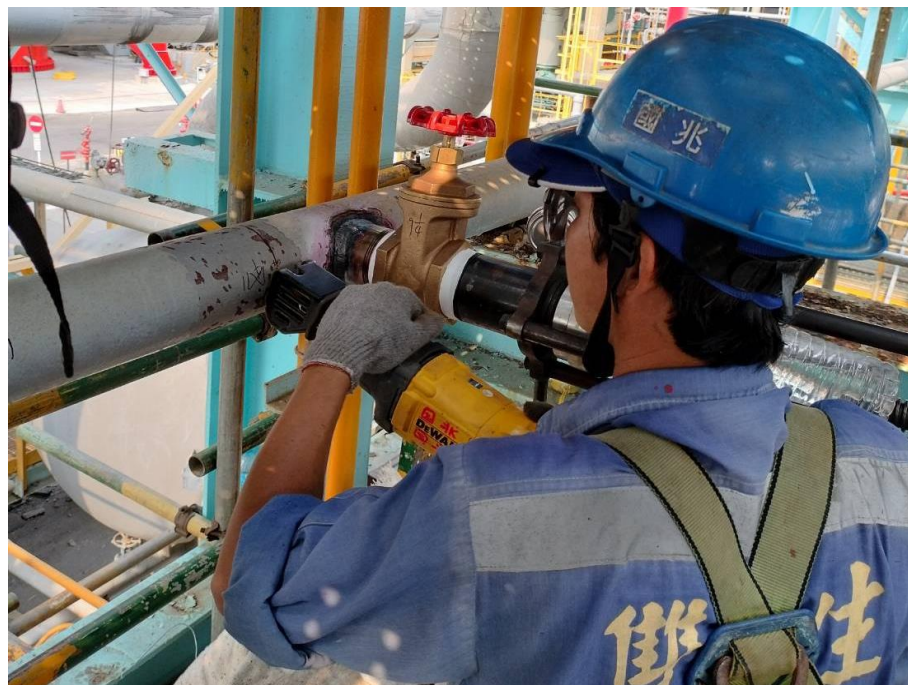
14. 排壓完成進行切管作業
