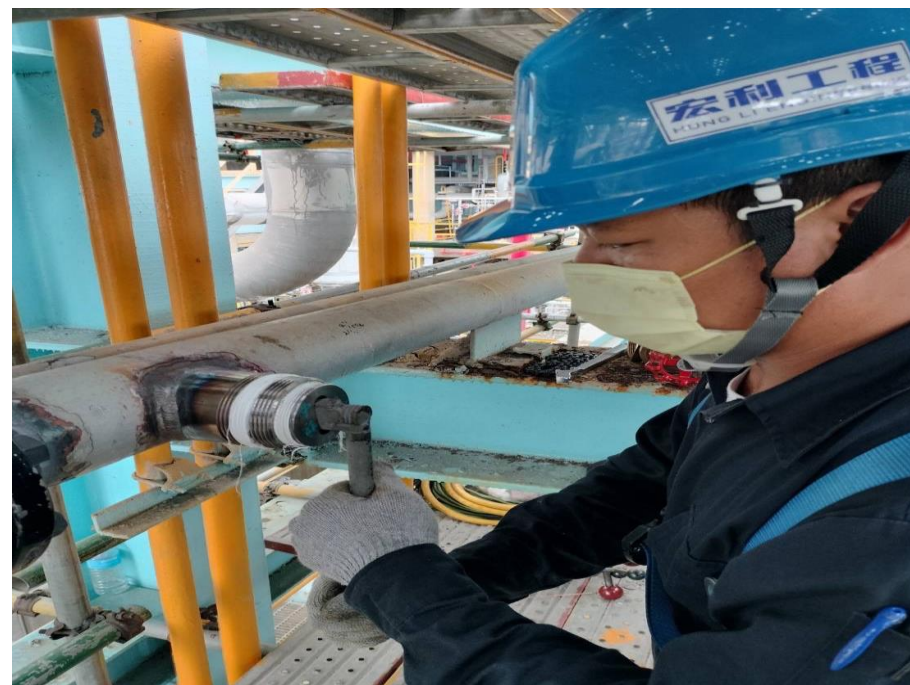
18. 施工完成安裝內盲蓋
