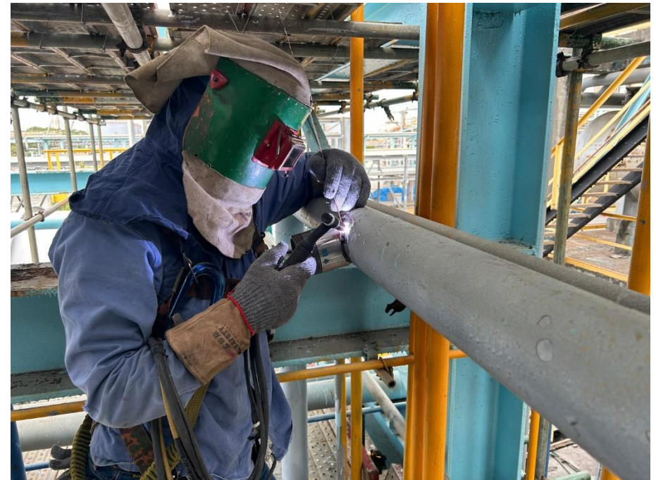
4. 阻斷模具焊接作業
