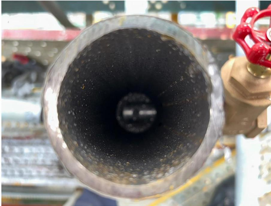
15. 管線切管後管內阻斷情形，阻斷率 99%
