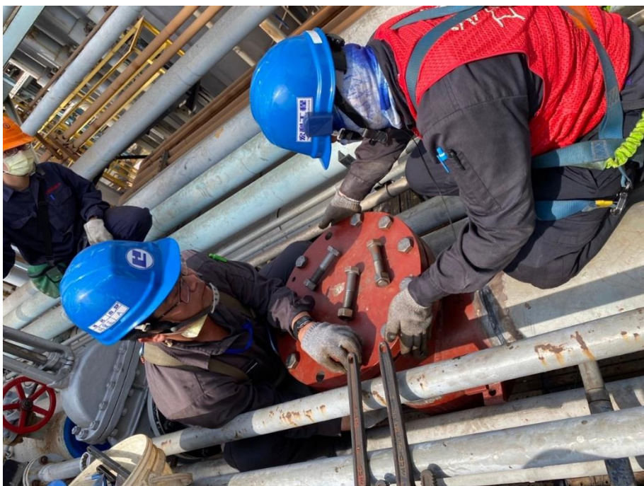
17. 施工完成安裝盲法蘭
