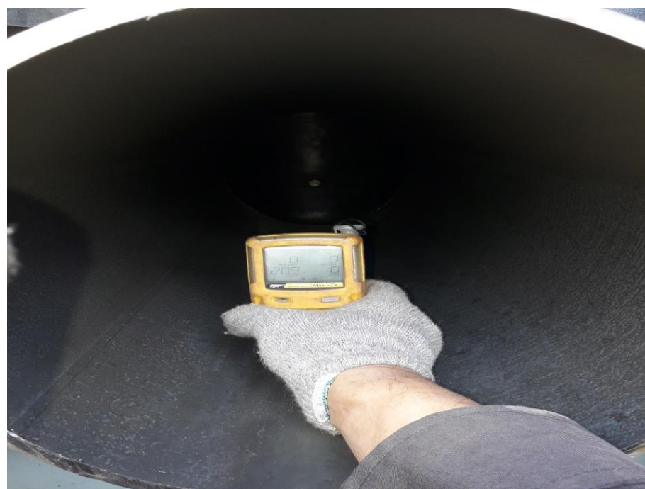
12. 阻斷切管後，檢測 LNG 是否阻斷完成
