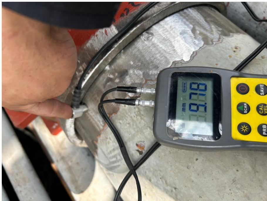
1. 管線施工前測厚確認
