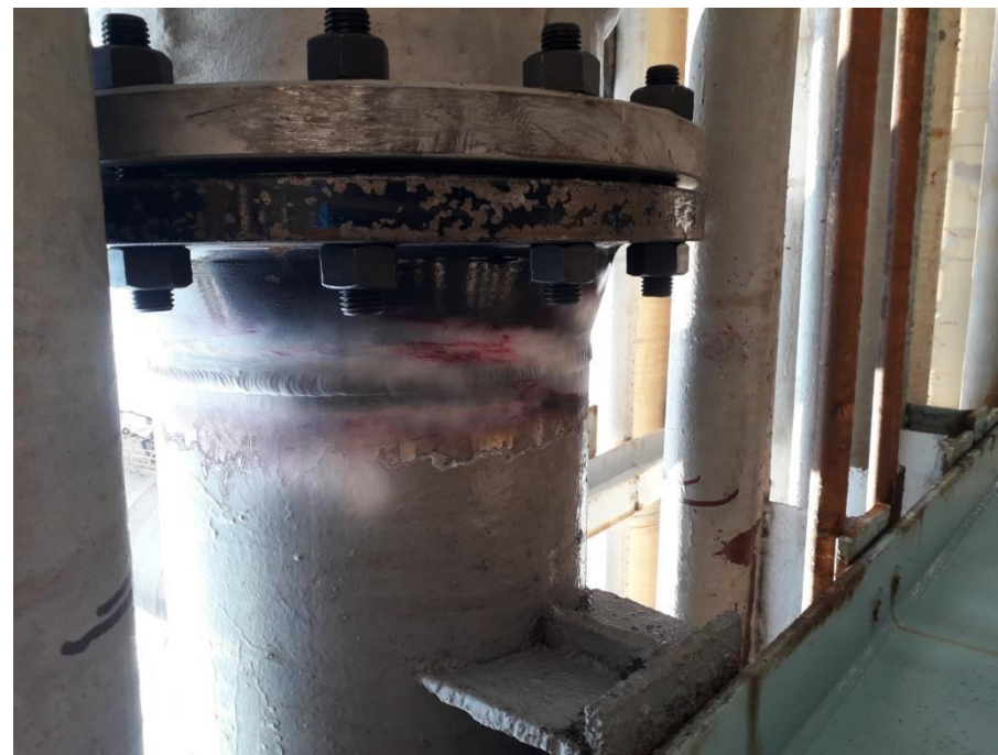
14. 切管後法蘭焊接作業
