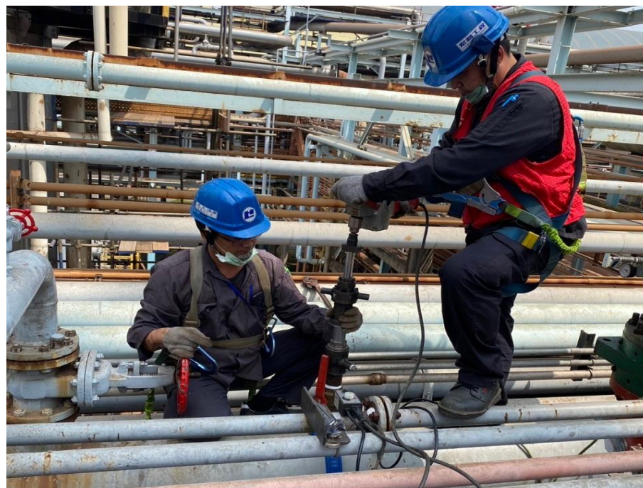
10. 排氣及 PURGE 氮氣位置開孔作業
