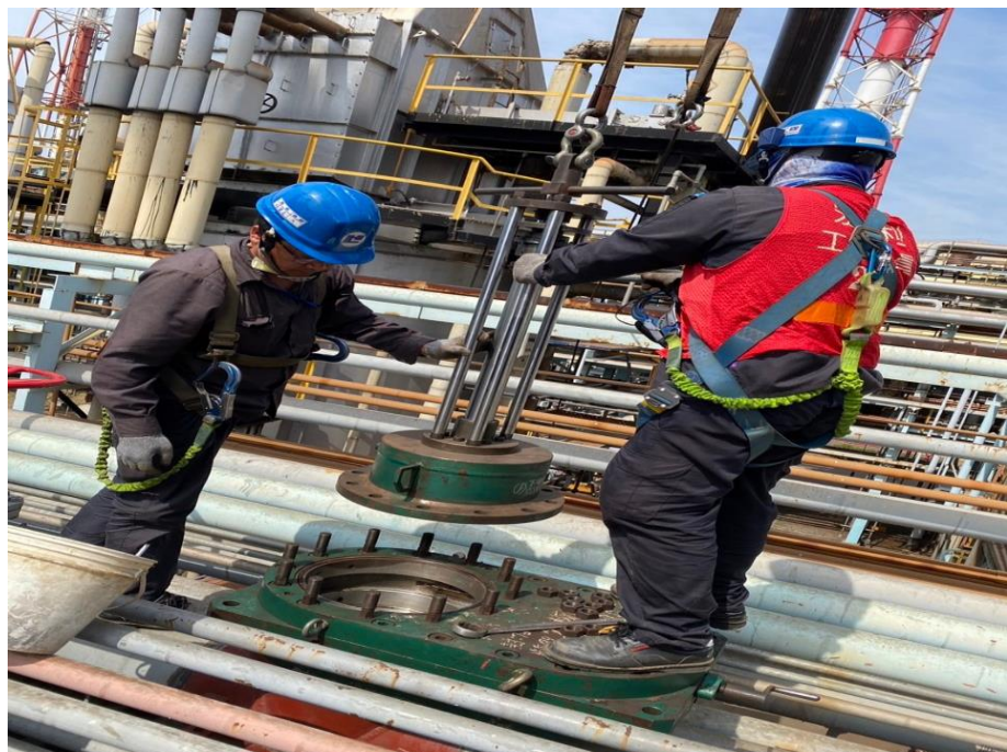
15. 管線安裝下堵情形
