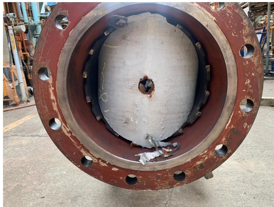
8. 斷管完成確認料塊取出
