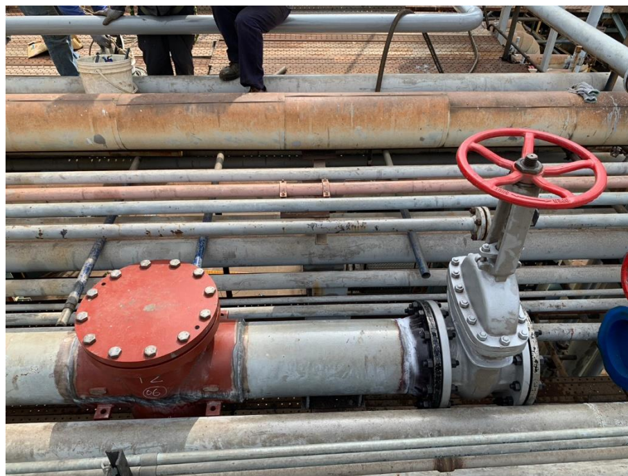
18. 12" LNG 管線阻斷增設閥件作業完成
