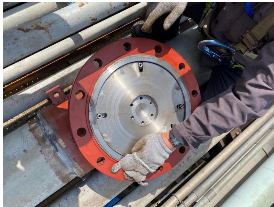
16. 夾板閥移除，安裝內塞頭完成
