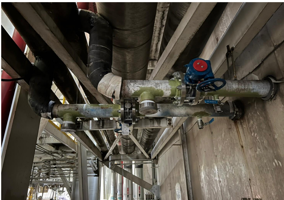
10. 施工完成，管線進回水雙阻斷作業增設閥件及排液完成
