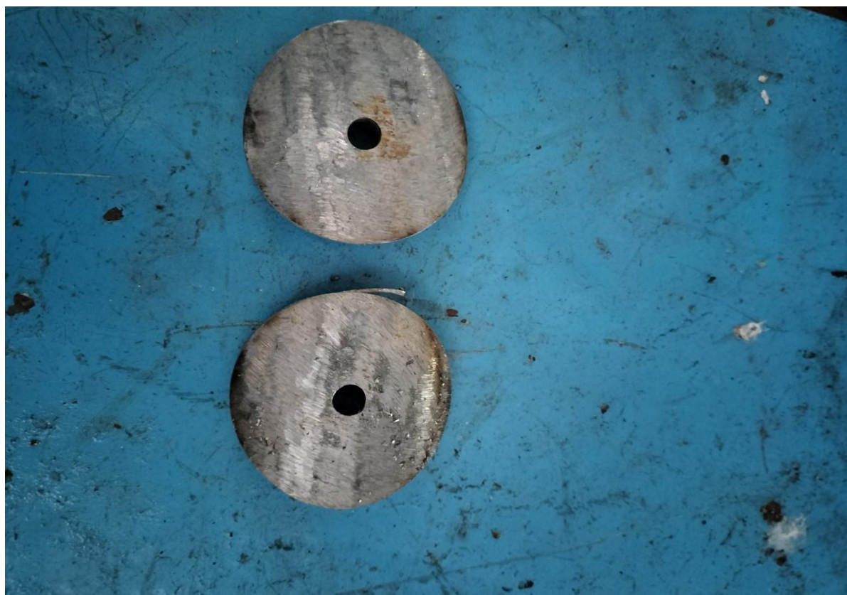
6. 開孔完成確認鐵片取出
