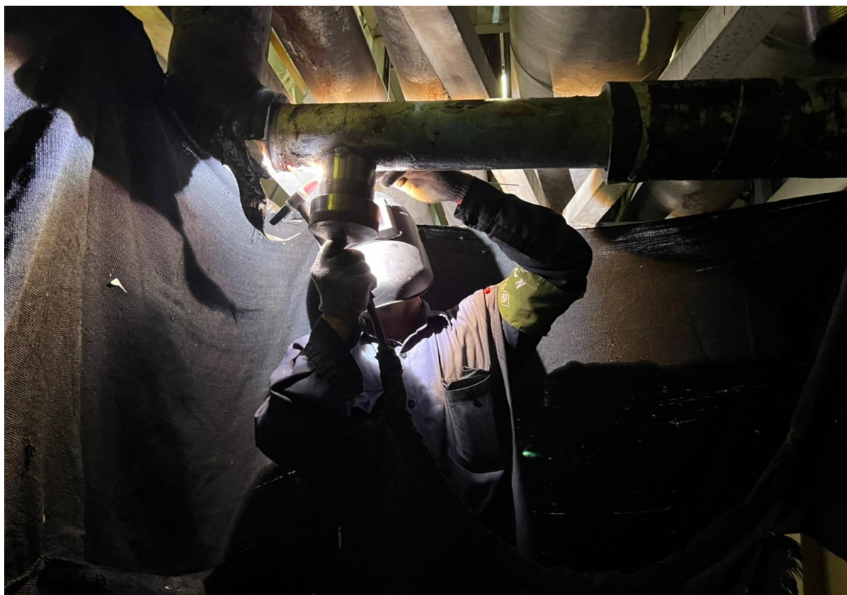
3. 模具焊接作業
