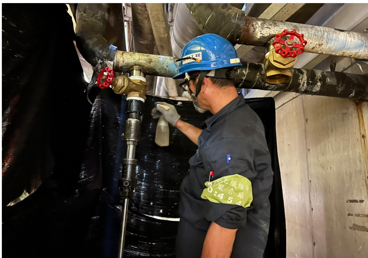
4. 焊接完成後人員安裝開孔機具並試壓
