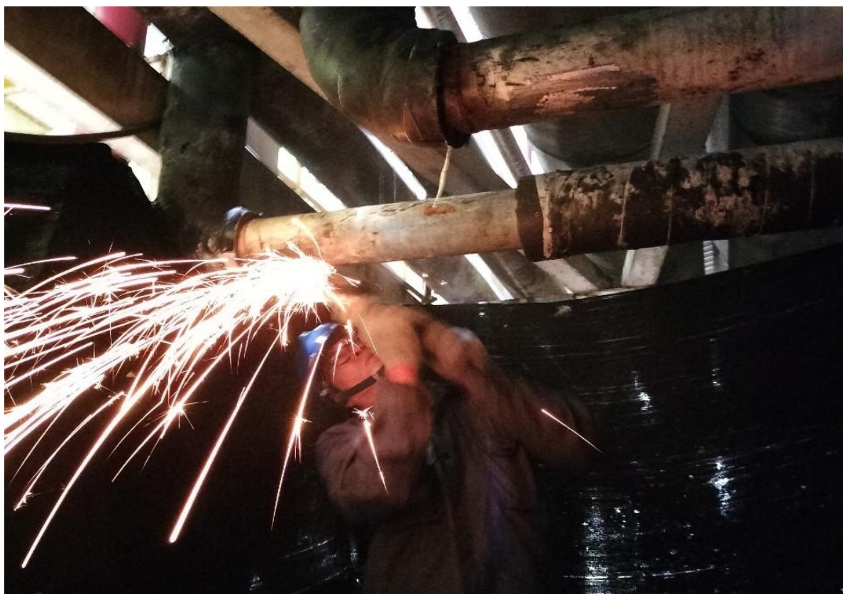
2. 施工位置研磨及防火毯鋪設情形
