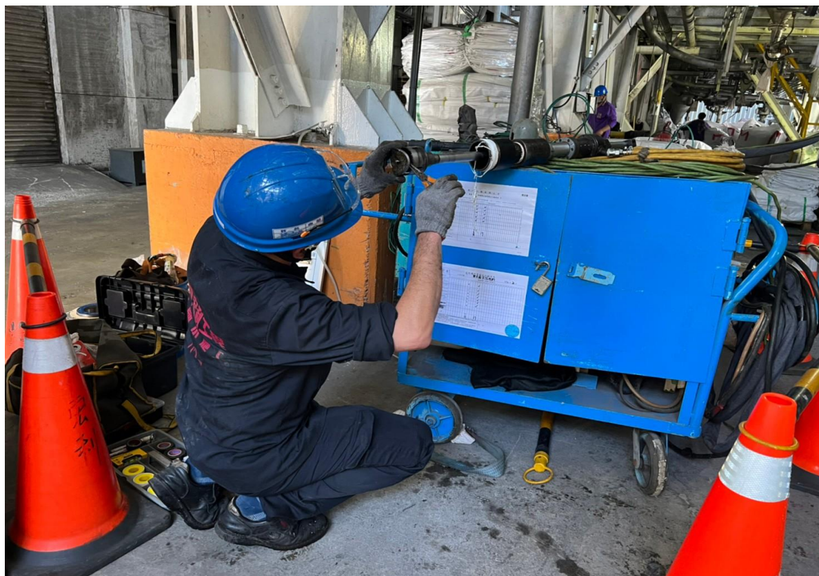
5. 開孔作業後確認鐵片取出
