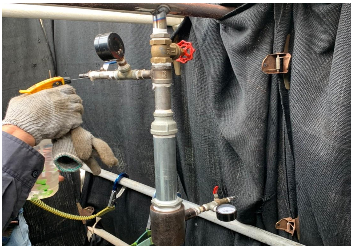
9. 人員安裝開孔機後進行試壓作業
