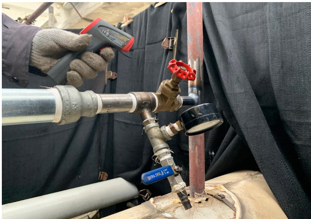
1. 機具及閘閥安裝後試壓作業
