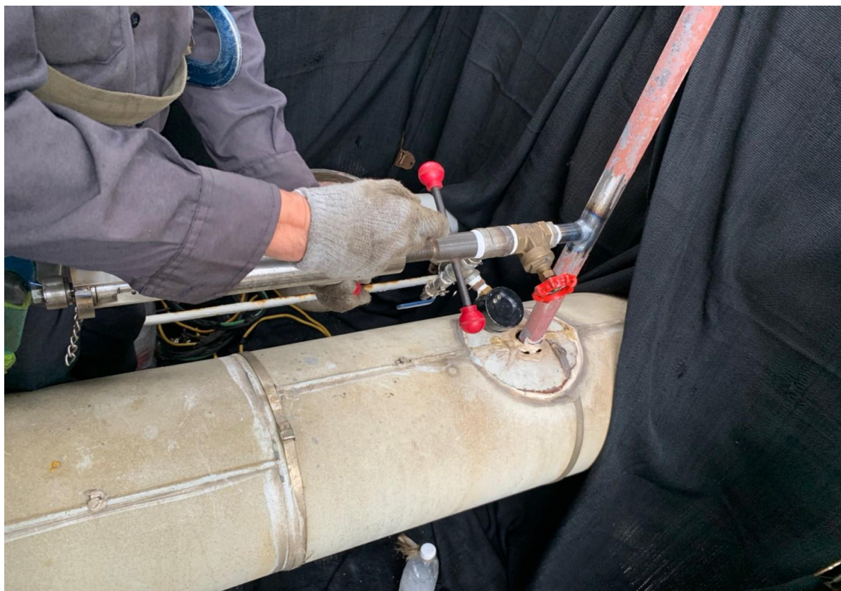
3. 安裝阻斷器進行阻斷作業
