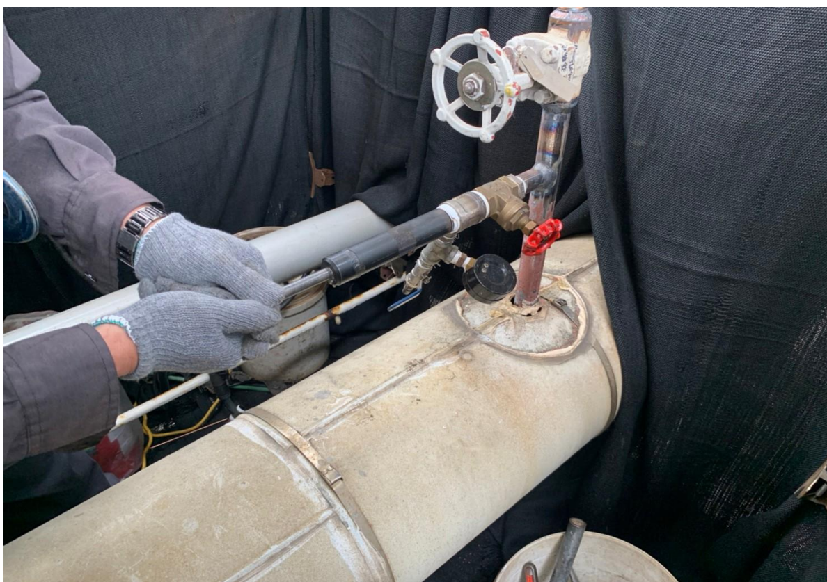
6. 閥件增設後人員進行下堵作業
