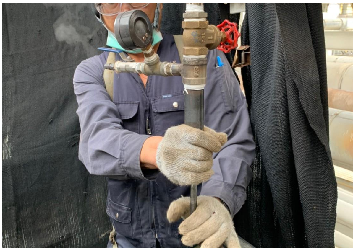
13. 人員進行下堵作業
