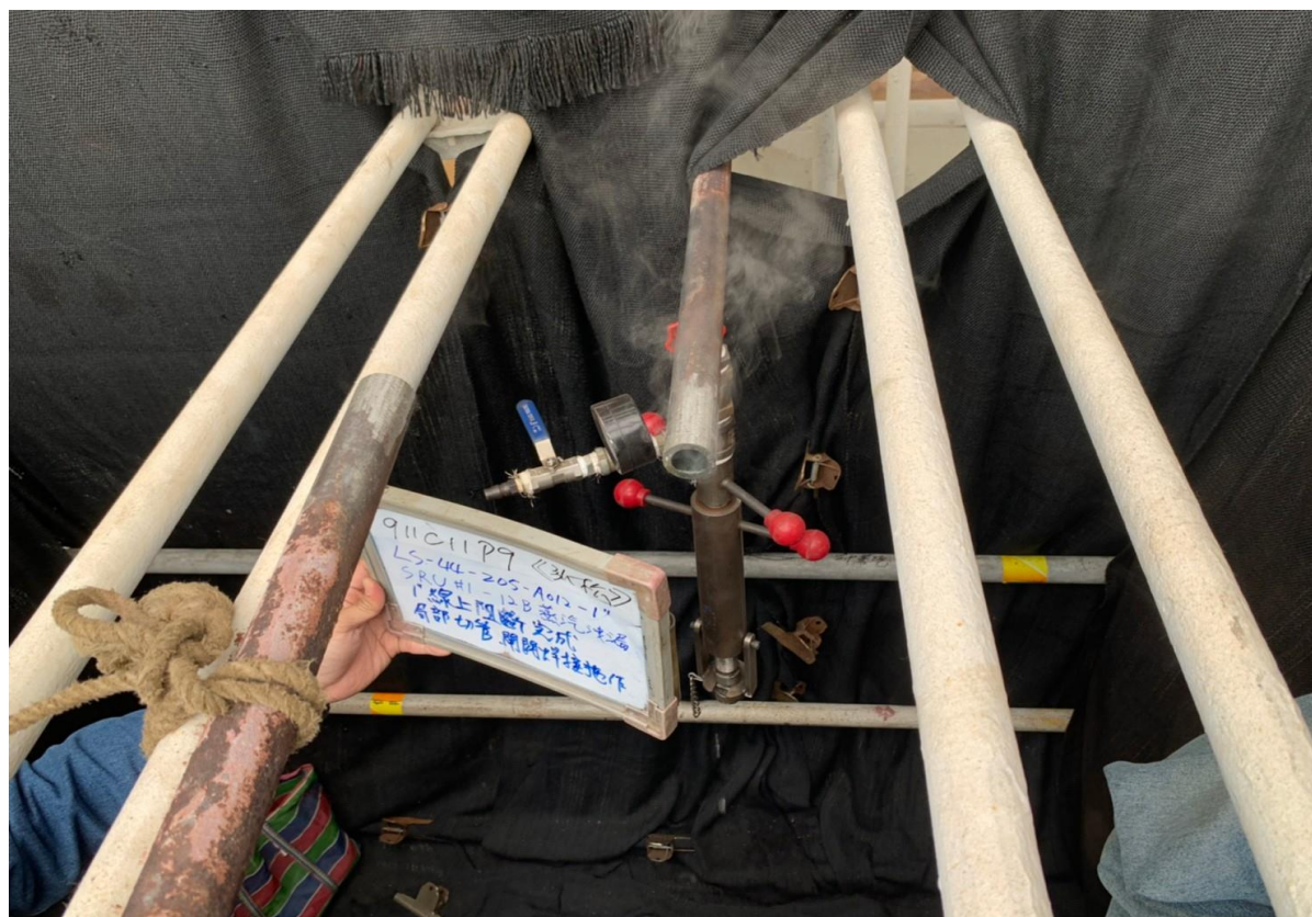
12. 排壓確認後人員切管作業
