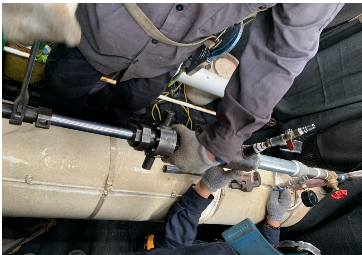
2. 人員進行開孔作業
