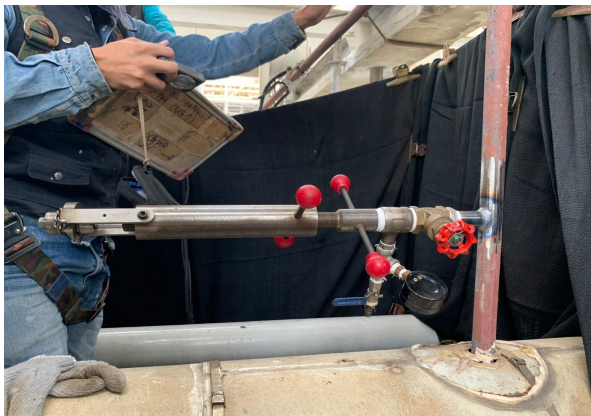
4. 管線末端排壓確認排空情形
