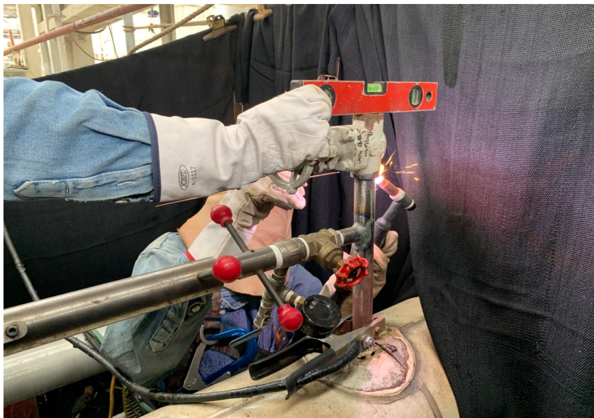
5. 管線切管後增設閥件作業
