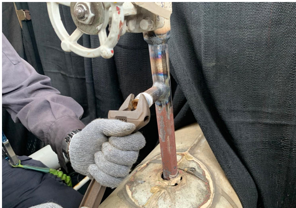
7.人員安裝內塞頭作業
